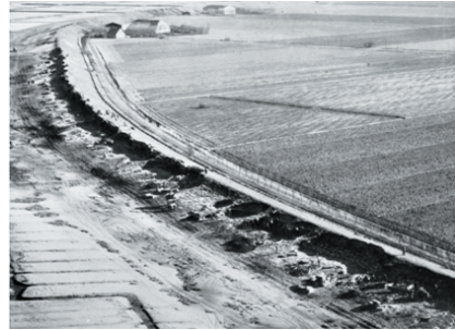
Sturmflut 1962, beschädigte Deichstrecke bei Friedrichskoog in Dithmarschen (Petersen und Rohde, 1991)
