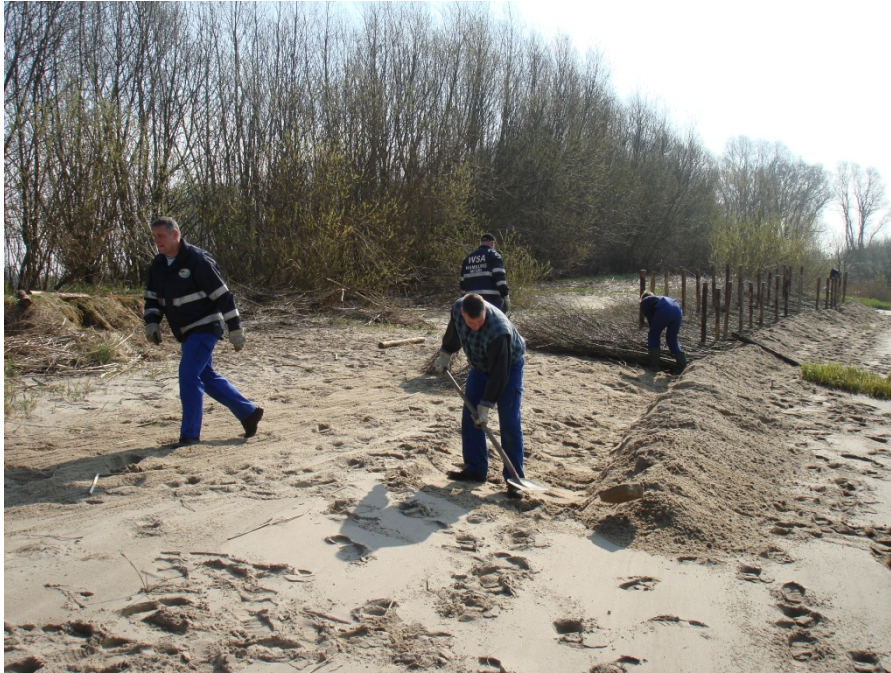
Abbildung 15: Bau einer Fußsicherung mit Spreitlagen aus Faschinen am Abschnitt 2
