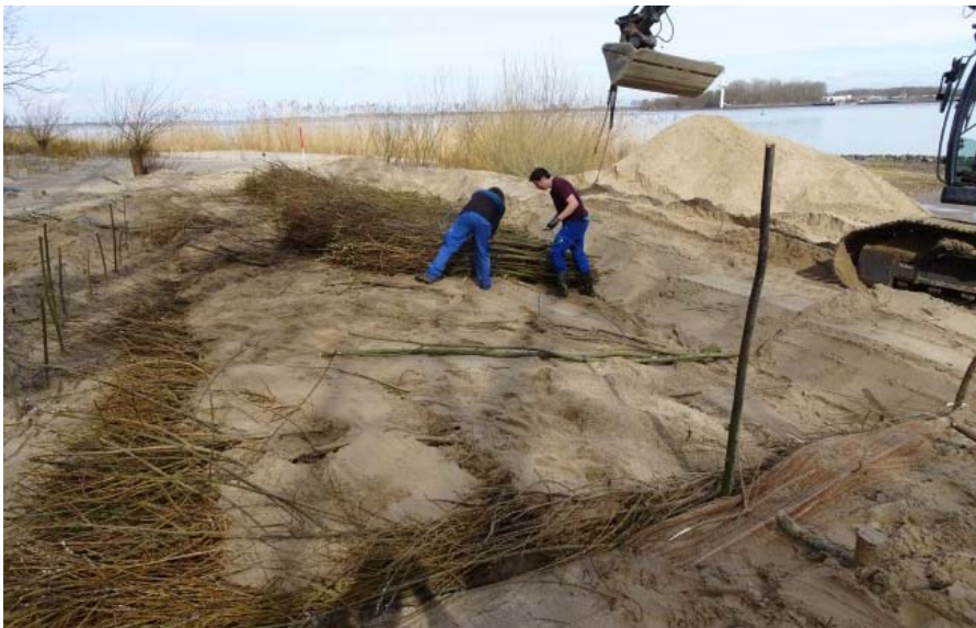
Abbildung 31: Überdecken der Lagen mit Sand
