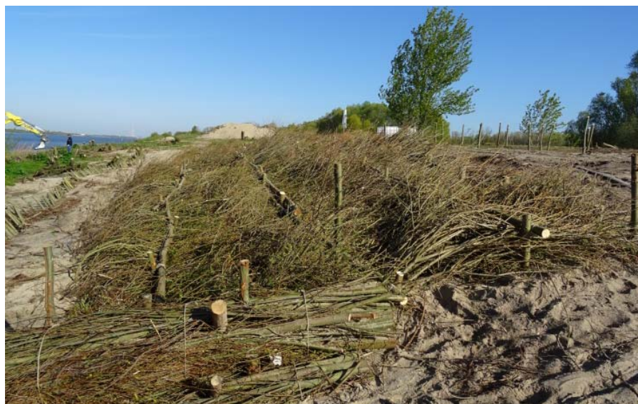
Abbildung 25: Überlappende Weidenreiser, fixiert mit Weidenpfählen und Riegelhölzern aus Weiden
