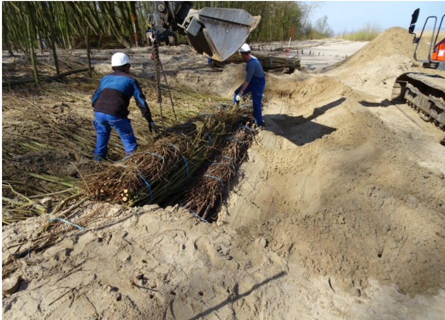
Abbildung 32: Verlegen der Fußsicherung
