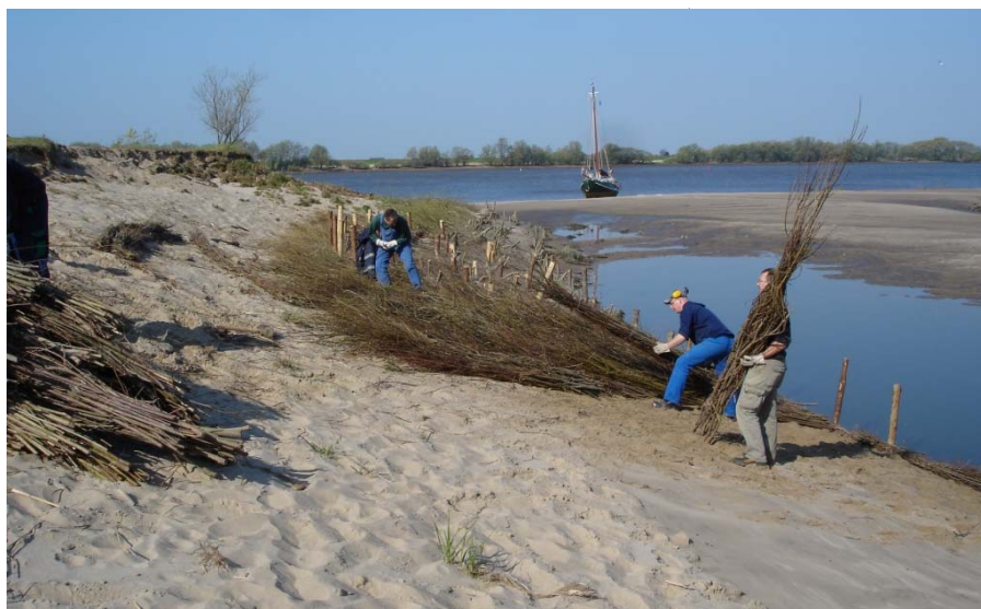
Abbildung 10: Legen der Spreitlage aus Faschinen, ausgehend vom mittleren Tideniedrigwasser bis etwa 1,5 m über dem mittleren Tidehochwasser
