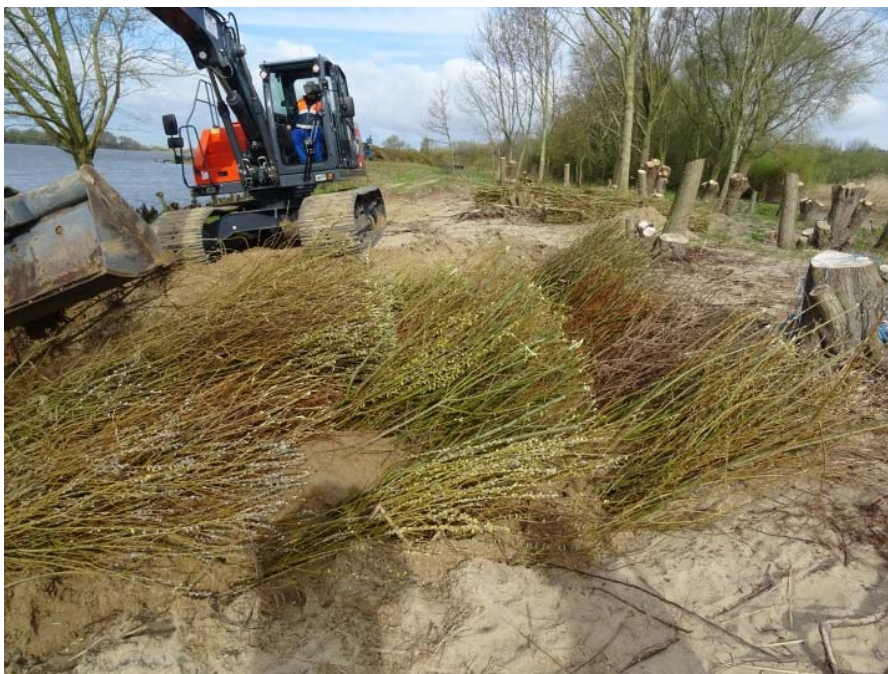
Abbildung 18: Verlegene der Weidenreiser in sich überlappenden Lagen
