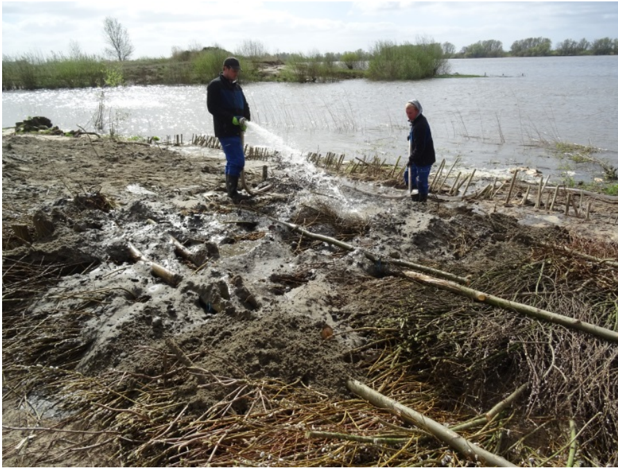
Abbildung 19: Fixierte Weidenreiser durch Weidenpfähle sowie Ansanden der Fläche
