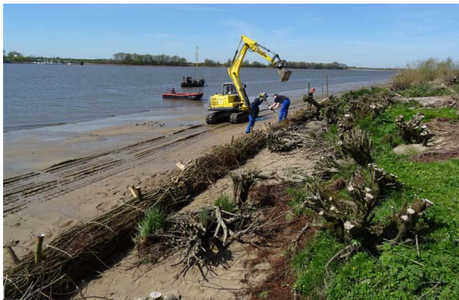
Abbildung 24: Verlegen der Fußsicherung aus Faschinenwalzen, vernagelt an Pfählen
