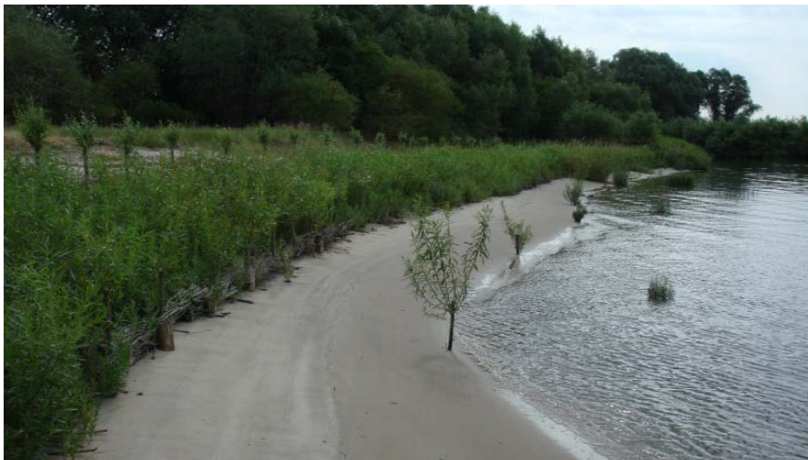
Abbildung 16: Aufwuchs am Abschnitt 2 nach 3 Monaten, am unteren Rand ist die doppelreihige Pfehlwand mit den Faschinenwalzen erkennbar, am oberen Rand der Maßnahme die austreibenden Weidenpflöcke (Kopfwiden)
