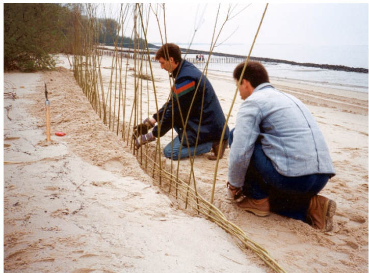
Abbildung 5: Technisch-biologische Ufersicherung mit Weidenstecklingen Anfang der 90er Jahre
