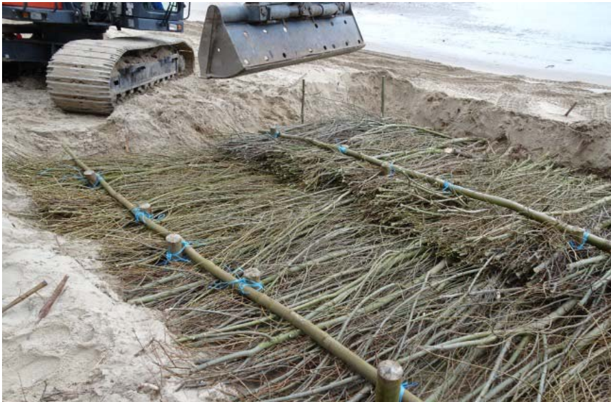
Abbildung 30: Weidenreiser, fixiert durch Riegelhölzer aus Weiden
