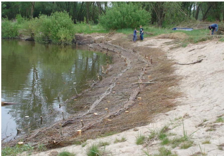
Abbildung 11: Spreitlage aus Faschinen, befestigt durch Faschinenwippen, Pfähle und Verdrahtung
