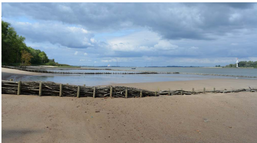
Abbildung 27: Lahnungen mit vorgelagertem Steindamm
