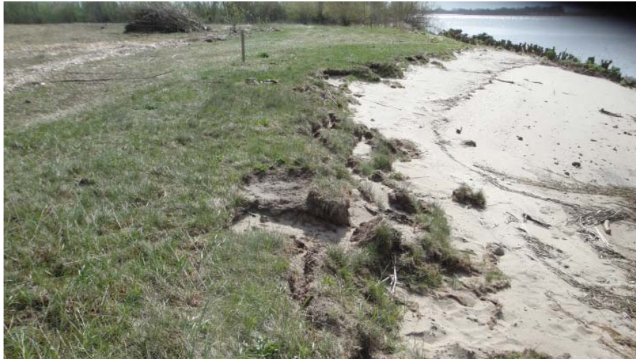
Abbildung 23: Uferabbruch infolge einer Sturmflut im
