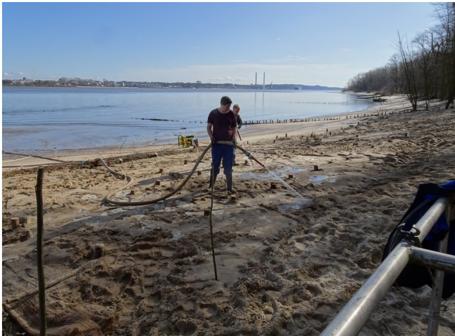
Abbildung 33: Einschlämmen der Fläche
