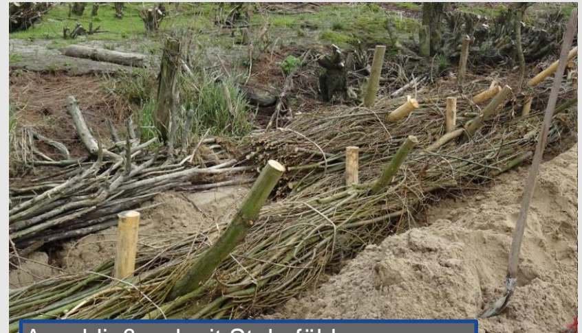
Anschließend mit Stakpfählen vernagelt
