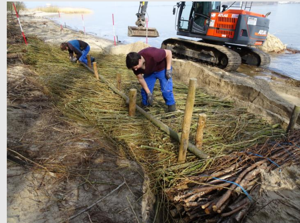
Verbindung der Riegel mit den Pfählen
