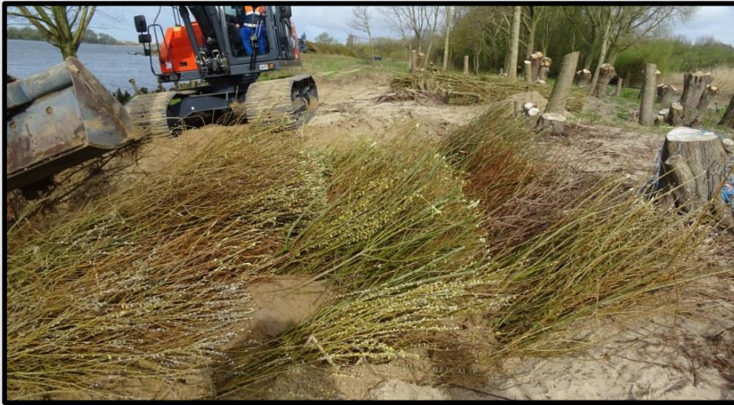
Verlegte Spreitlage vor dem vernageln mit Riegelhölzern
