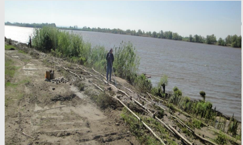
einschleppen der fertigen Spreitlage
