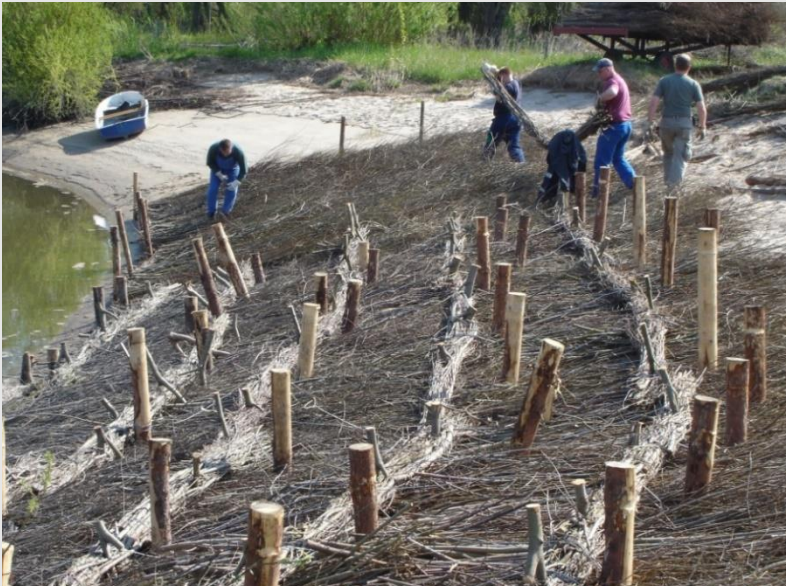
Herstellung mit Fixierung mittels Wippen (2005)
