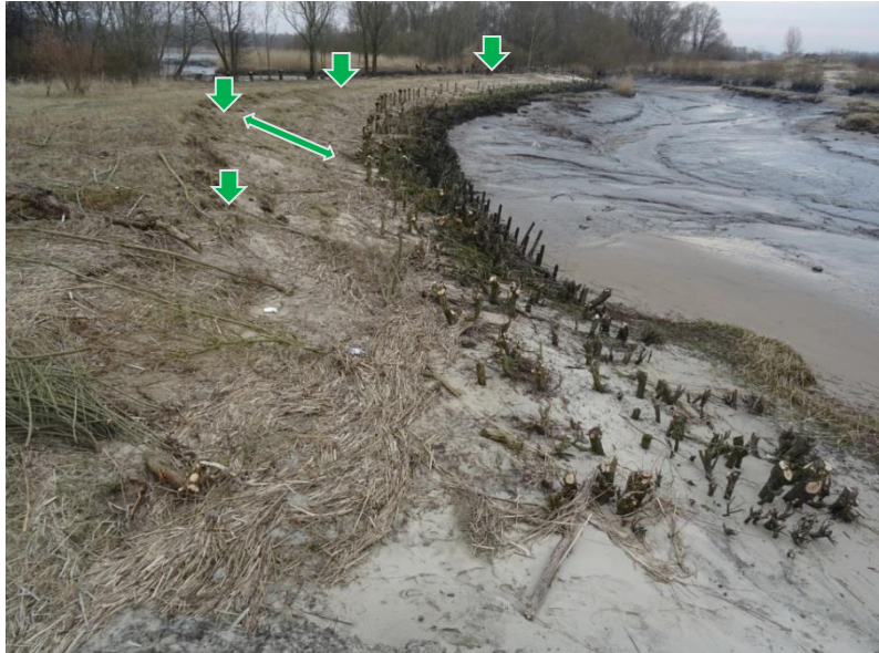
Geplanter Uferbereich, Sicherung oberhalb der vorhandenen Fußsicherung
