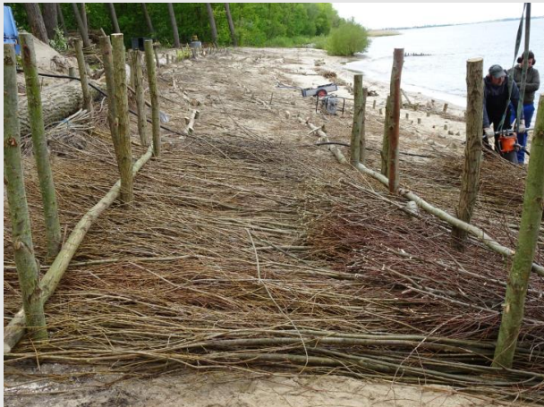
Fixierpfähle und Riegelstangen verlegt
