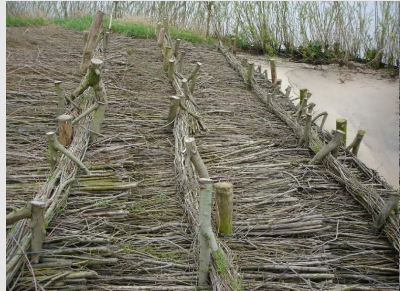
Fertig hergestellte Spreitlage
