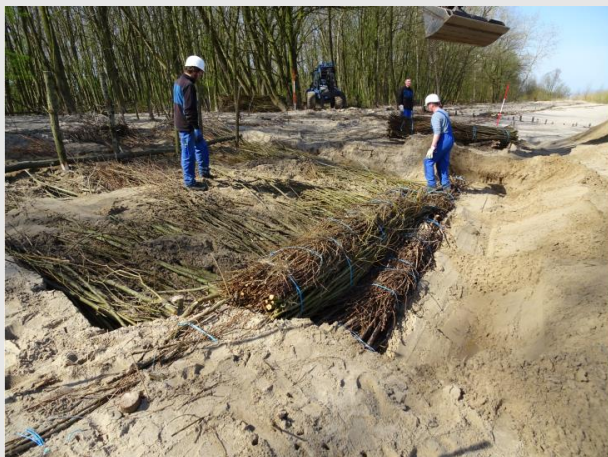
Eingebaute Fußsicherung (2 x 60 cm Walzen)
