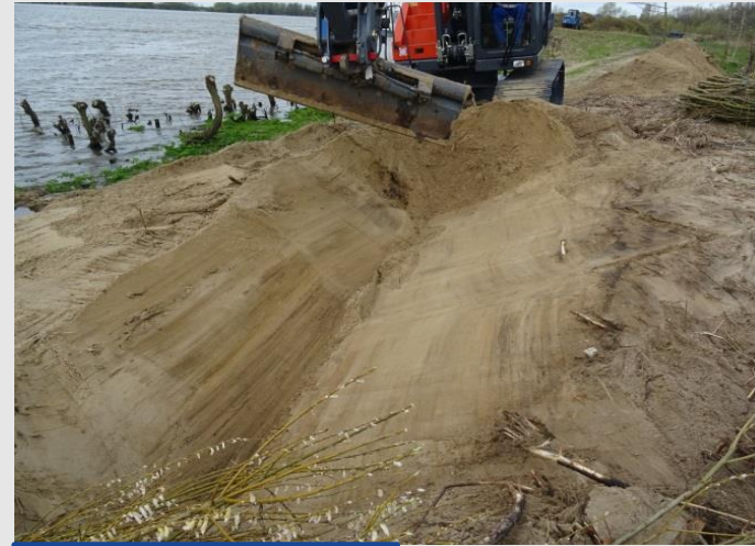
Profilierung des Ufers
