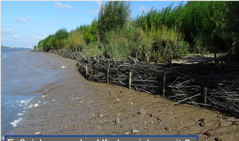
Fußsicherung des Uferbereiches mit 3 Lagen Buschwalzen
