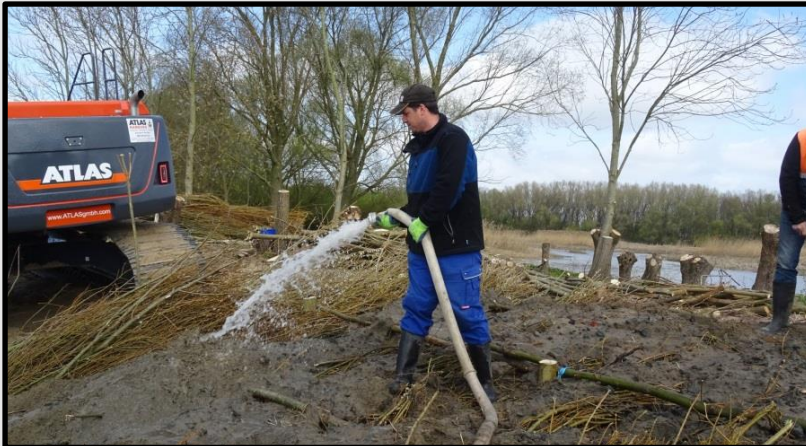
Wässern der mit Sand überdeckten Spreitlage
