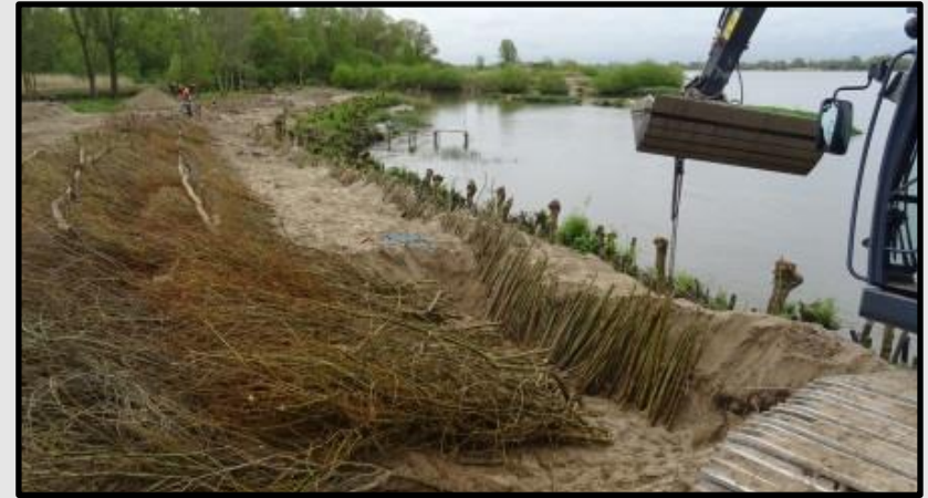
Verlegte Spreitlage wird mit Sand abgedeckt
