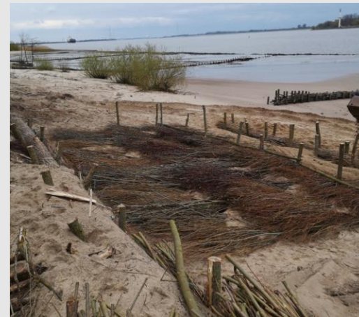
3-Lagig verlegte Spreitlage einschl. Fußsicherung
