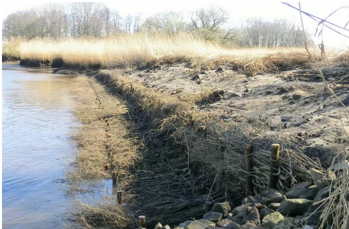
Foto nach Einbau (WSA Weser-Jade-Nordsee)
