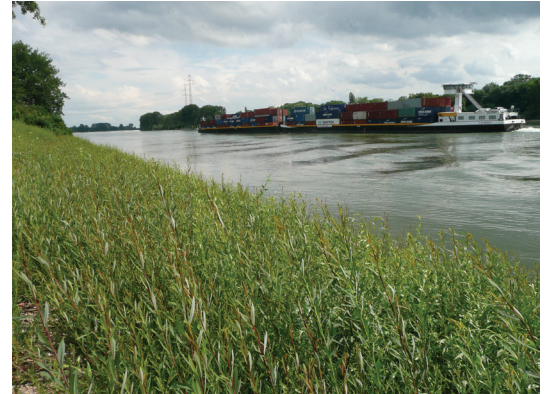
River Rhine, right bank, km 440,82 bis km 440,95 (willow brush mattresses)
