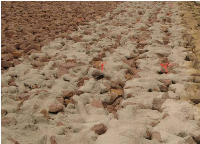
*Bild A4-5: Sachgerecht hergestelltes teilvergossenes Deckwerk (90 l/m<sup>2</sup>, LMB<sub>5/40</sub>, punktueller maschineller Einbau)*
