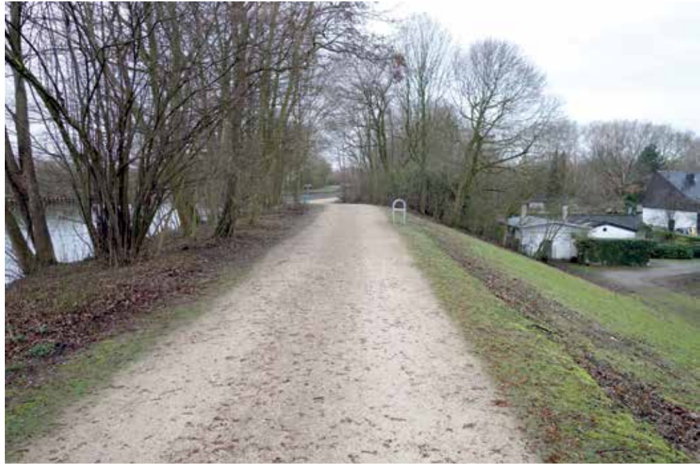
▲ Abb. 3 – Kanalseitendamm eines Kanals in Dammlage. Deutlich unterhalb der Wasserlinie befinden sich Wohngebäude, die bei einem Bauwerksversagen überflutet würden.
