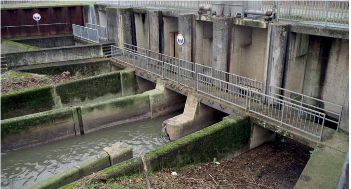
▲ Abb. 4 – Einlassbauwerk eines Dükers, welches für Verklausungen durch angeschwemmtes Gut anfällig ist.
