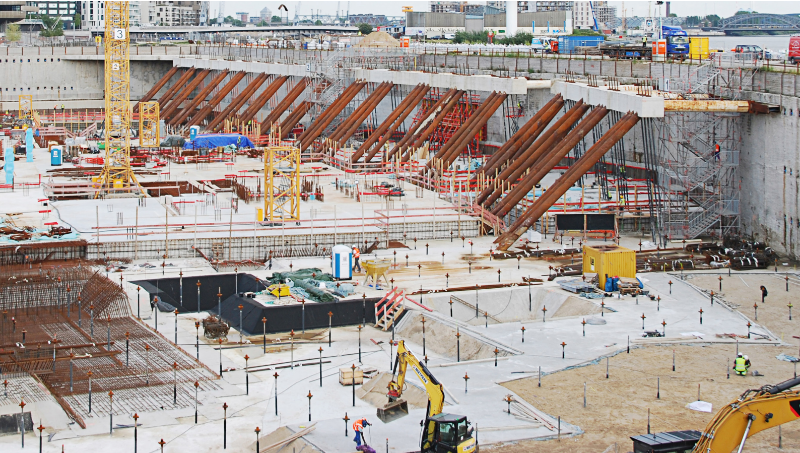
Baugrube für das Quartier Westfield Hamburg-Überseequartier (Quelle: WTM Engineers GmbH)
