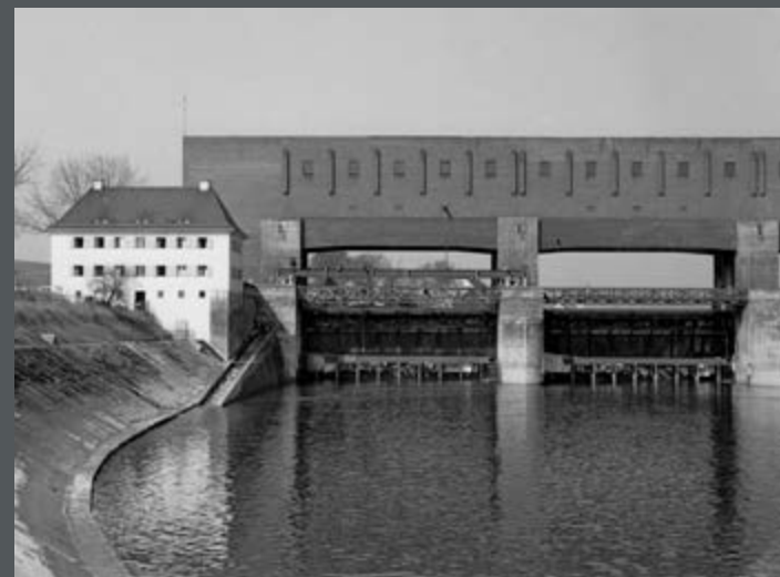
Bild 392: Blick von Unterwasser auf den Fischpass an der Staustufe und auf zwei Wehrfelder. (1954)
