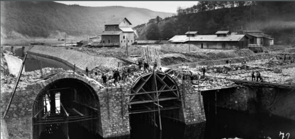
Bild 109: Das Bild zeigt die gemauerten zweiten und dritten Durchlässe für den Fluss am Hang. (1912)
