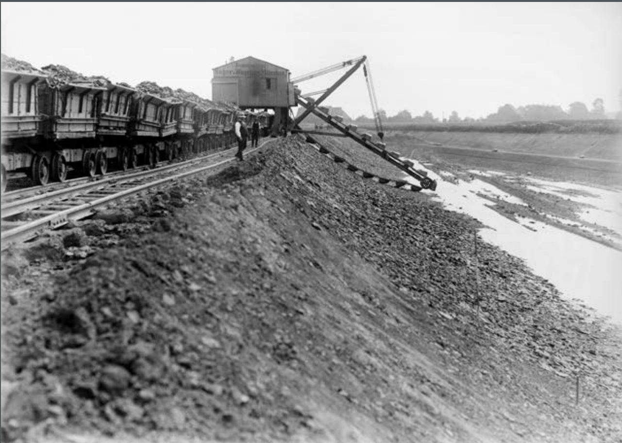
Bild 356: Der Eimerkettenbagger fräst die wasserseitige Böschung beim Bau des Mittellandkanals bei Niedernwöhren, der Abraum wird über gleisgebundene Loren abtransportiert. (1912)
