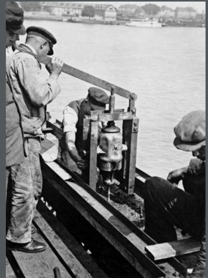
Bild 275: Ein handbetriebener Holzbohrer im Einsatz auf der alten Rheinbrücke zwischen Mainz und Wiesbaden. (1932)
