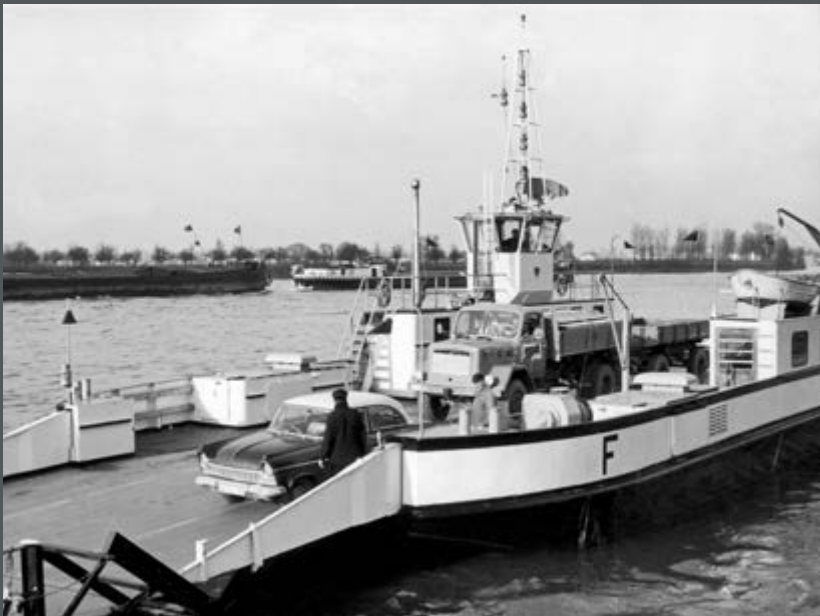
Bild 34: Die Fähre Gernsheim am Rhein an der Fährrampe am rechten Ufer. Sie ersetzt die 1945 gesprengte und danach nicht mehr aufgebaute Brücke. (1967)
