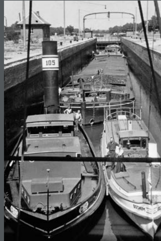
Bild 133: Frachtkahn und Schlepper bei der Schleusung in der alten Schleuse II (Oberhausen) am Rhein-Herne-Kanal. (1950)
