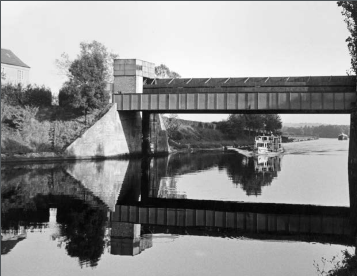
Bild 324: Hochwasserabschluss an der Staustufe Horkheim. (1961)
