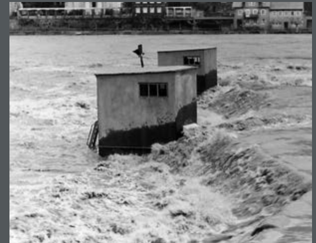
Bild 64: Überströmte Obertore der Schleuse Heidelberg am Neckar bei Hochwasser. (1970)
