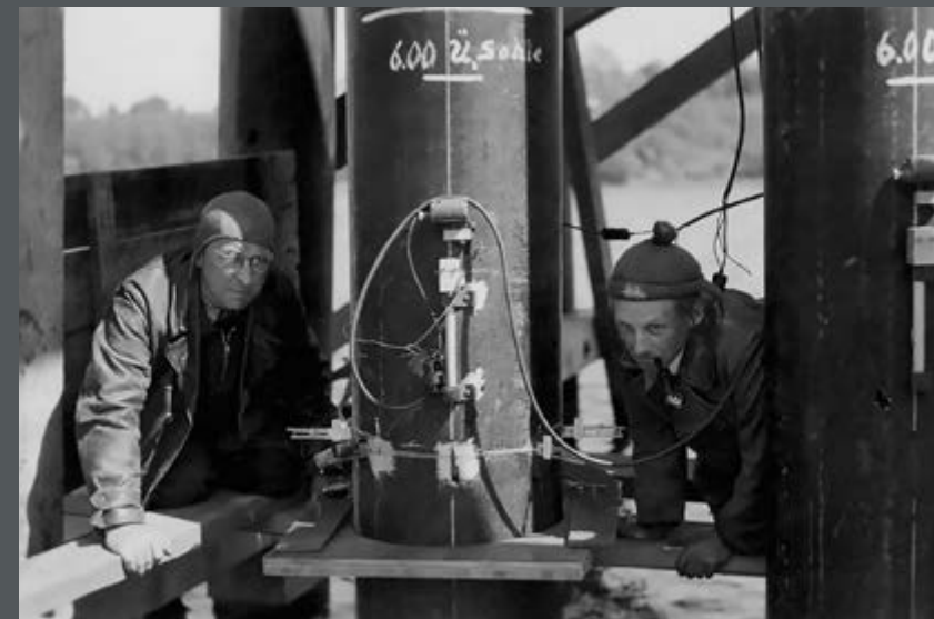
Bild 273: Versuche an Holzdalben in Flemhude am Nord-Ostsee-Kanal. Ein tauchbares Dehnmessgerät wird geöffnet. (1951)
