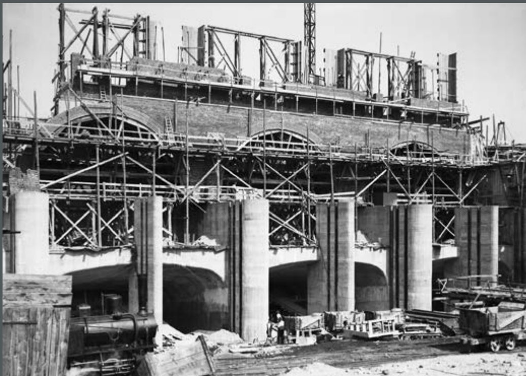
Bild 393: Blick von Unterwasser auf den Turbinenauslauf und den Fußgängersteg beim Bau der Kraftwerksanlage. (1925)
