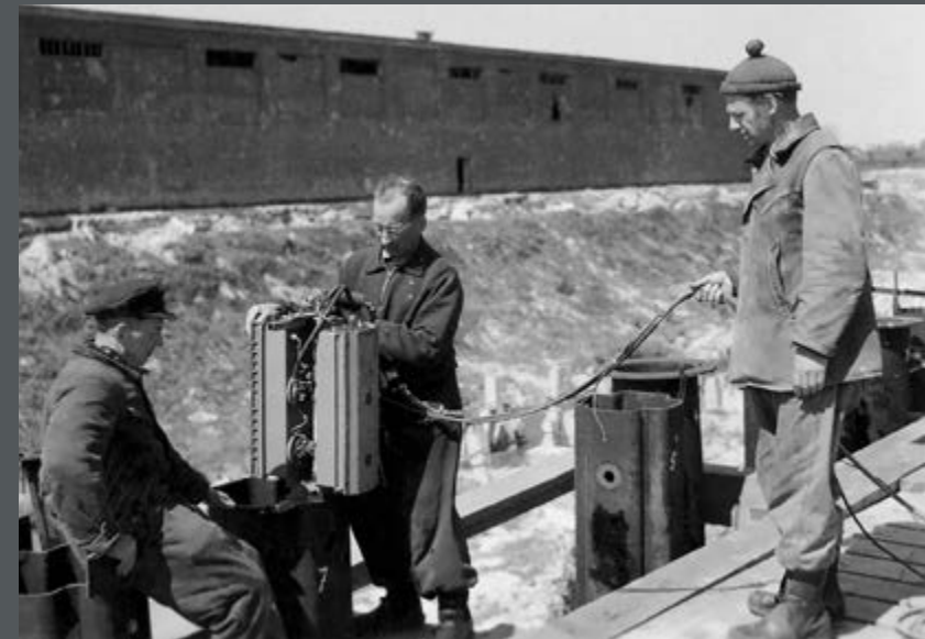
Bild 272: Dalbenversuch in Flemhude am Nord-Ostsee-Kanal. Die Huggenberg-Tensometer werden abgelesen. (1951)
