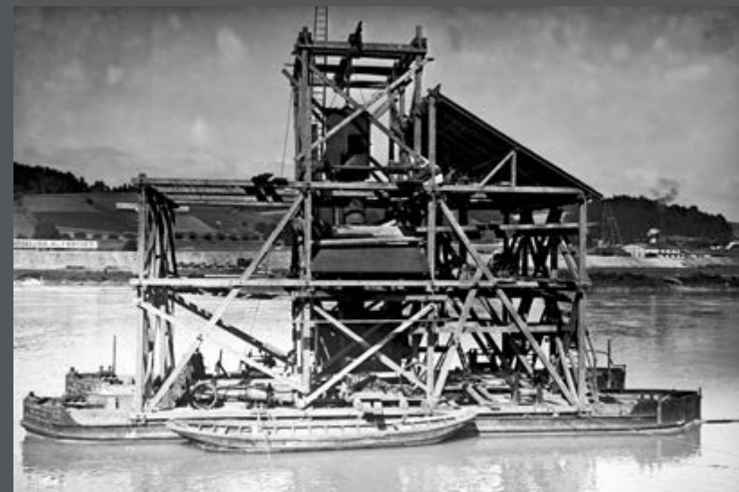
Bild 380: Diese historische Taucherschleuse wurde beim Bau der Staufstufe eingesetzt. Die Konstruktion wurde auf zwei Schleppkähnen montiert, die Schleuse dazwischen abgelassen. (1923)
