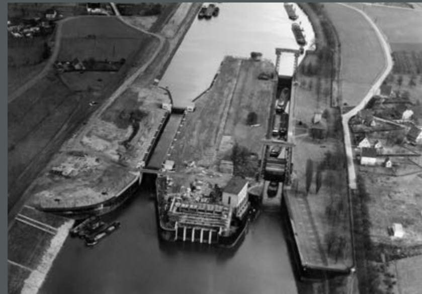
Bild 124: Luftbild der Schleusengruppe Friedrichsfeld (Kanalstufe) am Wesel-Datteln-Kanal. (1964)
