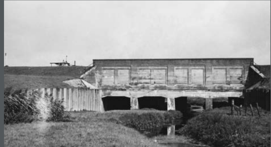
Bild 93: Alter Düker „Rodenberger Aue“ am Mittellandkanal, er wurde inzwischen abgebrochen und ein neuer gebaut. (1946)
