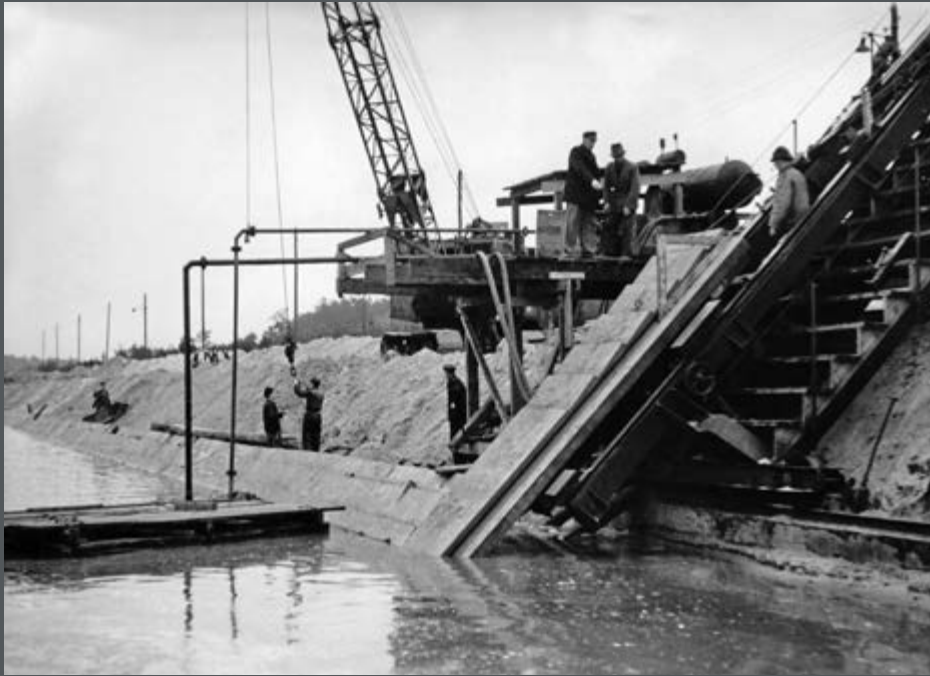
Bild 276: In einer Versuchsstrecke am Dortmund-Ems-Kanal werden Stahlbetonplatten als Böschungsschutz eingebaut. (1954)
