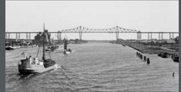
Bild 174: Eisenbahnhochbrücke Rendsburg über den Nord-Ostsee-Kanal, erbaut 1913 als Stahlkonstruktion, 2.486 Meter lang. (1950)
