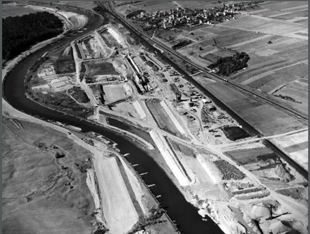
Bild 119: Luftbild der Baustelle der Staustufe Ottendorf am Main. Man erkennt die Baugruben des Wehrs mit Kraftwerk, der Schleuse mit Ober- bzw. Unterkanälen im späteren Durchstich. Die jetzige Mainschlinge wird später abgeschnitten und bleibt als „Alter Main“ teilweise erhalten. (1958)
