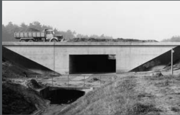
Bild 186: Durchlassbauwerk Steinforstgraben am Main-Donau-Kanal bei Erlangen. (1968)
