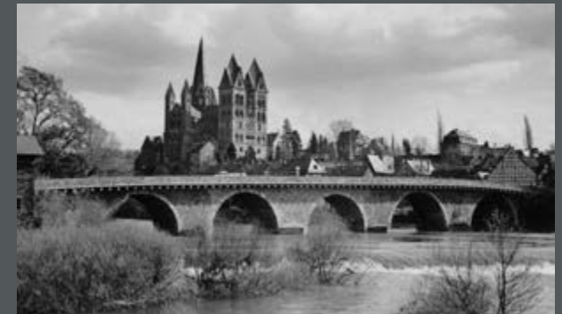
Bild 175: Alte Straßenbrücke von 1354 über die Lahn in Limburg. Unterwehr im Vordergrund. (1950)
