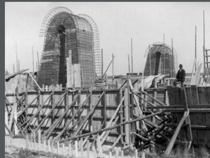
Bild 344: Südsicht der Kanalbrücke mit Widerlager Ost. Das Hilfspumpwerk südlich des Widerlagers ist im Bau, ebenso die Türme. (1913)
