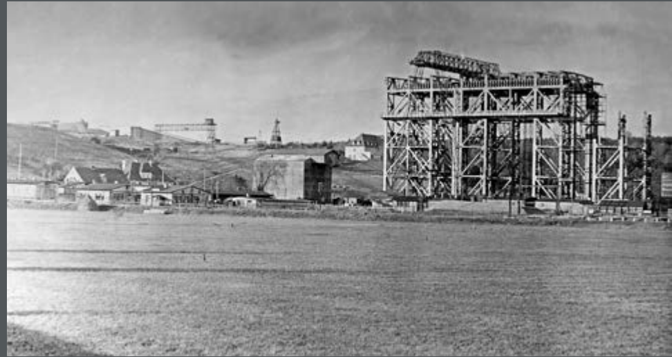
Bild 440: Baustelle des Schiffshebwerks und der Kanalbrücke. (1931)
