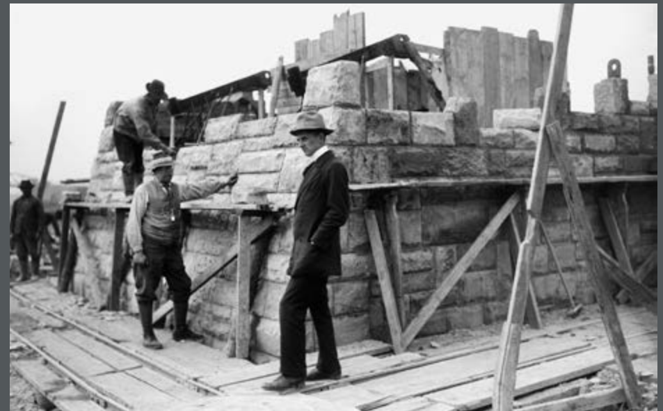
Bild 258: Das südliche Seilscheibenhaus mit dem oberen Schräganker und dem Verblendmauerwerk der Sicherheitstoranlage Nr. V (alt), in Evesen am Mittellandkanal, im Bau. (1914)
