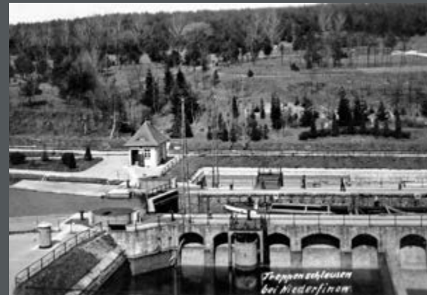
Bild 426: Blick Richtung Norden auf die unterste Schleuse IV mit Sparbecken im Vordergrund. (1932)
