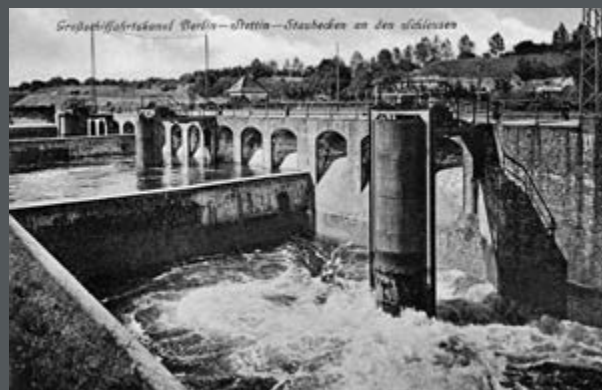
Bild 421: Blick auf die Sparbecken der Schleuse III mit den zwei mal drei Schwimmzylindern der jeweils drei Kammern beidseitig. (1916)
