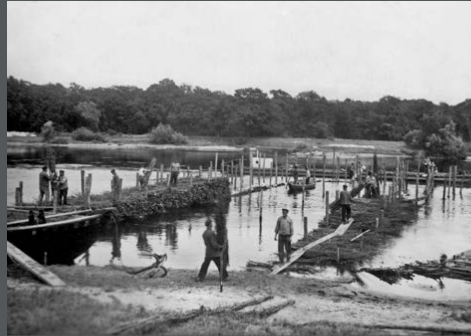
Bild 277: Die Flussstrecke der Oder bei Glogau soll ausgebaut werden. Dazu wird der Faschinenunterbau vom Ufer aus belastet und versenkt. (1937)
