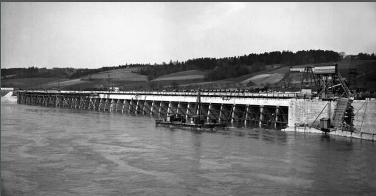
Bild 397: Das Einlaufbauwerk (Einlaufrechen) der Kraftwerksanlage dient der Wasserberuhigung und der Abwehr von Treibgut. Der Rechentträger wird montiert. (1925)
