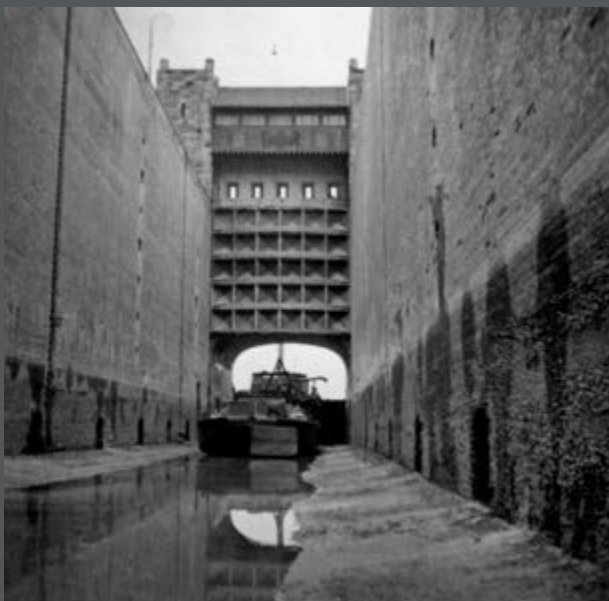
Bild 130: Trockengelegte Kammer der alten Schachtschleuse Henrichsburg am Dortmund-Ems-Kanal mit Schiff. Die Durchfahrtsöffnung zum Kanal ist bei Schachtschleusen mit einer Quermauer versehen. (1952)
