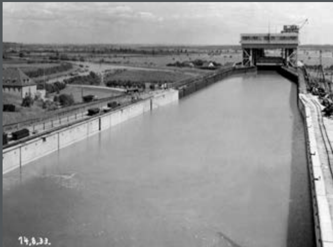
Bild 448: Blick vom Sicherheitstor auf den Trog der Kanalbrücke, der gerade gefüllt wird. (1933)
