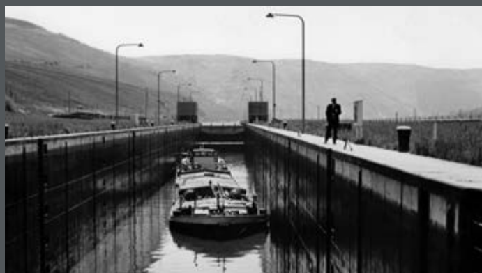
Bild 137: Oberhaupt mit geschlossenem Hubsenktor der Schleuse Detzem an der Mosel, ein Frachter wird ge- schleust. (1965)
