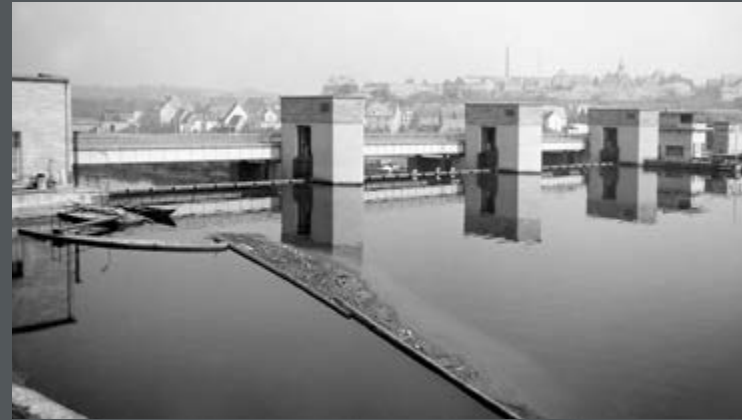
Bild 328: Wehr Lauffen von Oberstrom. (1961)
