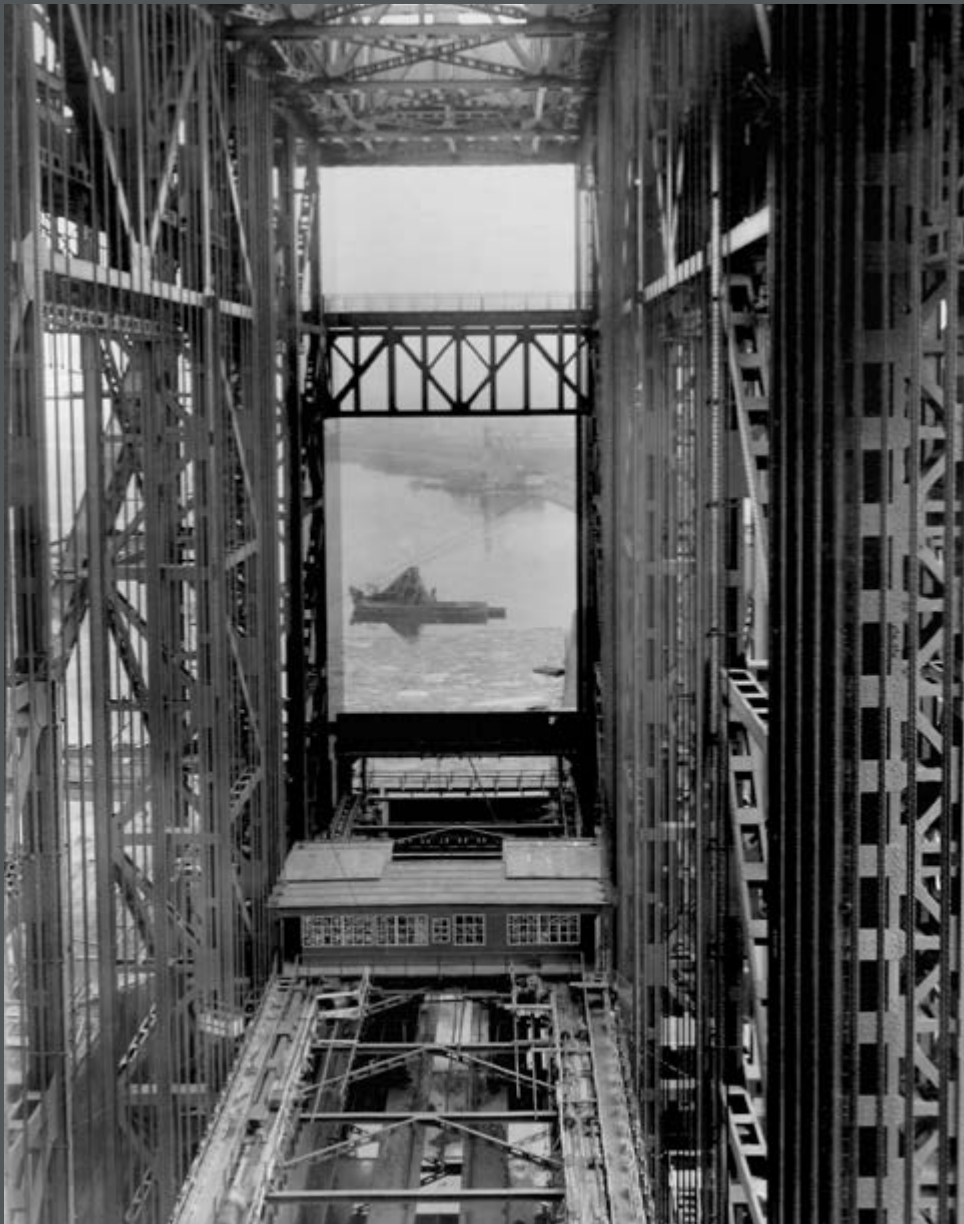
Bild 443: Blick von der Kanalbrücke Richtung Osten auf den unteren Vorhafen, der ausgebagert wird. (1933)
