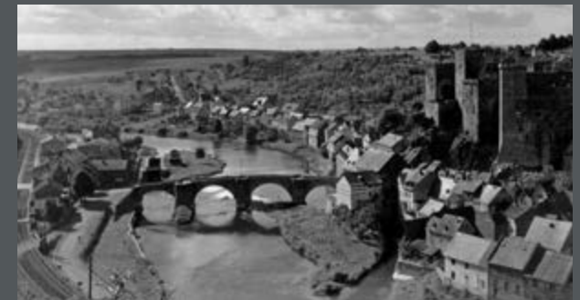
Bild 176: Wehr und Schleuse Runkel an der Lahn mit der alten Straßenbrücke von 1448. (1950)
