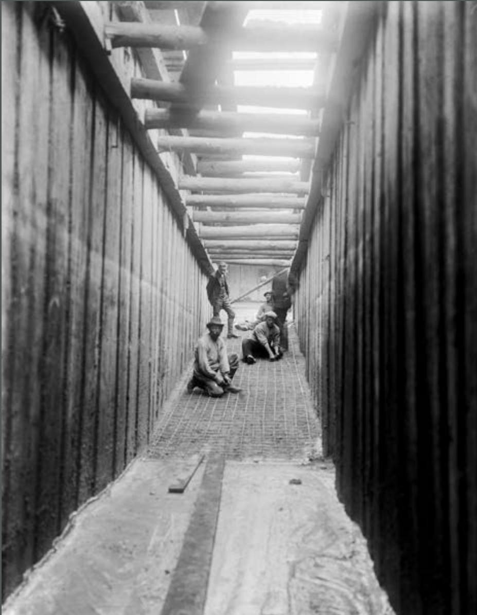
Bild 256: Die ehemalige Dükeranlage Nr. 116 am Mittellandkanal wird auf der Sohle bewehrt, die Wände sind abgestützt. (1971)
