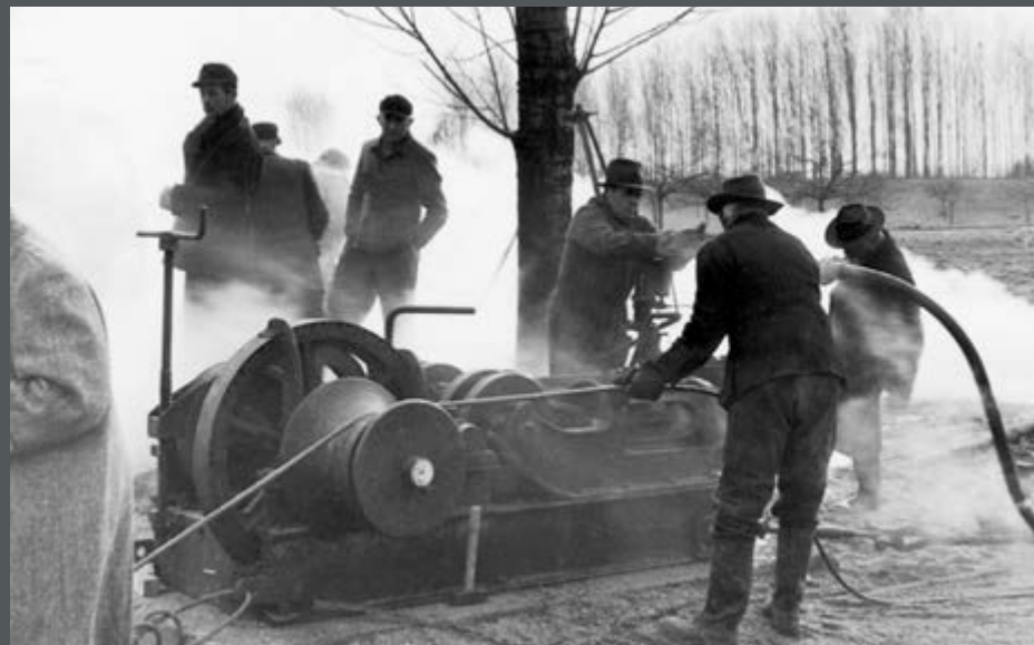
Bild 268: Dükerverlegung bei Eich am Rhein mit Winde für den Durchzug der Rohrleitung. (1950)
