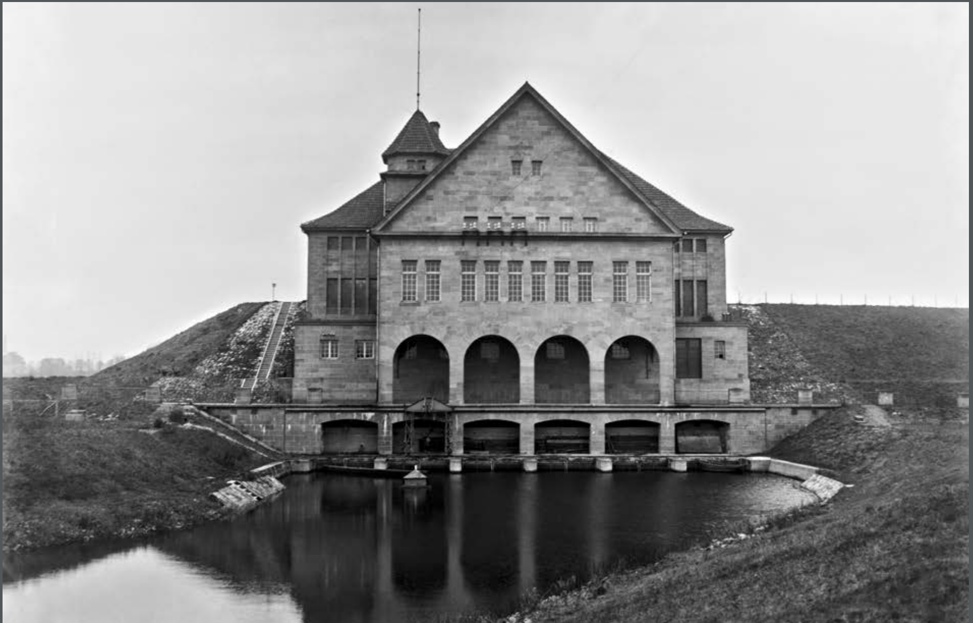
Bild 217: Das fertiggestellte Hauptpumpwerk Minden am Mittellandkanal kann diesem Wasser entnehmen oder zugeben. (1916)
