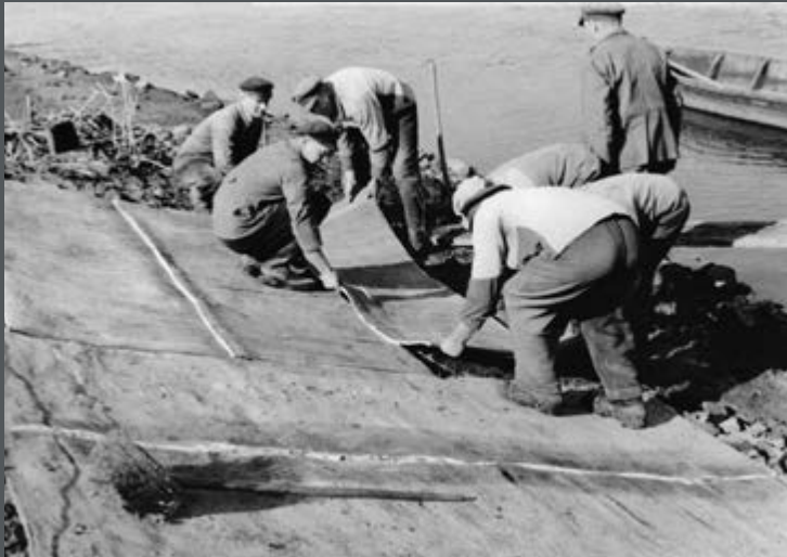
Bild 246: Einbau von pflanzendurch- lässigen Asphalt- matten an der unteren Ilmenau. (1955)
