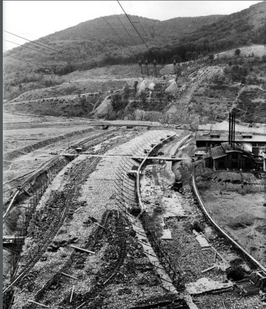
Bild 105: Die Baustelle vom rechten Hang aus gesehen. (1911)
