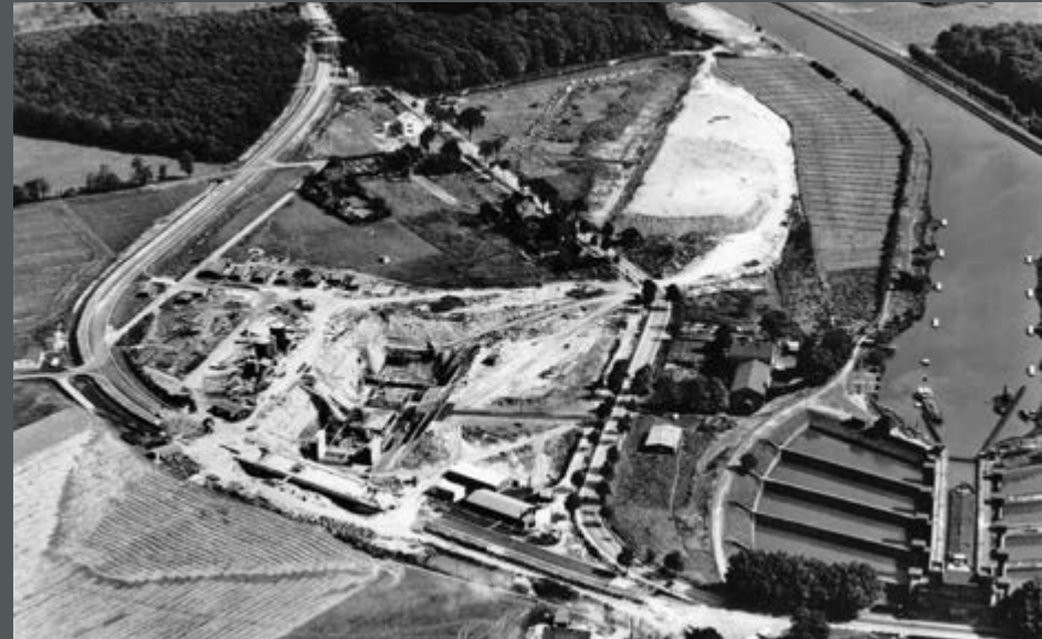
Bild 155: Baustelle des neuen Schiffshebewerkes Henrichsburg – Abstiegsbauwerk 3 am Dortmund-Ems-Kanal. Daneben (unten rechts) die alte Schachtschleusen-anlage. (1960)
