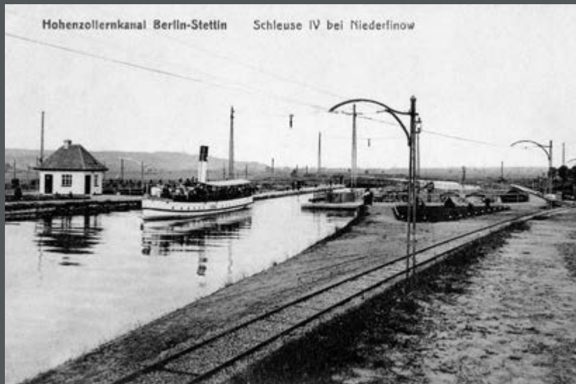
Bild 424: Blick vom unteren Vorhafen auf die letzte Schleuse IV, aus der gerade ein Dampfboot ausfährt. Am rechten Bildrand die Treidelanlage zum Transport der Schiffe. (1914)
