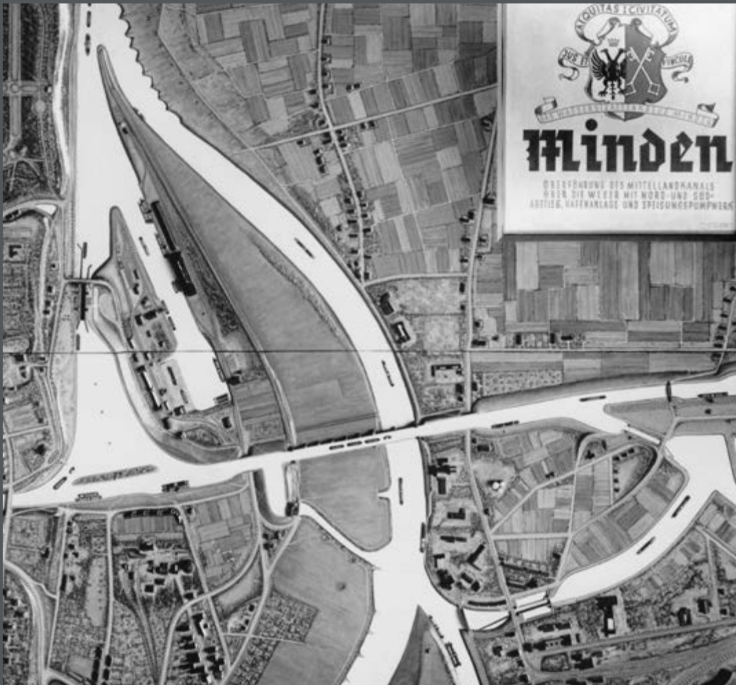
Bild 341: Die Arbeiten am Westabschnitt begannen 1906 und schlossen 1915 kurz nach Ende des Ersten Weltkrieges mit dem Bau des Wasserstraßenkreuzes Minden ab (Schachtschleuse, Obere Schleuse, Kanalbrücke, Pumpwerk), d.h. Rhein und Weser waren miteinander verbunden. Das Bild zeigt ein Modell des Wasserstraßenkreuzes Minden mit Mittellandkanal und Weser aus dem Ausstellungsgebäude in Minden, Maßstab = 1 : 1000. (1946)
