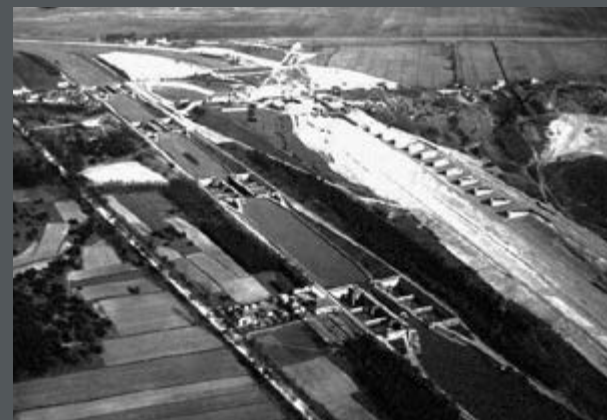
Bild 428: Blick Richtung Osten auf die fertige Schleusentreppe (links) und das Hebewerk im Bau (rechts). Im Vordergrund die oberste Schleuse I mit der Bebauung auf der Nordseite mit Straße, dahinter Schleusen II bis IV, getrennt durch die Zwischenhaltungen, bis zum Unterwasser von Schleusentreppe und Hebewerk. Parallel zum oberen Bildrand kann man die Schleuse Liepe und den Finowkanal erahnen. (1928)
