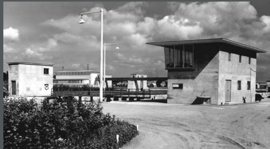
Bild 216: Schleusensteuerhaus, Antriebshaus der Schleuse Hohenfeld-Kitzingen am Main im Bau. (1956)
