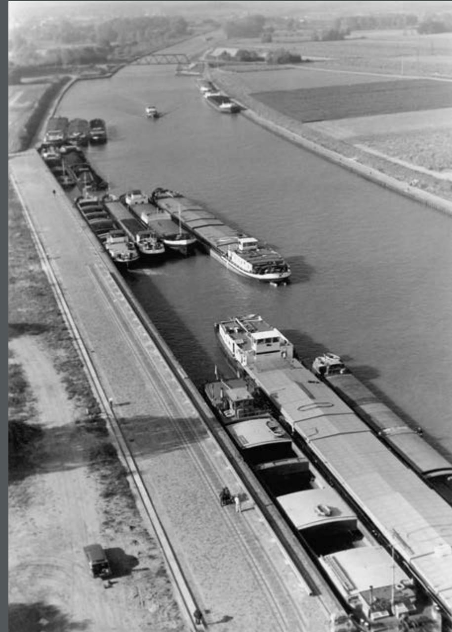
Bild 376: Das ausgebaute Kanalbett des Mittellandkanals im Bereich des Hafens Braunschweig. (1968)
