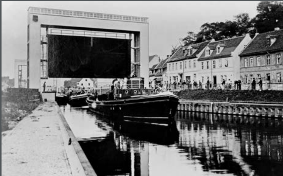
Bild 134: Schleuse Bernburg an der Saale mit offenem Hubtor. (1949)
