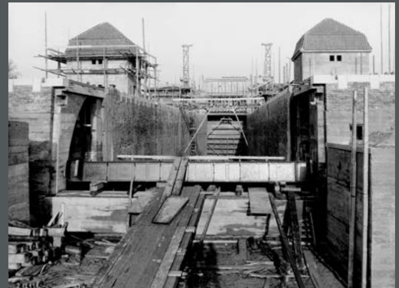
Bild 342: Blick von Süden auf das Oberhaupt der Schachtschleuse Minden, das obere Schleusentor wird eingebaut. (1913)
