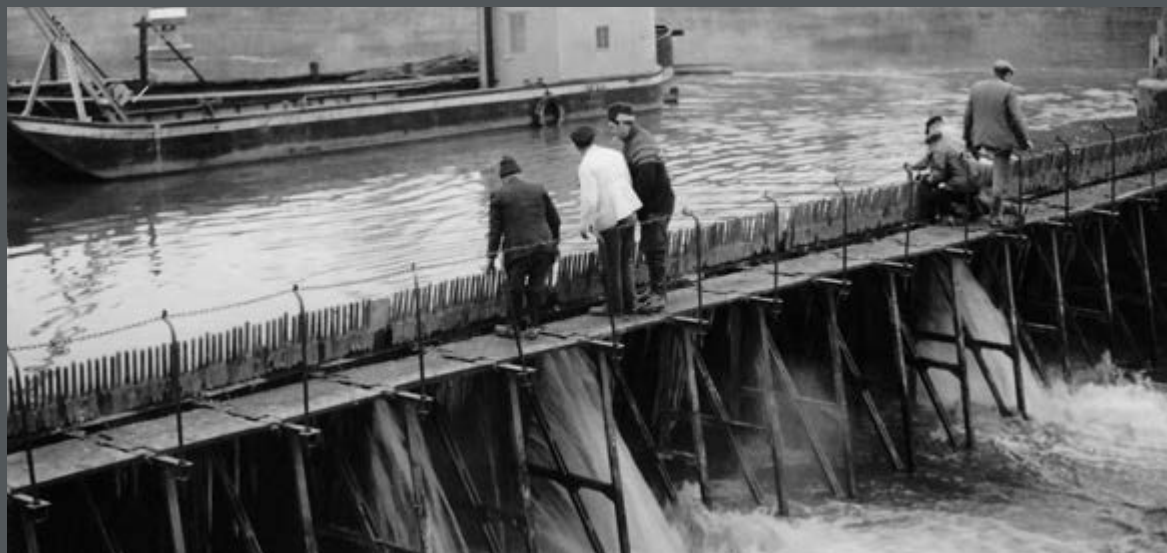
Bild 145: Durch Ziehen der Nadeln des alten Nadelwehrs von 1879 wird die Inselbaugrube für den Neubau der Wehranlage Völklingen an der Saar geflutet. (1969)
