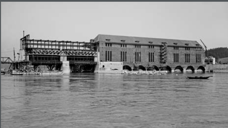
Bild 391: Das Bild zeigt die fertige Außenfassade des Krafthauses (rechts) und die Wehrfelder „E“ und „F“ im Bau. (1926)
