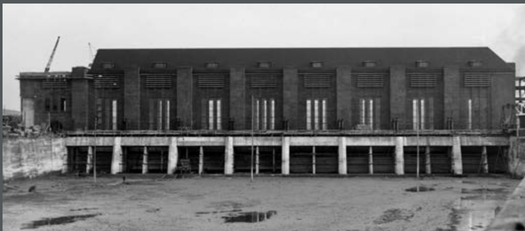
Bild 394: Der obere Kraftwerkskanal und das Krafthaus sind von flussabwärts zu sehen. An der Schaltanlage wird noch gebaut. (1926)
