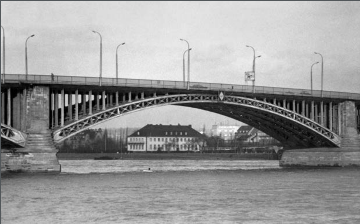
Bild 173: Blick durch den Bogen der neuen Straßenbrücke (Theodor-Heuss-Brücke) in Mainz auf das neue Dienstgebäude des WSA Mainz-Kastel am rechten Rheinufer. (1967)
