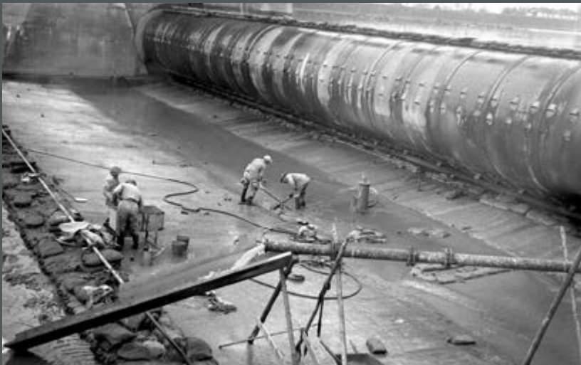
Bild 282: Sanierung der Betonsohle des Wehrs Ladenburg am Neckar unterhalb der Wehrwalze. (1937)
