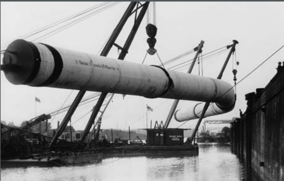
Bild 94: Der Berne-Düker am Rhein-Herne-Kanal wird neu gebaut. Die Dükerleitung wird von der Kaimauer des Krupphafens abgehoben. (1952)
