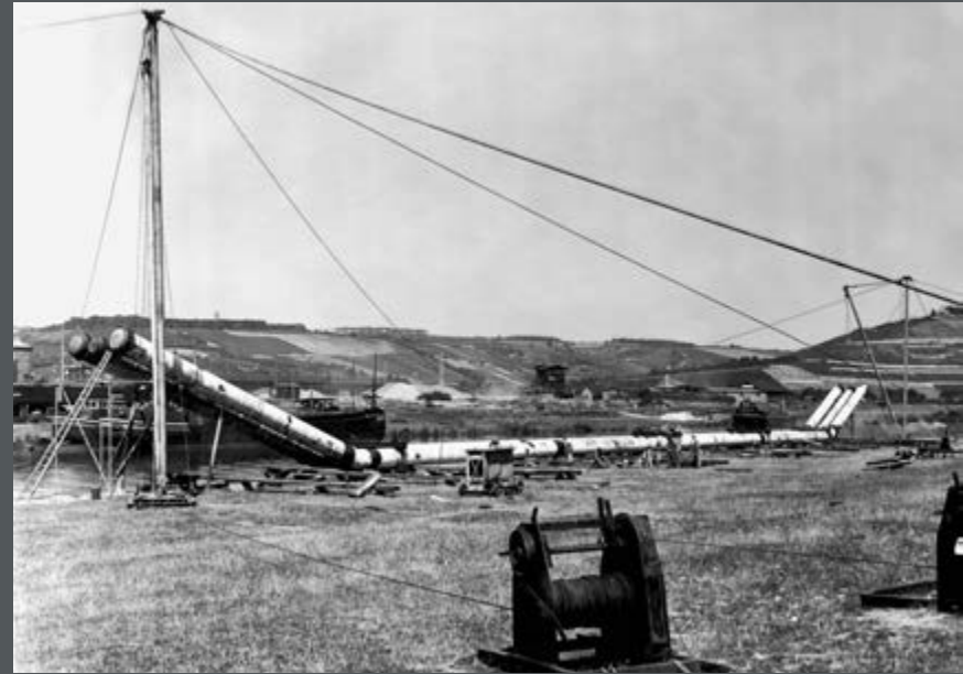
Bild 181: Fertig zusammengebaute Dükerrohre vor dem Einsetzen mittels Kabelkrananlage in den Main bei der Staustufe Würzburg. (1950)
