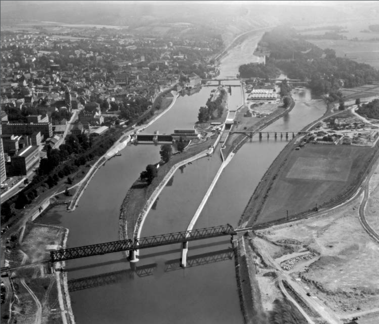
Bild 120: Eine Staustufe ist eine Anlage zum Aufstau eines Flusses, um den Wasserstand flussaufwärts und flussabwärts zu regeln und damit die Schifffahrt zu erleichtern. Die Hauptbauwerke (Schleuse, Wehr, gegebenenfalls Kraftwerk) liegen je nach Bauart nicht immer im gleichen Stromkilometer. Das Luftbild zeigt die neue Main-Staustufe Schweinfurt mit Bahnbrücke, Maininsel mit Schleuse und Wehranlage. (1956)
