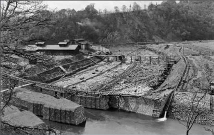
Bild 103: Die Baugrube der Edertalsperre am linken Talhang mit Wasserhaltung, im Vordergrund die Öffnungen für den Fluss. (1911)
