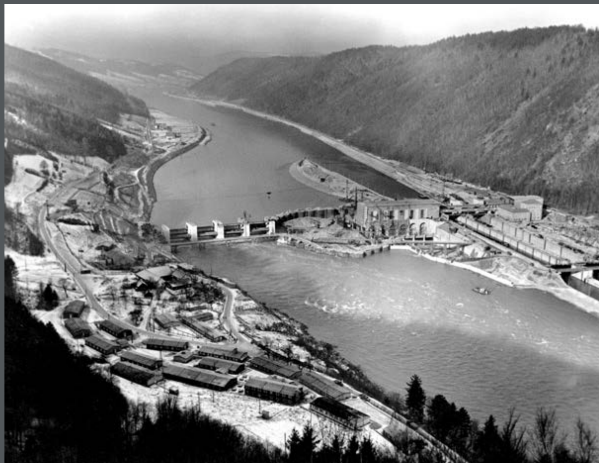
Bild 410: Blick donauaufwärts auf die fertige Doppelschleuse (rechts) und das fertige Wehr (links). In der Mitte die sogenannte Baugrube III für den zweiten Bauabschnitt des Kraftwerks mit Zellenfangedamm. (1955)
