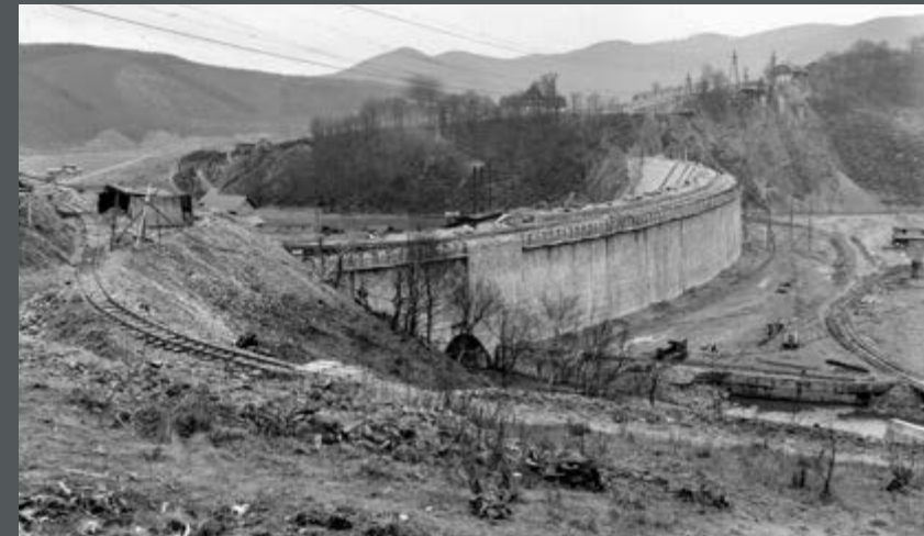
Bild 110: Wasserseitige Mauer vom linken Hang aus. Man erkennt den Durchlass am linken Hang und die Ansiedlung von Gebäuden gegenüber. (1913)
