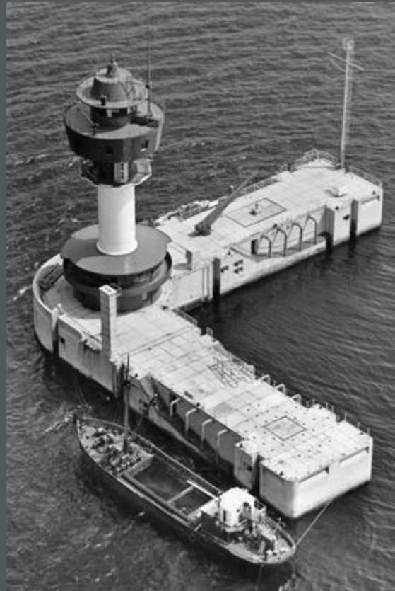
Bild 61: Der Leuchtturm steht vor der Küste in der Kieler Bucht als Leit- und Orientierungsfeuer mit vier Anlegeplätzen für Lotsenschiffe. Das Fundament ist eine Schwimmkasten-gründung. (1967)
