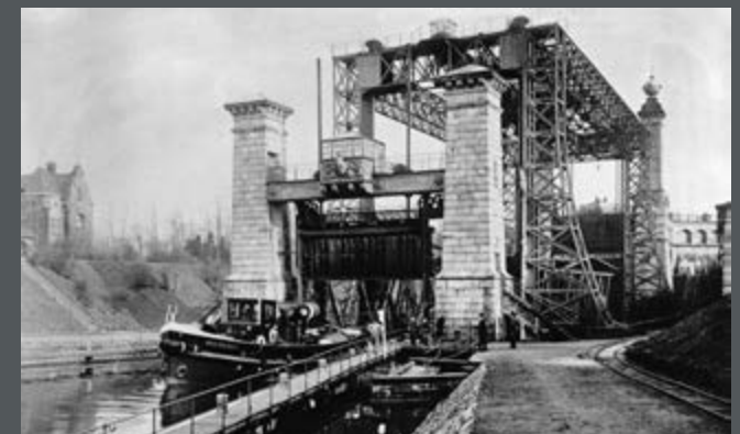
Bild 153: Altes Schiffshebewerk Henrichenburg am Dortmund-Ems-Kanal von Unterwasser. (1934)
