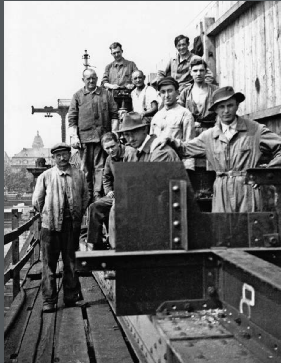
Bild 266: Arbeiterkolonne bei der Erweiterung der Rheinbrücke Mainz-Kastel von 1885 zwischen Mainz und Wiesbaden. (1932)
