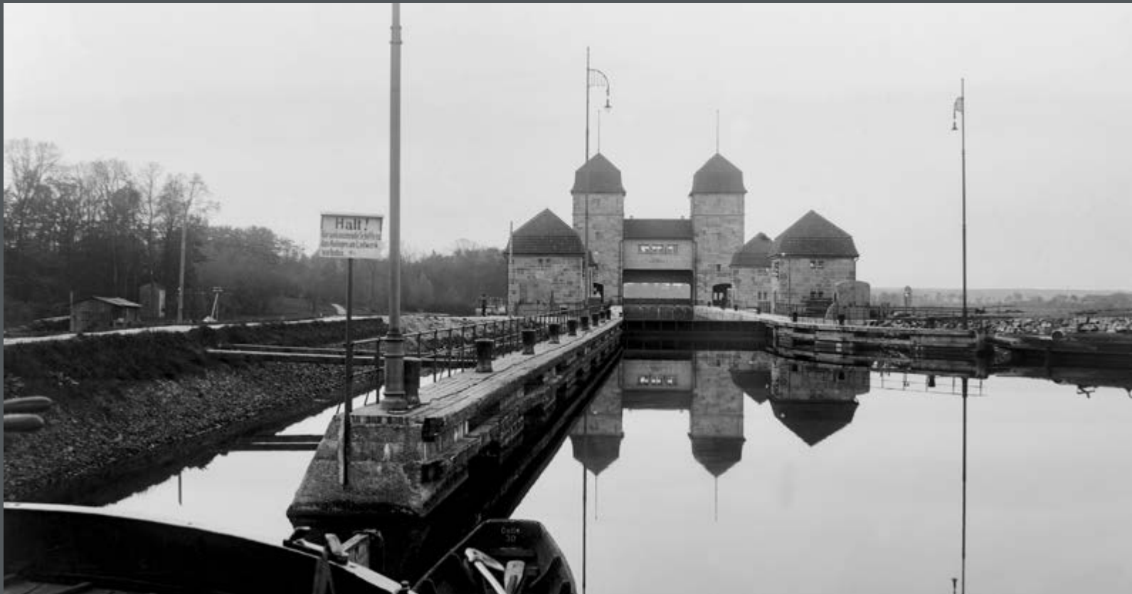
Bild 348: Untere Schleuse am Wasserstraßenkreuz Minden, Oberhaupt im Vordergrund geschlossen, Unter- haupt geöffnet. (1926)
