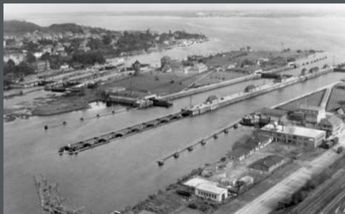
Bild 136: Luftbild der alten und neuen Schleuse Kiel-Holtenau am Nord-Ostsee-Kanal (Seeschleuse zur Ostsee). (1950)
