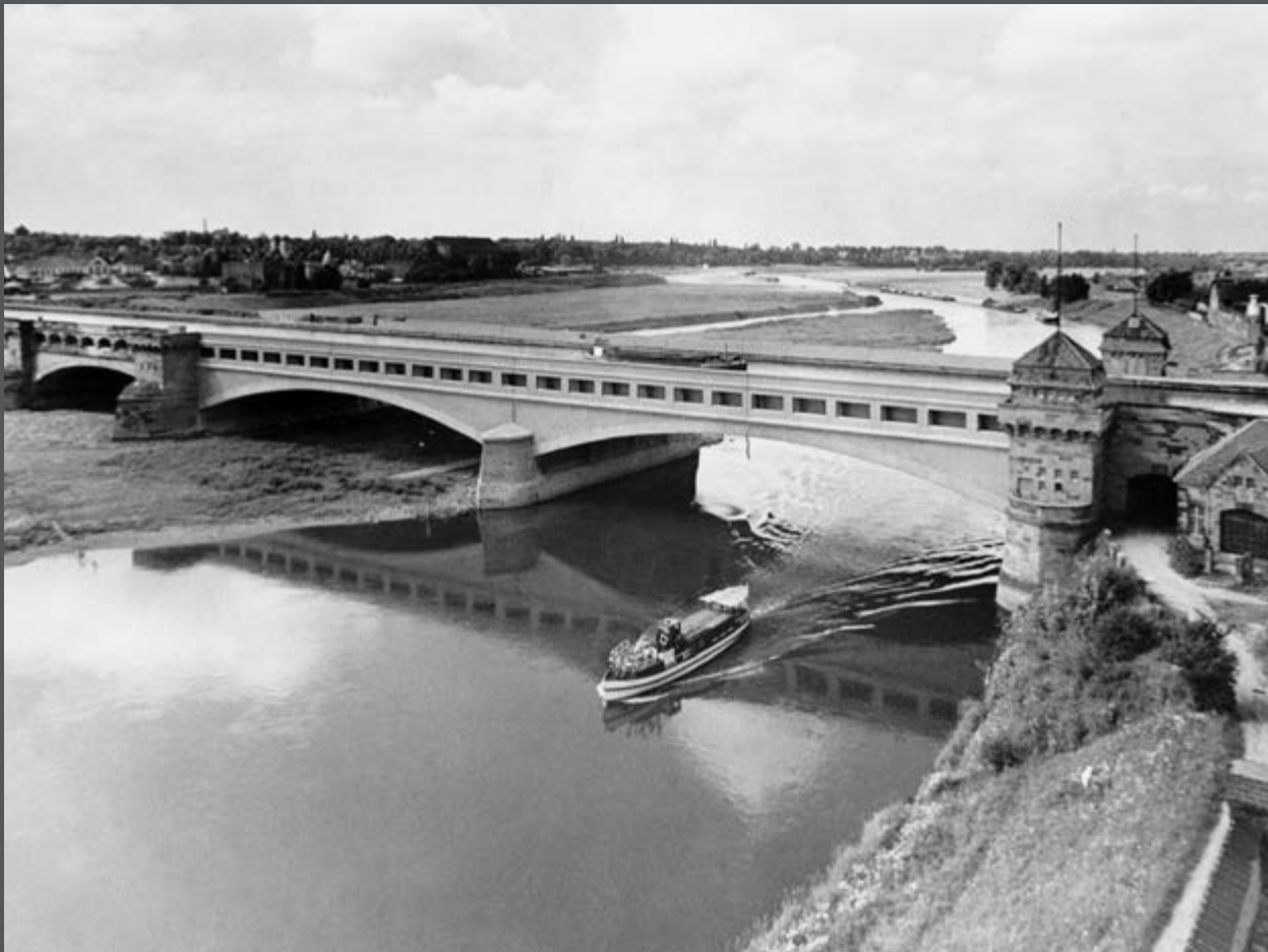
Bild 192: Kanalüberführung U164 alt am Wasserstraßenkreuz Minden am Mittellandkanal über die Weser, Fertigstellung 1914. (1960)
