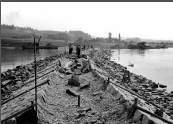
Bild 403: Am Rainer Eck bei Hofkirchen wird das Niedrigwasser der Donau reguliert, ein Leitwerk ist im Bau. (1950)
