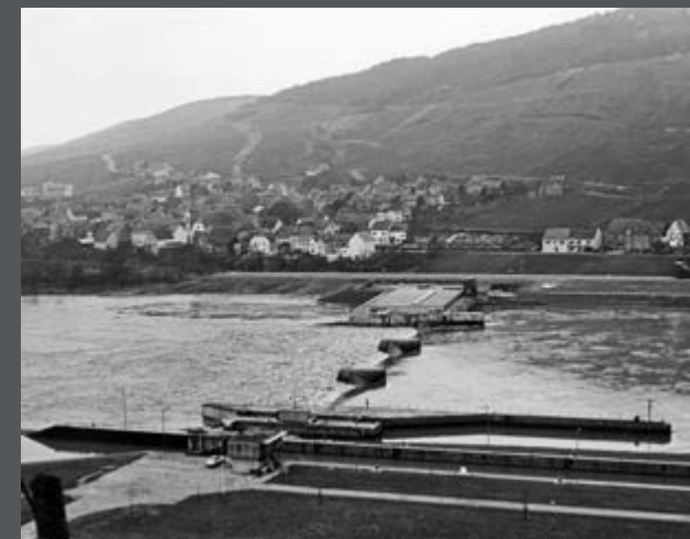
Bild 75: Hochwasser im Februar 1970 an der Stauanlage Wintrich an der Mosel. Im Vordergrund die voll durchströmte Schleuse, das Kraftwerk (hinten) fährt Volllast.
