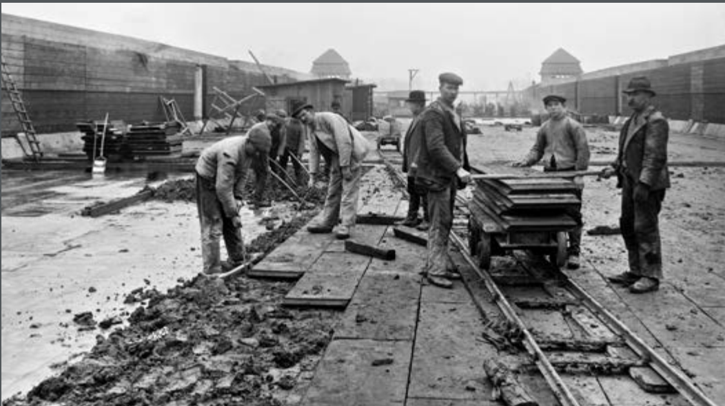
Bild 260: Stahlbetonplatten werden in einer sandigen Lehmschicht über der eigentlichen Dichtung (Bleihaut, beidseitig mit Pappasphalt verklebt) als Sohlschutz beim Bau der alten Kanalbrücke Minden am Mittellandkanal verlegt. (1914)
