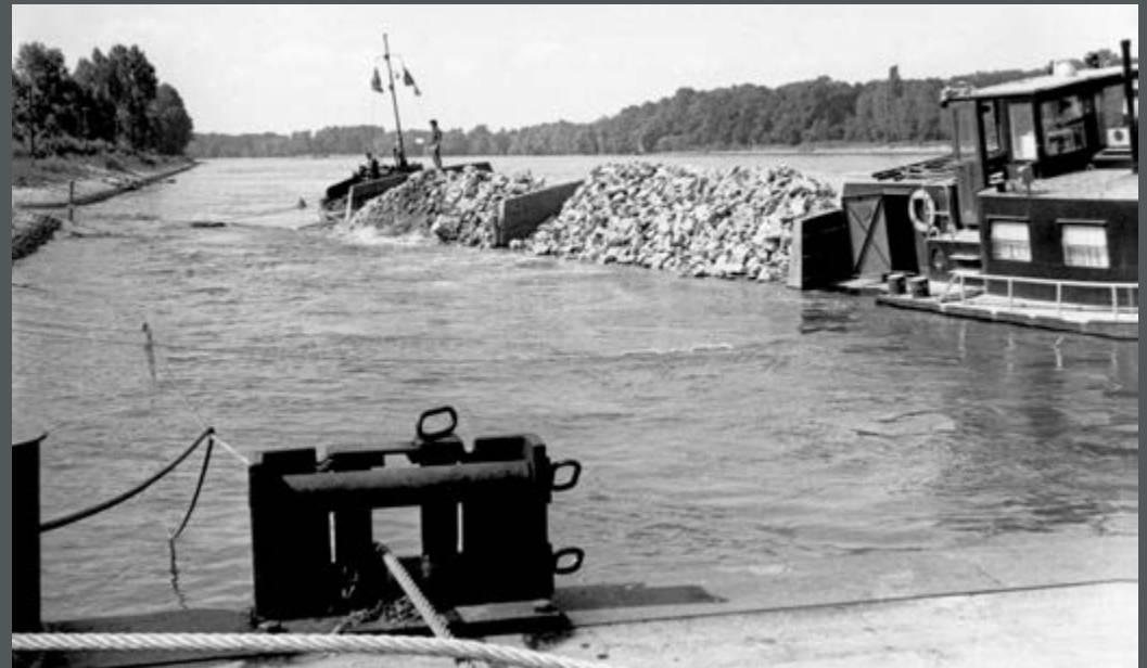
Bild 35: Zur Herstellung eines Leitwerks im Rhein wird eine Klappschute verwendet, die das Schüttgut seitwärts ausschüttet. (1967)
