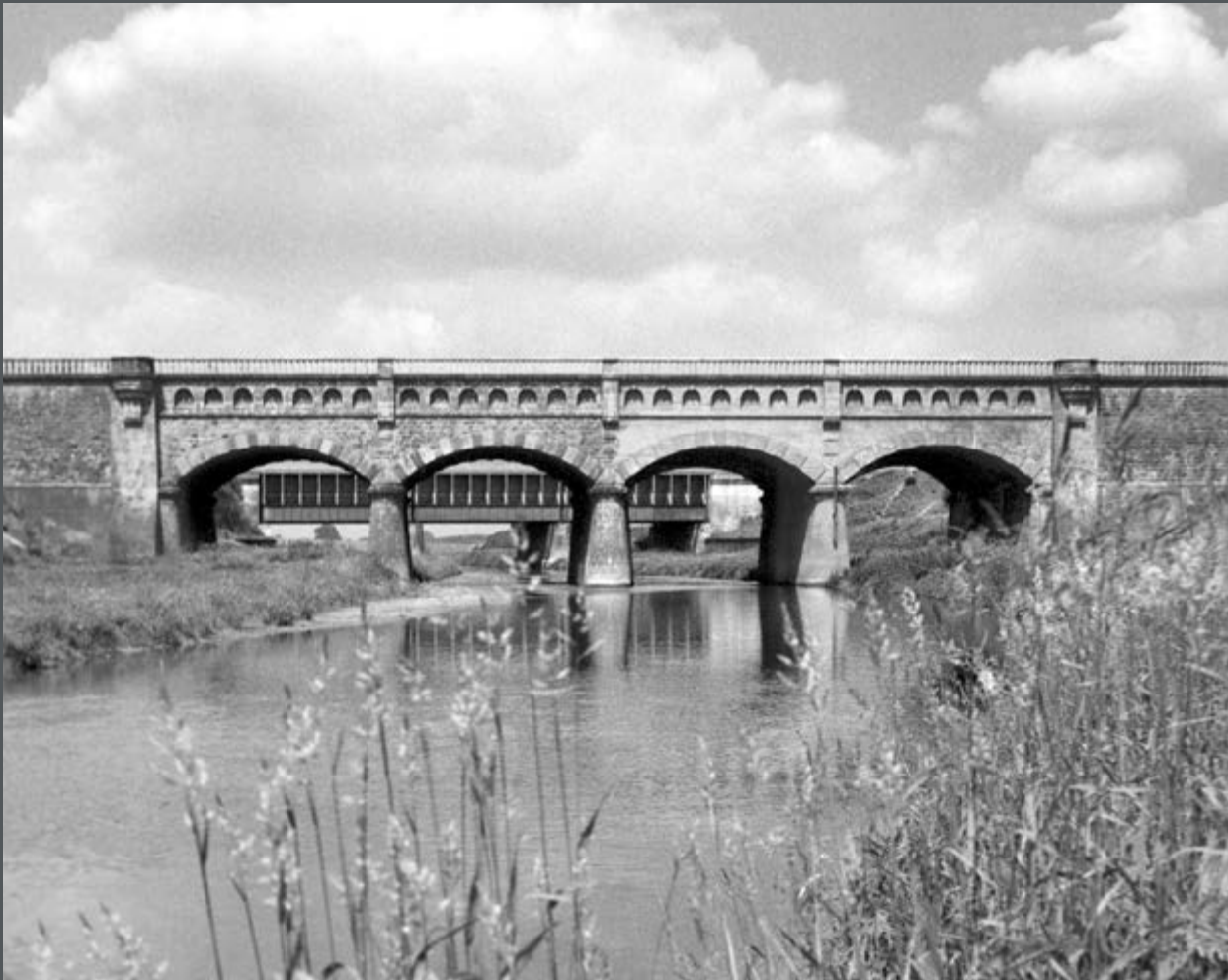
Bild 190: Im Folgenden wird der jeweilige Begriff so verwendet, dass eine Wasserstraße (Fluss/Kanal) ein Hindernis (Gewässer, Straße, andere Wasserstraße, Eisenbahn etc.) unterfährt oder überfährt. Brücken werden auf Seite 74-77 extra behandelt. Das Bild zeigt die Kanalbrücke des Dortmund-Ems-Kanals bei der Überquerung der Ems bei Greven, dahinter die Kanalüberquerung der „Alten (stillgelegten) Fahrt“. (1964)
