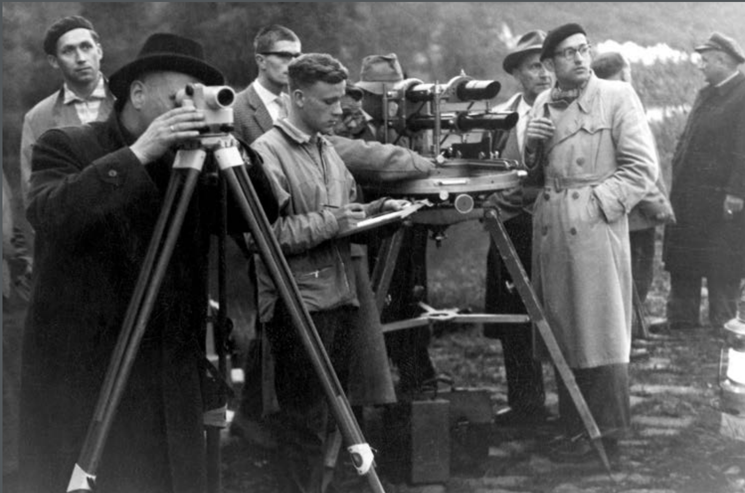
Bild 223: Ortungstachygraph und Nivelliergerät Ni 2 im Einsatz am Binger Loch im Rhein zu Wasserspiegelaufnahmen. (1953)
