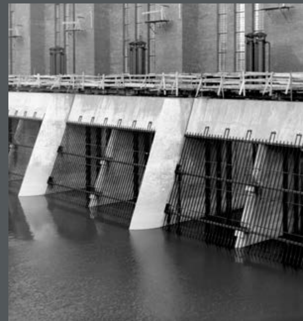
Bild 398: Die Turbineneinlaufkammern im Oberwasser mit den Grobrechen. (1927)
