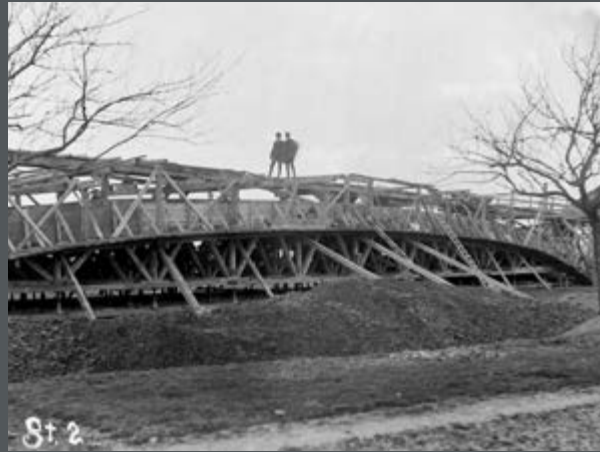
Bild 252: Arbeiten am Überbau der Lauenhäger Straßenbrücke Nr. 162 (alt) am Mittellandkanal. (1910)
