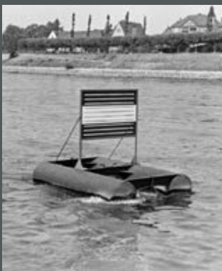
Bild 58: Ein Sperrfloß liegt im Kasteler Stromarm des Altrheins, um die Einfahrt in den Fluss zu verhindern. (1967)
