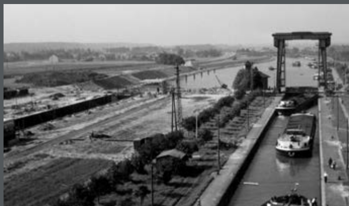
Bild 138: Bau der zweiten (kleinen) Schleuse Hünxe am Wesel- Datteln-Kanal (links). Rechts die große Schleuse mit Hubtor im Oberhaupt. (1966)
