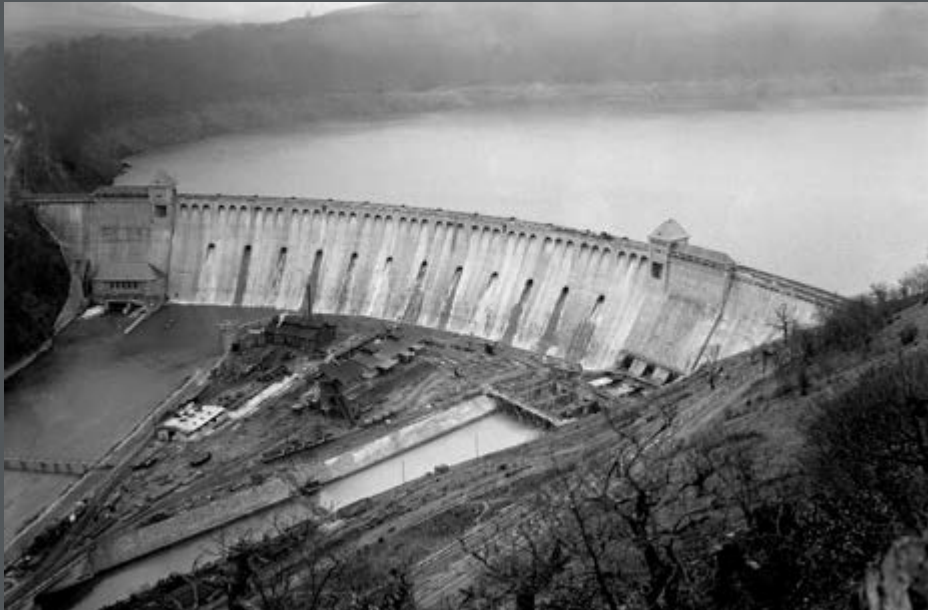
Bild 112: Luftseite der fertiggestellten Sperrmauer mit Schieberhaus und dem alten Ederbett (links). Rechts im Bild Rohrleitungen und Maschinenhaus des Kraftwerks Hemfurth I im Bau, Baustelleneinrichtung auf der Insel dazwischen. (1913)
