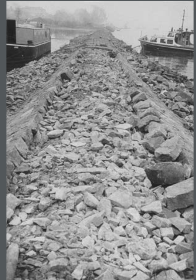
Bild 91: Am Rheinarm „Kleine Gries“ zwischen Erlach und Hattenheim wird das Leitwerk mit eingefärbten Betonpflastersteinen ausgebessert. (1959)
