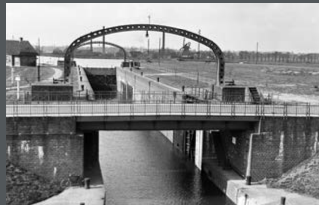
Bild 349: Obere Schleuse Minden mit offenem Untertor (Stemmtor) und geschlos- senem Obertor (Klapptor). (1928)
