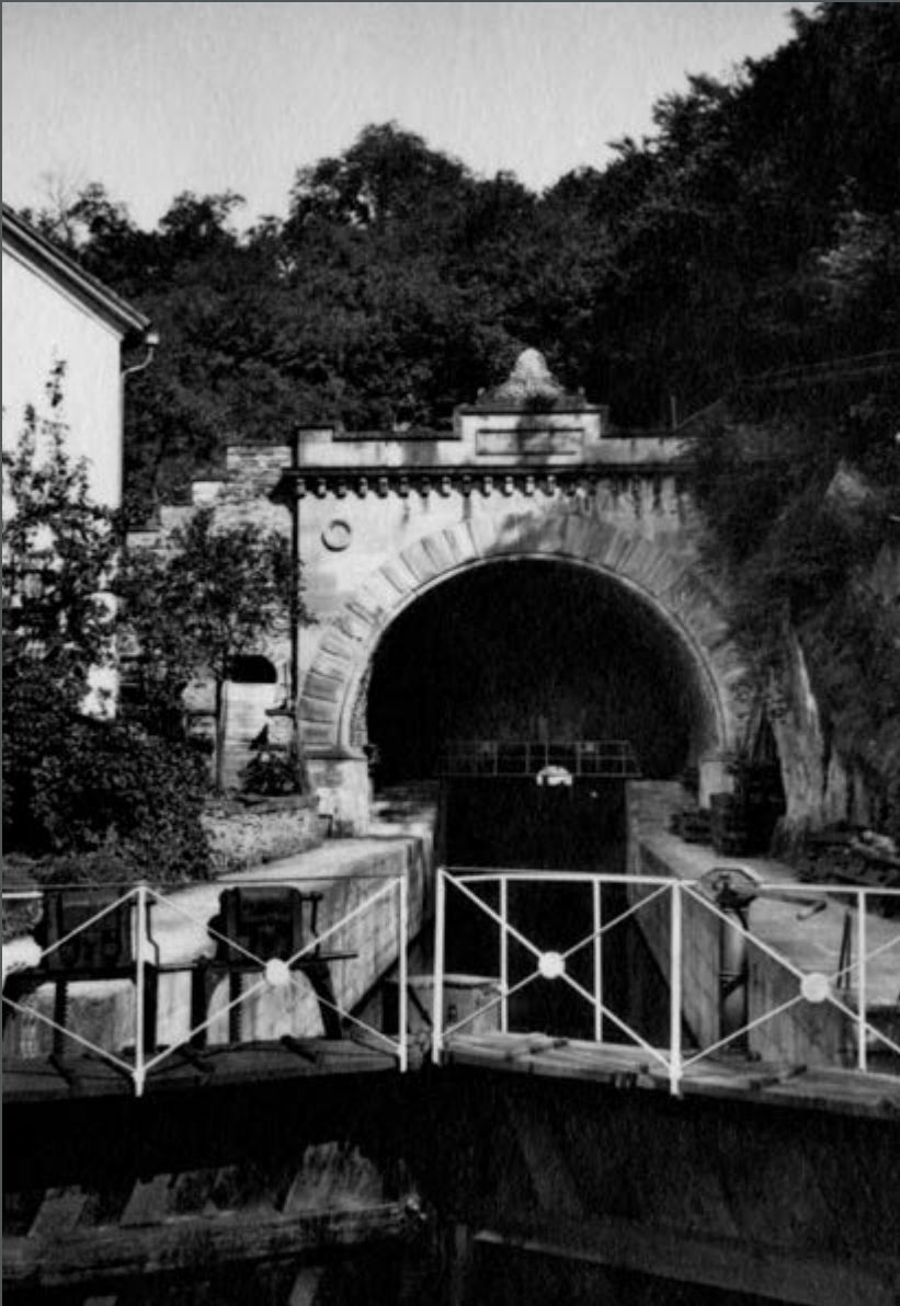
Bild 199: Der 195 Meter lange Schiffstunnel der Schleuse Weilburg von 1847 schneidet eine Lahnschleife ab. Im Bild die Südausfahrt des Tunnels mit Untertor und Tunnelportal. (1952)
