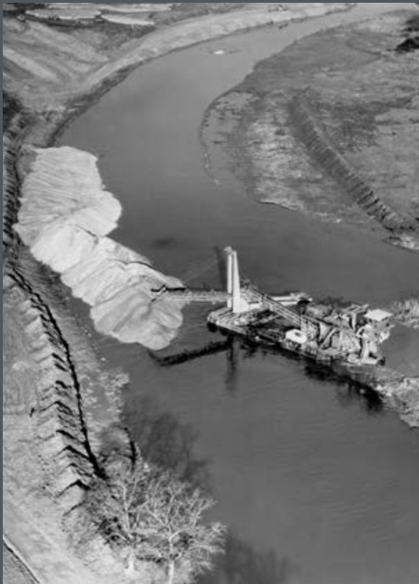
Bild 98: Ausbau der Regnitz im Unterwasser an der Stau- stufe Buckenhofen. (1962)
