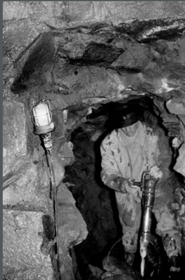
Bild 236: Stollenerweiterung mit Schlaghammer in der Sperrmauer der Edertalsperre. (1955)
