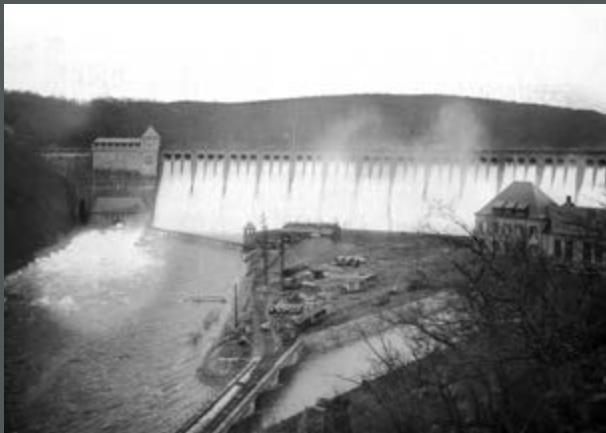
Bild 114: Luftseite der Talsperre bei Hochwasser, d. h. Überstau der 39 Hochwasserüberläufe. Links Auslauf aus Schieberhaus, rechts das Kraftwerk mit Kraftwerkskanal, dazwischen Baustelleninsel. (1920)
