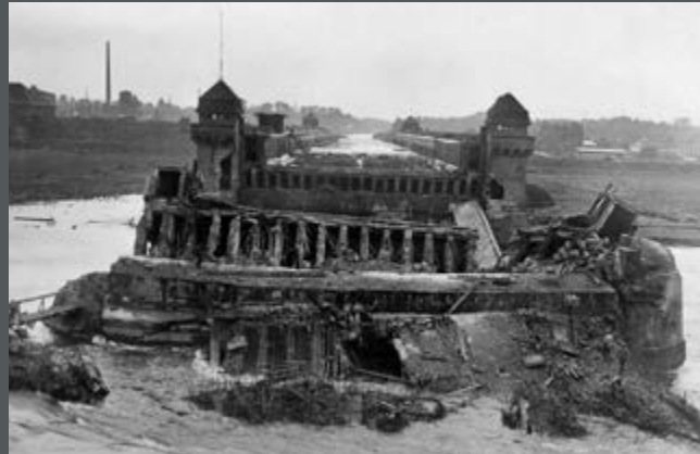
Bild 350: Die Kanalbrücke Minden wurde 1945 von deutschen Truppen zerstört. Der Wiederaufbau begann 1947. (1945)
