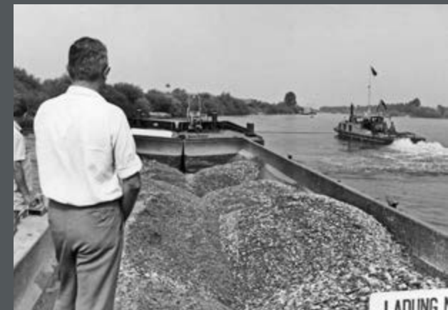
Bild 405: Erprobung einer Hydroklappschute an der Donau. (1967)
