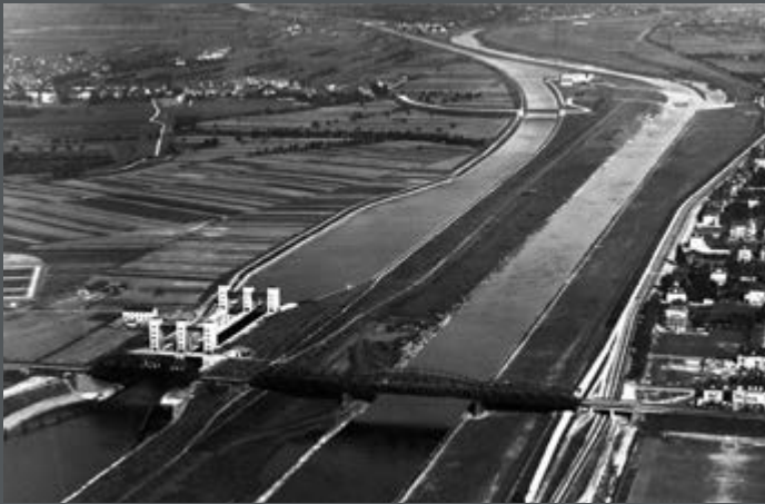
Bild 117: Luftbild der Schleuse Feudenheim am Neckar mit Riedbahnbrücke und Kraftwerk im Hintergrund. (1928)
