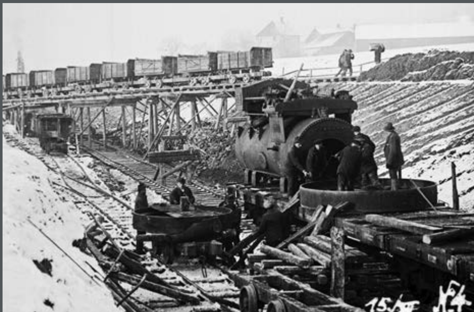
Bild 384: Der Abtransport des Aushubs beim Bau der alten Staustufe wird gleisgebunden mit Loren vorgenommen. Im Vordergrund die Zugmaschine. (1922)
