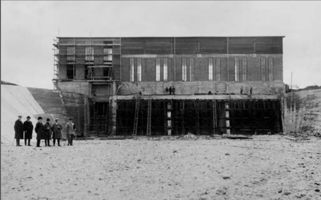
Bild 280: Vor dem Kraftwerk Schwabenheim am Neckar posieren Planer und Bauleiter auf der vorbereiteten Oberwassersohle. (1925)
