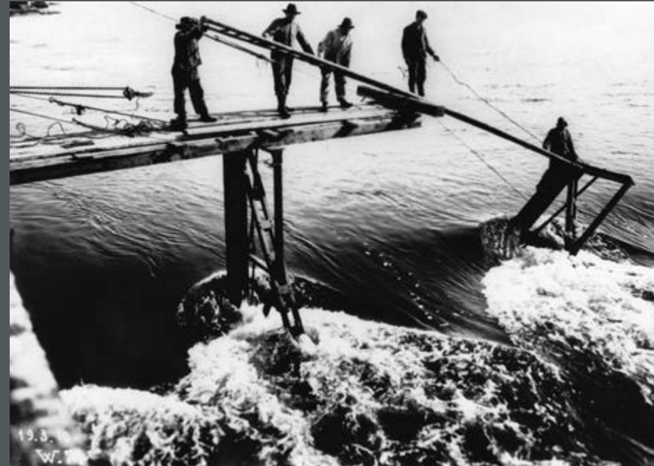
Bild 230: Sohlbefestigung im Oberwasser des alten Weserwehrs Bremen. (1908)
