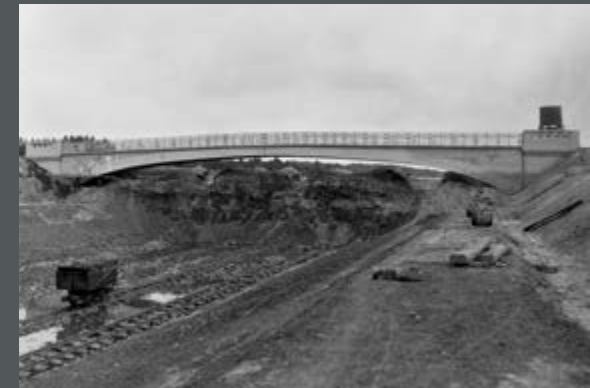
Bild 357: Fertige Brücke Kohlenweg beim Bau des Mittellandkanals, der hier noch ausgebaggert wird. (1913)
