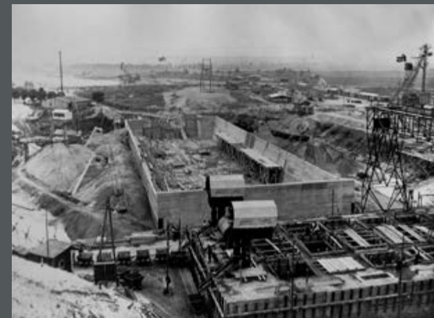
Bild 435: Hinterfüllen der Hebewerksbaugrube. Fertige Senkkastenwände für den Ostpfeiler. (1929)
