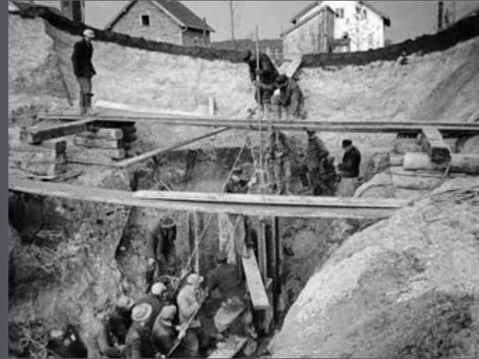
Bild 244: Mit einer Hand- ramme werden Arbeiten zur Gründung des Pegelschachtes für den Schreibpegel Pfelling an der Donau durchge- führt. (1951)
