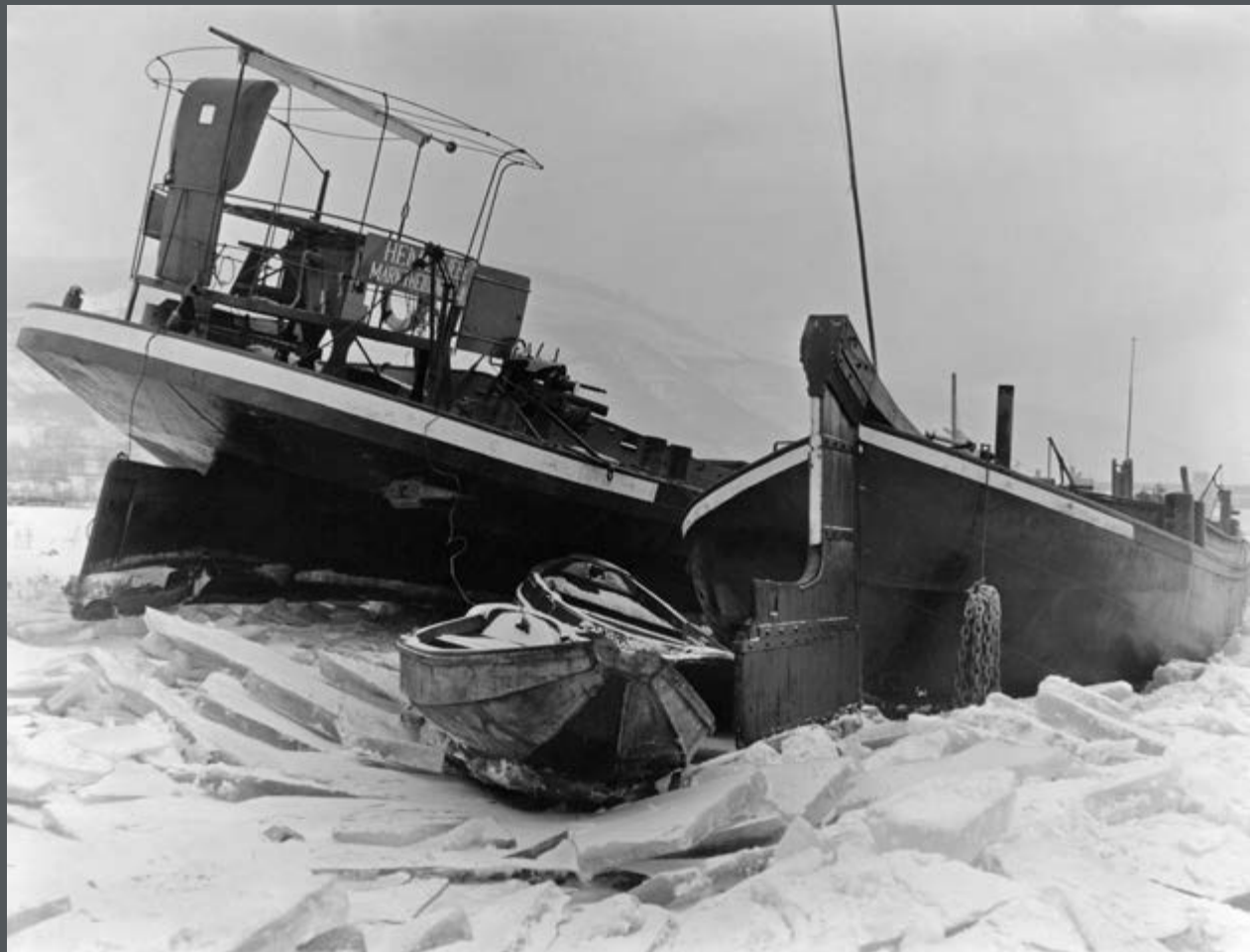
Bild 81: Durch Eisschub an Land gesetzte Schiffe am Schiffslicheplatz der Staustufe Erlabrunn am Main. (1955)
