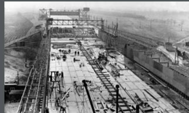
Bild 450: Blick auf die Kanalbrückenbaustelle. Links das Sicherheitstor als westliches Ende der Kanalbrücke. Am Hang die hölzerne Stützkonstruktion für die Brückenträger. (1932)
