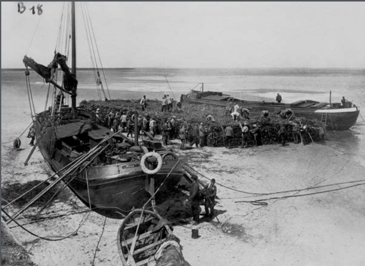
Bild 274: Der Begriff Wasserbau umfasst letztlich alle Bauarten, die auf den vorangegangenen Seiten 96 bis 113 beschrieben werden. Hier sollen daher überwiegend die Arbeiten am Ufer und der Sohle betrachtet werden. Ein fertiges Sinkstück wird nach seiner Herstellung von beidseitig liegenden Flachbooten im Seebereich der Nordfriesischen Inseln entladen. (1937)
