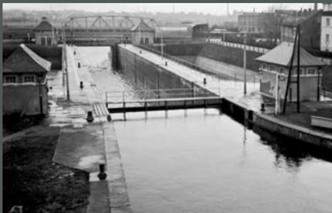
Bild 348: Untere Schleuse am Wasserstraßenkreuz Minden, Oberhaupt im Vordergrund geschlossen, Unter- haupt geöffnet. (1926)
