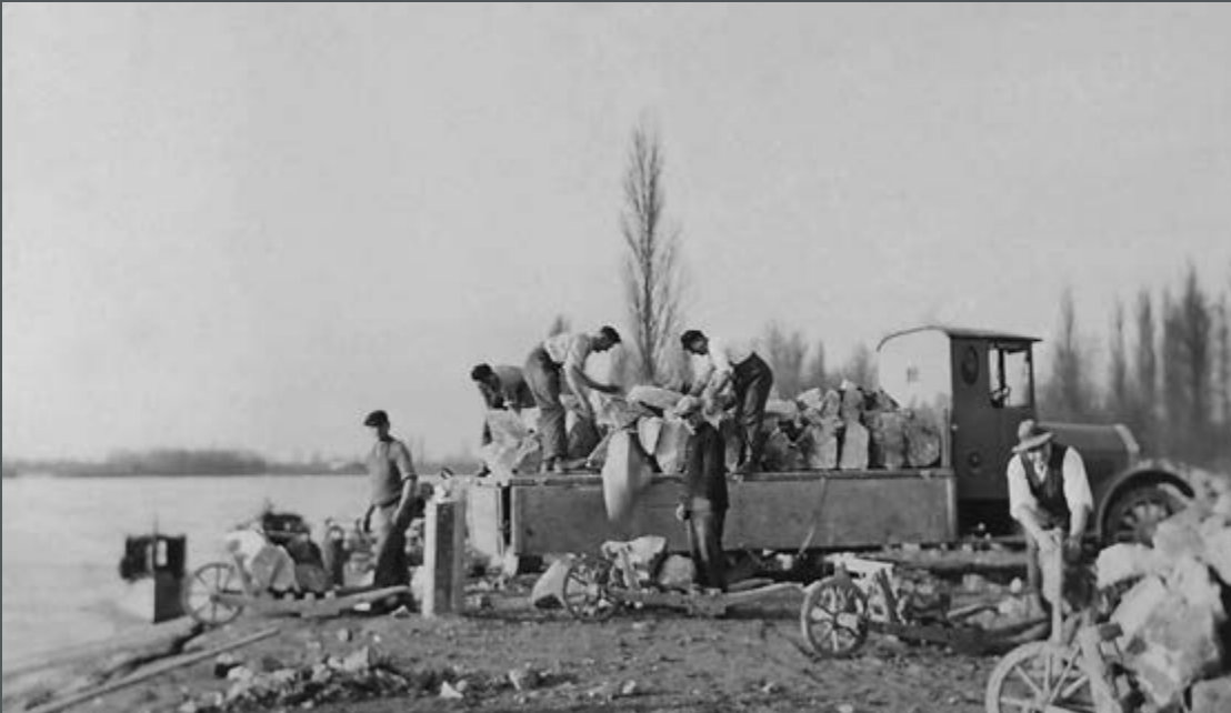
Bild 284: In Säcke gepackte Steine für die Sanierung von Buhnen werden mit einem LKW zu einem Lagerplatz bei Breisach am Rhein gefahren und auf Schubkarren abgeladen. (1932)
