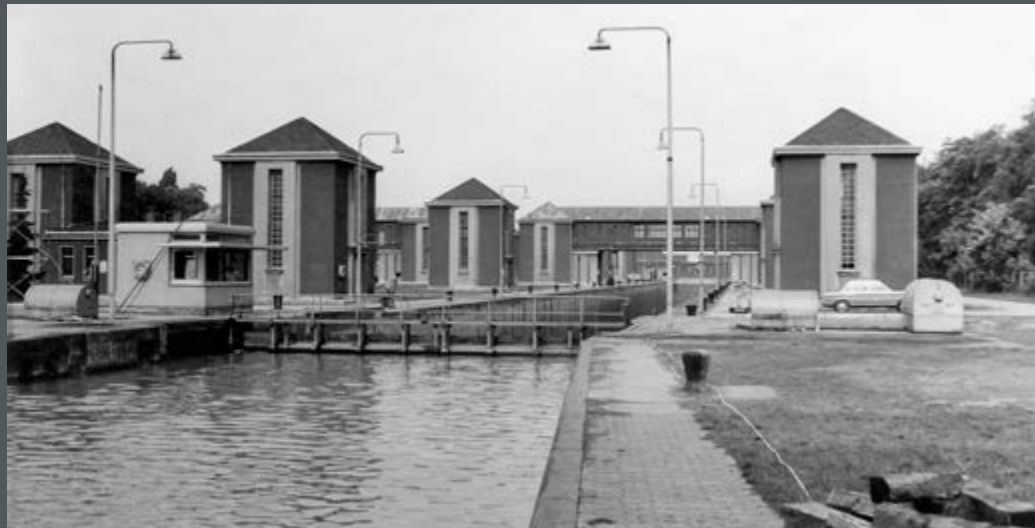
Bild 364: Blick vom Oberwasser auf die Schleuse Anderten (Hindenburgschleuse). Die zum Füllen und Entleeren der Sparbeckenschleuse (fünf Ebenen in verbreiterten Kammermauern) notwendigen Ventile sind in Türmen ähnlichen Ventilhäuschen untergebracht. (1962)
