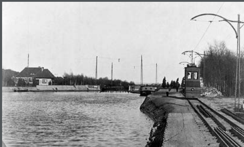
Bild 425: Blick vom oberen Vorhafen der Schleuse I auf das Oberhaupt. Rechts im Bild eine der sechs benötigten Treidellocks für den taktmäßigen Ablauf des Schleusungsvorgangs mit einer Dauer von insgesamt rund 90 Minuten. (1929)
