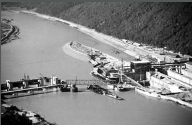
Bild 408: Blick donauaufwärts auf die gesamte Baustelle mit Wehr (links) und Schleuse (rechts). Die Schiffahrtsrinne befindet sich im Kraftwerksbereich. (1954)
