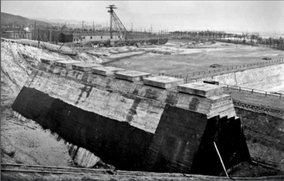
Bild 436: Ostpfeiler nach Fertigstellung vor Hinterfüllung und Verblendung. (1930)
