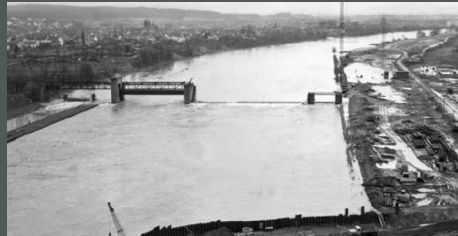
Bild 68: Überflutete Baustelle der Staustufe Kleinostheim am Main beim Hochwasser im Dezember 1966.
