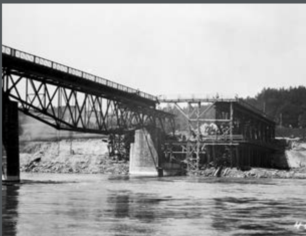
Bild 381: Teile der alten, 1890 fertiggestellten Brücke Steinbach, die wegen des Staufstufenbaus umgebaut werden musste. Davor der Aufbau der neuen Brücke. (1924)
