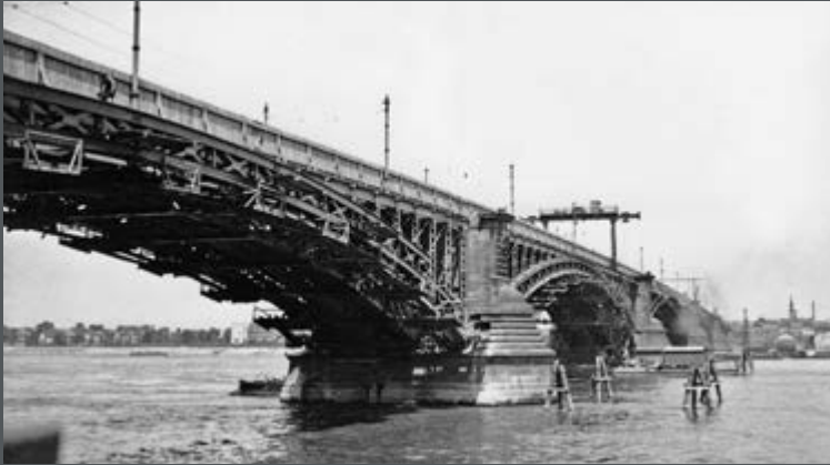
Bild 172: Die Rheinbrücke Mainz-Kastel wurde 1885 eingeweiht, bis 1912 wurde Brückenzoll an den „Oktroi-Häuschen“ bezahlt. Von 1931 bis 1934 wurde die Brücke um fünf Meter verbreitert, 1945 wurde sie gesprengt und von 1948 bis 1950 neu errichtet. Danach hieß sie Theodor-Heuss-Brücke. (1932)
