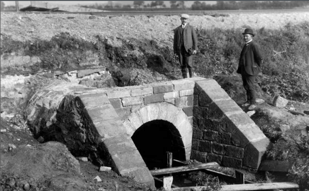
Bild 188: Blick in den vierten Stollen der Edertalsperre, der den Grundablass aufnimmt. (1912)
