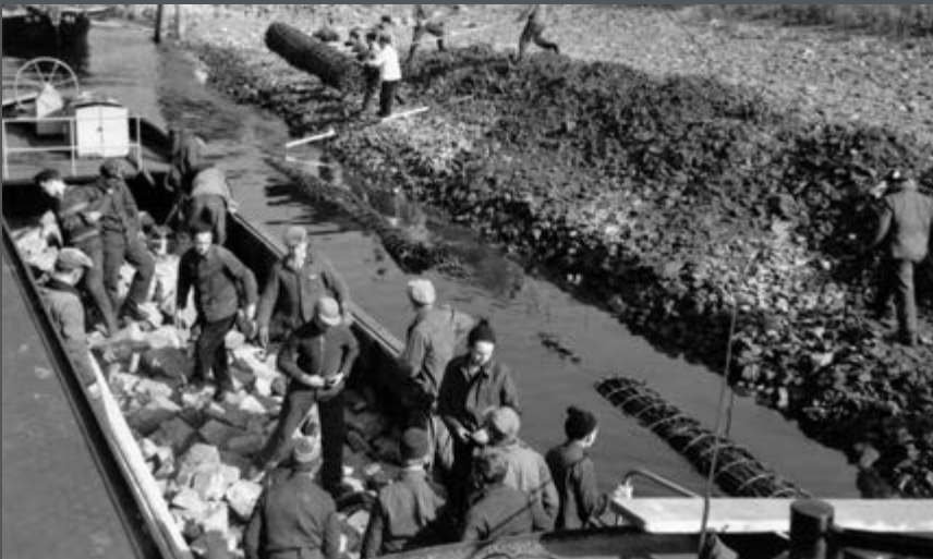
Bild 286: Eine Senkfaschine wird ans Ufer gebracht. Die am Kranschiff hängende Steinschute befördert Wasserbausteine zur späteren Beschwerung der Faschine im Rhein. (1959)
