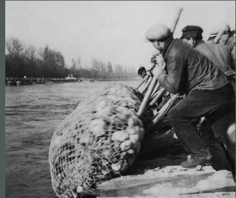
Bild 285: Eine drahtumhüllte „Wacknwurst“ (mit Grauwacken-Steinen gefüllt) wird bei Breisach am Rhein als Sohlen- und Uferschutz zu Wasser gelassen. (1932)
