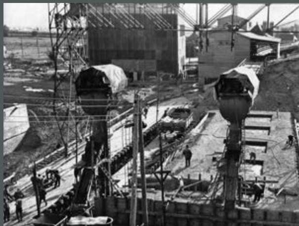
Bild 434: Senkkasten des Ostpfeilers der Kanalbrücke von Norden gesehen. (1929)
