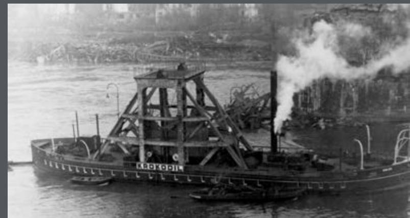
Bild 20: Taucherschacht „Krokodil“ aus dem Jahr 1890 beim Räumen der Sohle an der Pfaffendorfer Brücke am Rhein.
