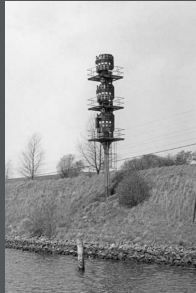
Bild 55: Signalanlage bei der Weiche Groß-Nordsee im Nord-Ostsee-Kanal. (1963)
