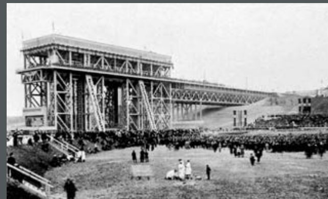
Bild 445: Eröffnungsfeier der Bauwerke des zweiten Abstiegs am 21. März 1934.
