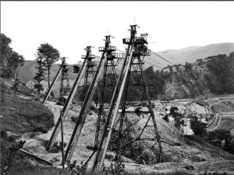
Bild 104: Die Verankerung der Masten der Transportseilbahn („Luftseilbahn“ der Firma Heise, Dortmund) und die Baustelle. (1911)
