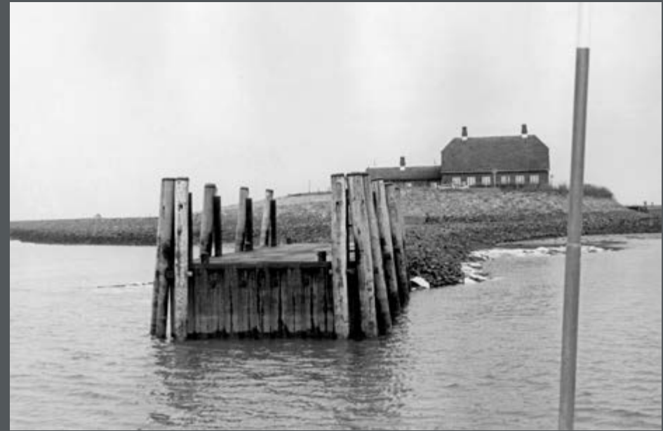
Bild 47: Niedrigwasseranleger auf der Hallig Langeneß in der Nordsee. (1964)
