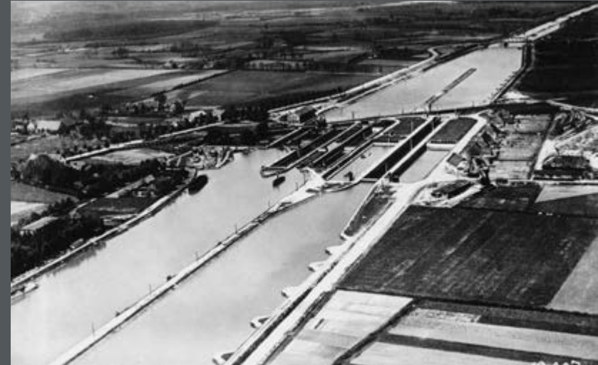
Bild 123: Luftbild der Schleusengruppe Münster am Dortmund-Ems-Kanal. Es handelt sich um eine Kanalstufe. In solchen Stufen gibt es konstante Wasserspiegel. (1926)
