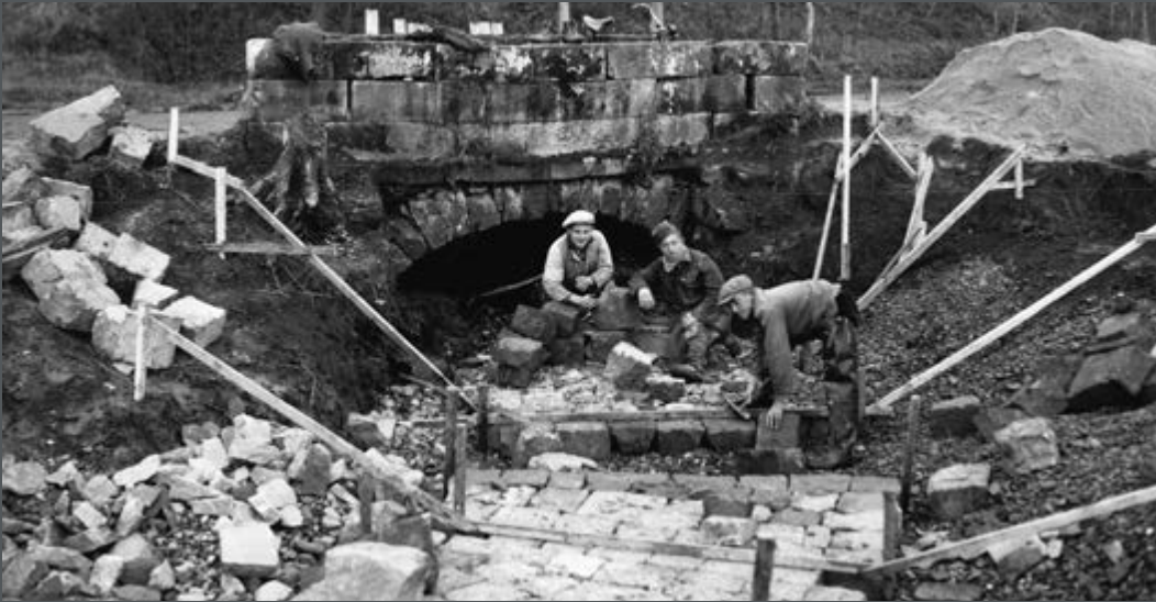
Bild 259: Ausbau der Lochbachbrücke Eltmann - Sand bei der Schleuse Limbach am Main. (1940)
