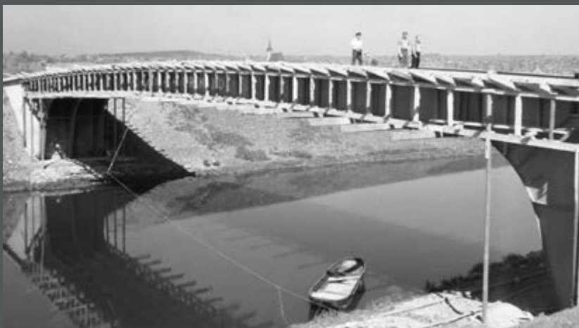
Bild 170: Bau der Feldwegbrücke über den Neckar oberhalb Pleidelsheim. (1953)
