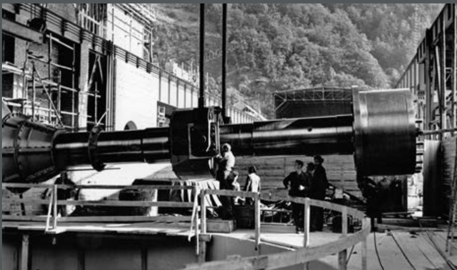
Bild 412: Blick vom rechten Ufer auf die Montage der Turbinenwelle für das Kraftwerk. (1954)
