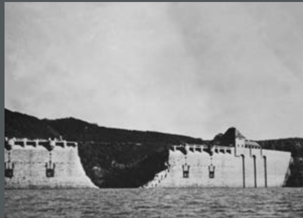
Bild 115: Im Mai 1943 wurde die Talsperre durch einen Fliegerangriff zerstört. Das gesprengte Teilstück war 60 Meter lang und bis zu 22 Meter tief. (1943)
