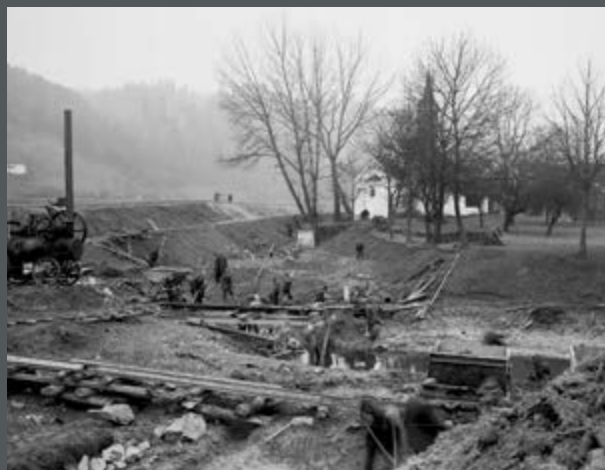
Bild 382: Wegen des Aufstaus der Donau im Oberwasser der Staufstufe musste der Grundwasserzstrom durch die Wasserläufe mit Sammelweiher gefasst und in die Donau gepumpt werden. Hier Bau des Weihers Gaishofen am linken Ufer. (1924)
