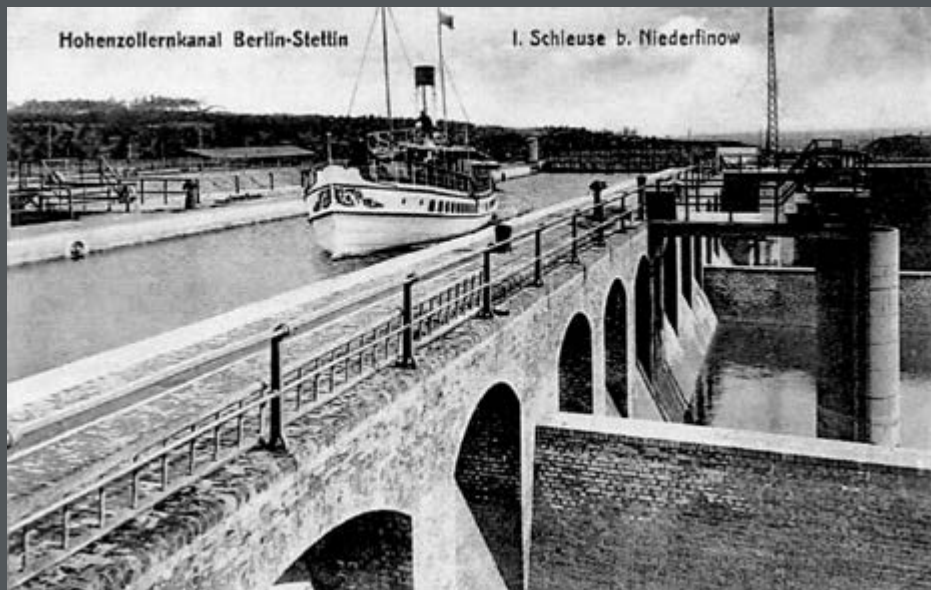
Bild 418: Blick auf die oberste Schleuse I nach Fertigstellung. Auf der rechten Bildhälfte die Sparbecken mit Schwimmern. Die Schleusenammer hat wie alle Schleusen die Abmessung B/L = 10/67 Meter und beidseitig je drei Sparbecken. (1915)
