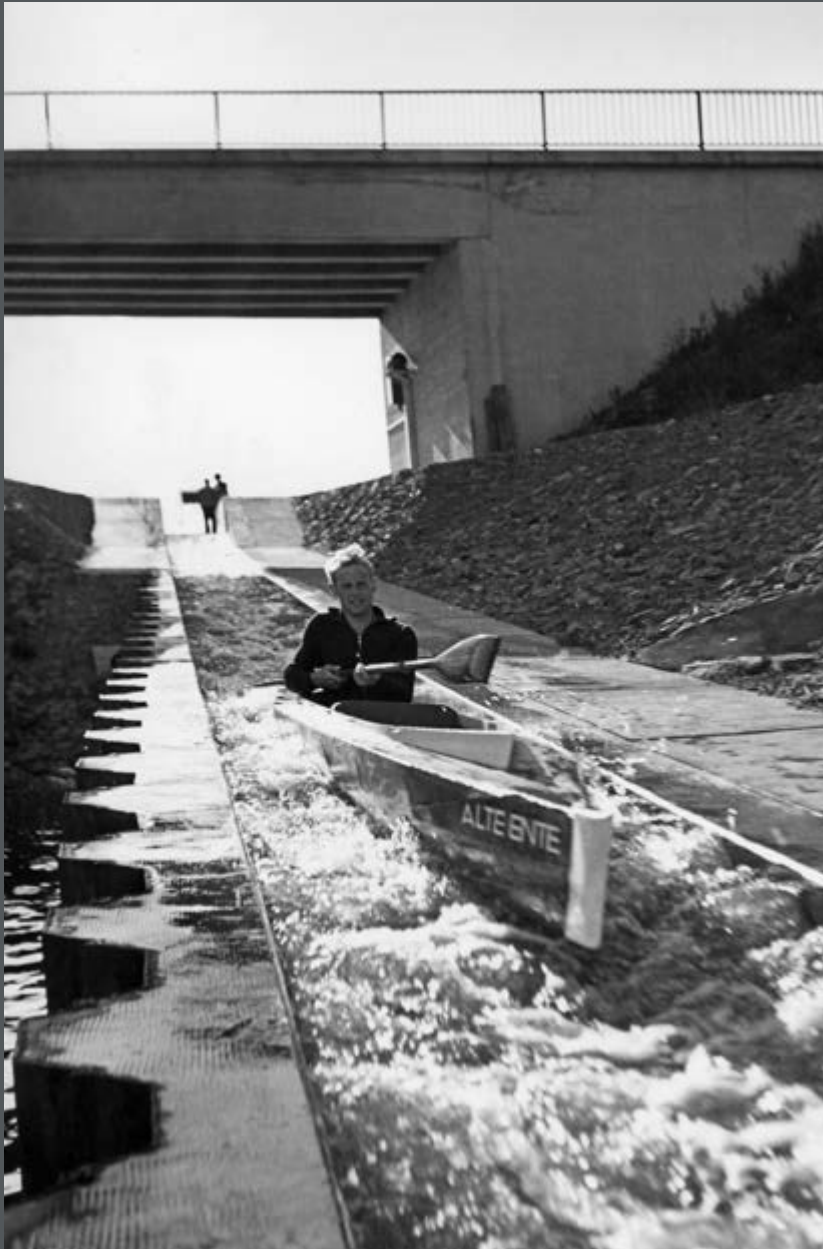
Bild 214: Bootsgasse der Staustufe Drakenburg an der Weser. (1955)
