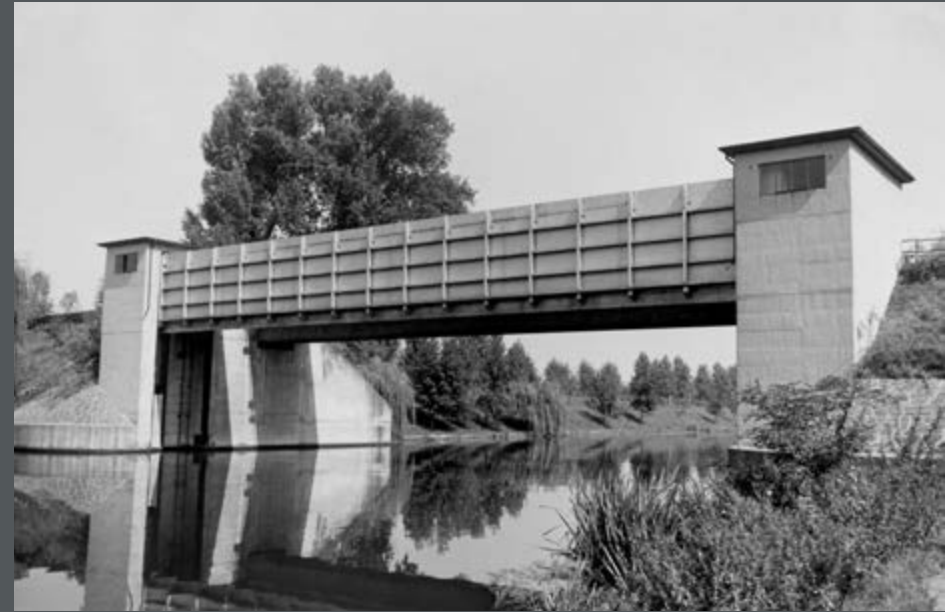
Bild 209: Hochwassersperrtor Heilbronn am Neckar von 1952. (1961)
