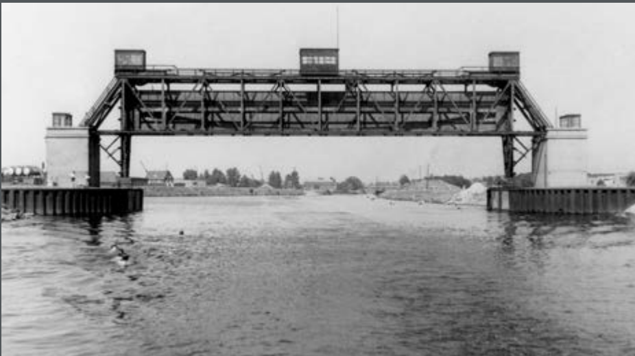
Bild 210: Alte Sicherheitstoranlage von 1936 im Verbindungskanal zwischen Ruhr und Rhein-Herne-Kanal, von dem heute noch ein Restbauwerk vorhanden ist. (1952)
