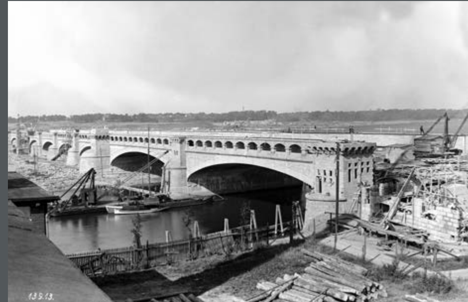
Bild 344: Südsicht der Kanalbrücke mit Widerlager Ost. Das Hilfspumpwerk südlich des Widerlagers ist im Bau, ebenso die Türme. (1913)
