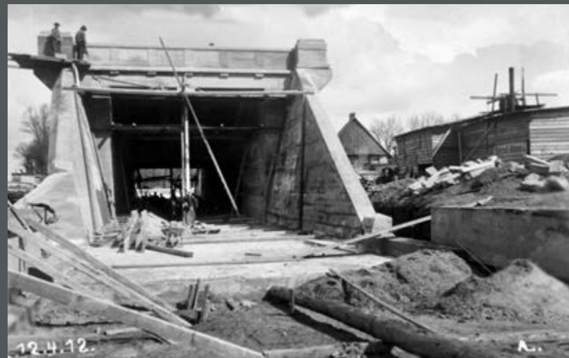
Bild 200: Bau der Kanalunterführung U164 alt von Minden nach Leteln, Südseite. Das Unterführungsbauprodukt Friedrich-Wilhelm-Straße ist Teil der Kanalbrücke Minden des Mittellandkanals. (1912)
