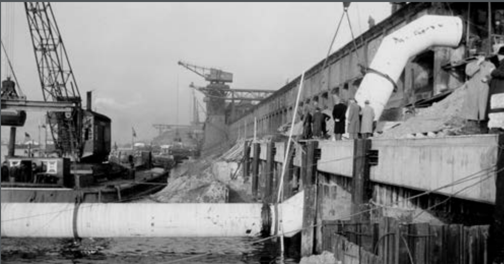
Bild 182: Verlegung einer Abwasser-Stichrohrleitung oberhalb der Duisburger Kupferhütte im Rhein. (1953)
