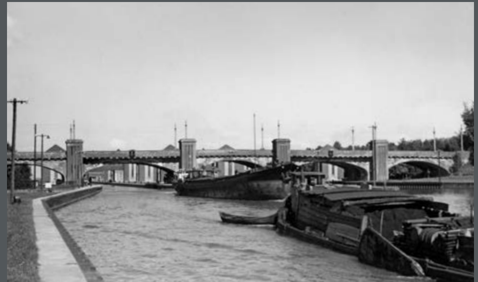
Bild 362: Einfahrt eines Frachtschiffes in die Schleuse Anderten. Blick vom oberen Vorhafen auf die Kanalbrücke und die Oberhäupter. (1955)
