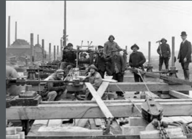
Bild 253: Bau des nördlichen Absenkbrunnens im Strompfeiler beim Bau der alten Kanalbrücke Minden am Mittellandkanal. Die Senkbrunnen entsprechen den heutigen Caissons. (1911)
