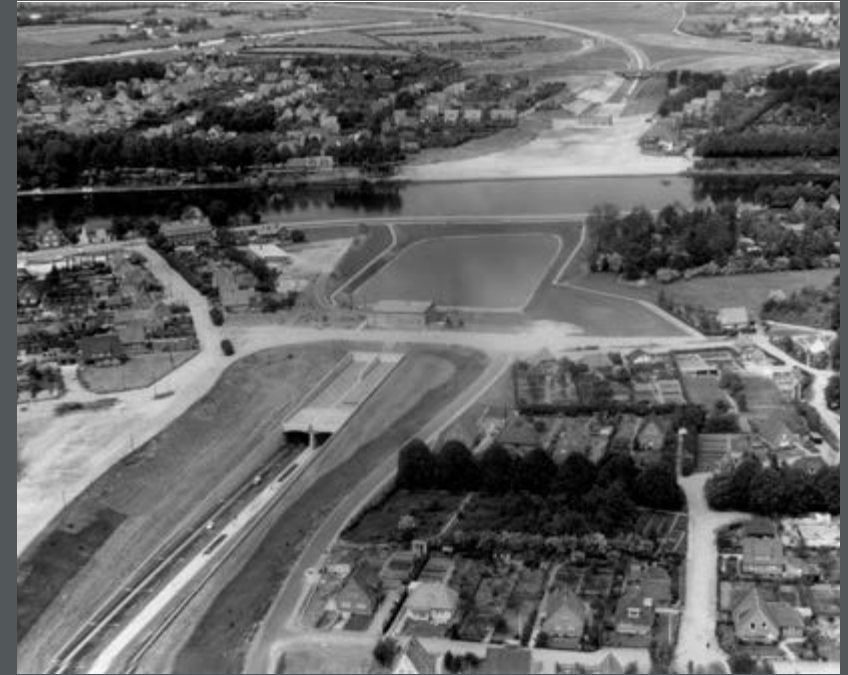
Bild 196: Der 640 Meter lange Straßentunnel Rendsburg unter dem Nord-Ostsee-Kanal (Bildmitte) kurz vor der Fertigstellung. (1961)
