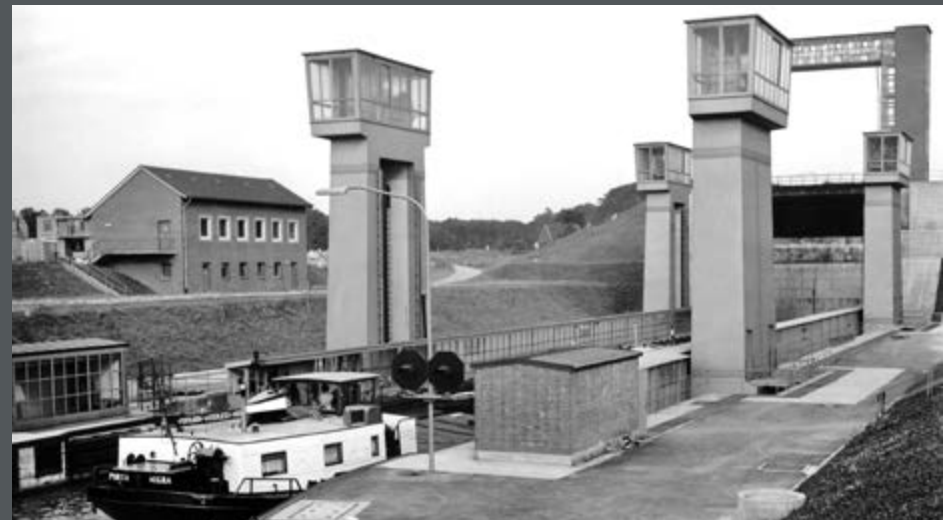
Bild 157: Das neue Schiffshebewerk Henrichsburg nach Fertigstellung. Ein Schiff verlässt den abgesenkten Trog. (1963)
