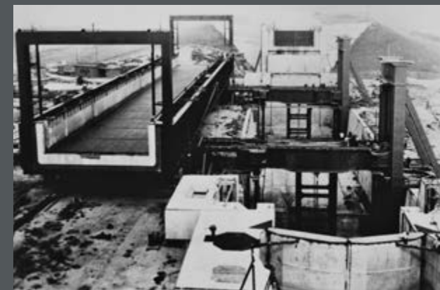
Bild 164: Der Stahltrug des Hebewerks Rothensee wird über die Schwimmerschächte eingefahren, Blick nach Unterwasser. (1938)
