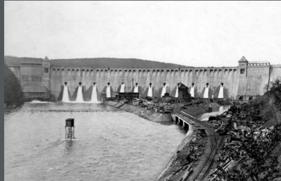
Bild 113: Die fertige Talsperre von der Talseite aus, die 12 Notauslässe sind in Betrieb. Rechts unten der Kraftwerksauslauf Hemfurth. (1914)
