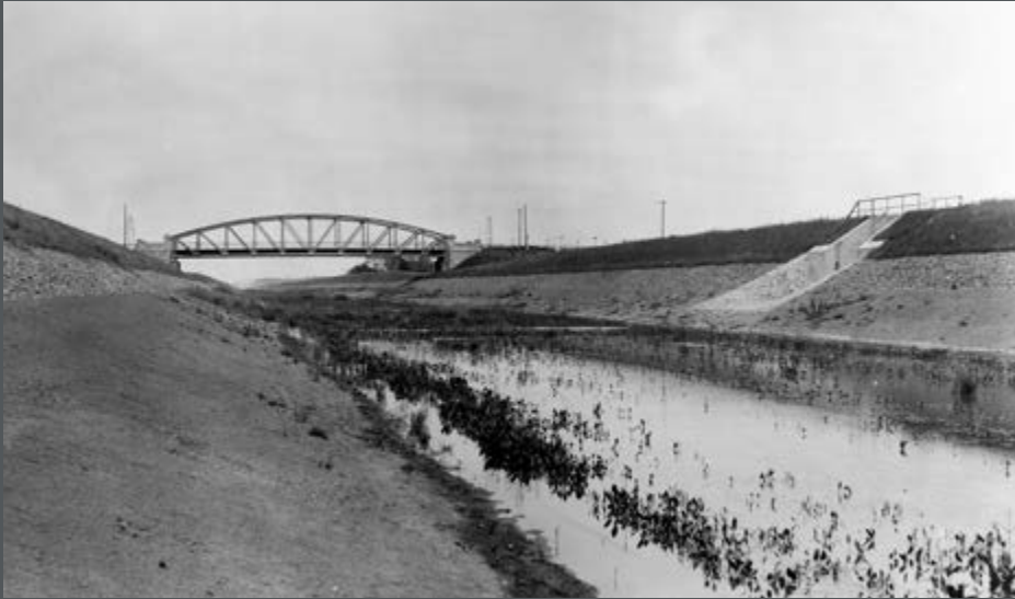
Bild 359: Das fertiggestellte Kanalbett des Mittellandkanals mit gepflasterter Uferböschung, im Hintergrund die Nienbrügger Brücke. (1915)
