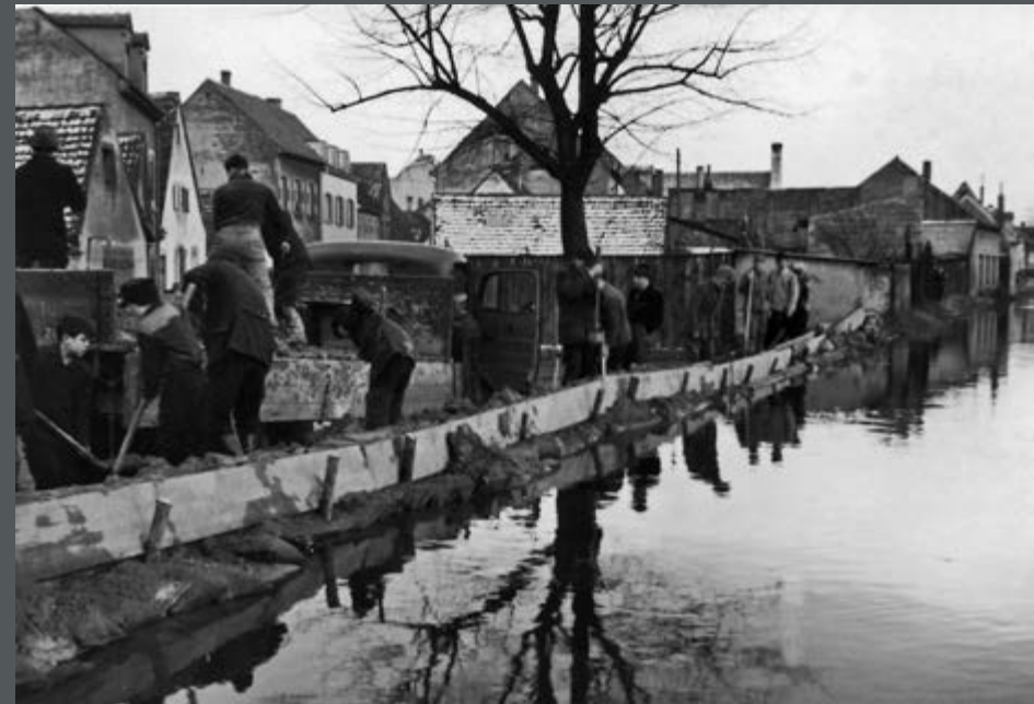
Bild 66: Beim Hochwasser 1955 in Speyer am Rhein werden Sicherungsarbeiten gegen Überflutung durchgeführt.
