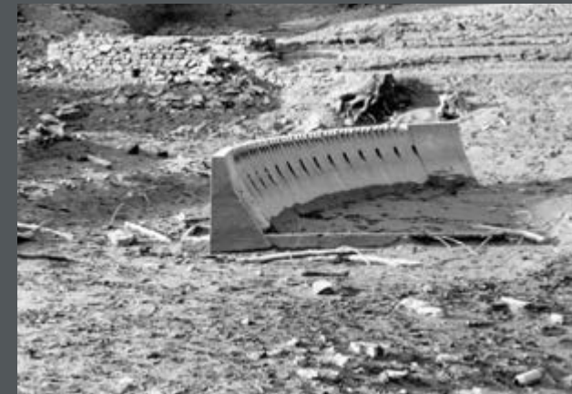
Bild 116: Modell (Maßstab = 1:40) der Sperrmauer an der Bericher Hütte nach Ablassen des Stausees auf NN +219,48, d. h. Modell und Hütte liegen bei Vollstau etwa 25 Meter unter Wasser des Stausees. (1954)
