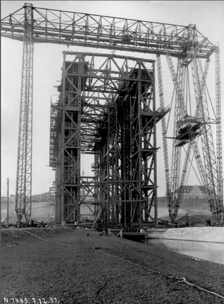
Bild 439: Hochziehen des Prellträgers. (1931)
