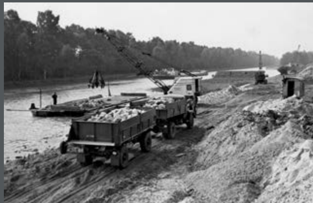
Bild 352: Beladung eines Schüttgerüsts zum Einbringen von schweren Steinen zur Sohlstabilisierung beim Ausbau des Mittelland- kanals bei Mettingen. (1966)
