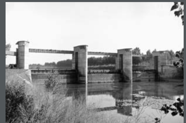
Bild 326: Wehr Horkheim von Unterstrom. (1961)
