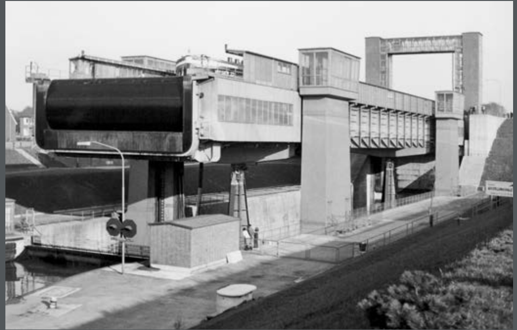
Bild 159: Trog des neuen Schiffshebewerks Henrichsburg auf halber Höhe von Unterwasser. (1965)
