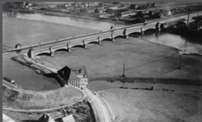
Bild 351: Kanalbrücke Minden über die Weser, im Vordergrund das Pumpwerk. (1950)
