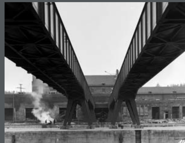
Bild 383: Die Kabelbrücke, von der Schleusenmittelmauer aus gesehen, überquert beide Schleusen (hier die Nordschleuse), im Hintergrund das Umspannwerk. (1927)
