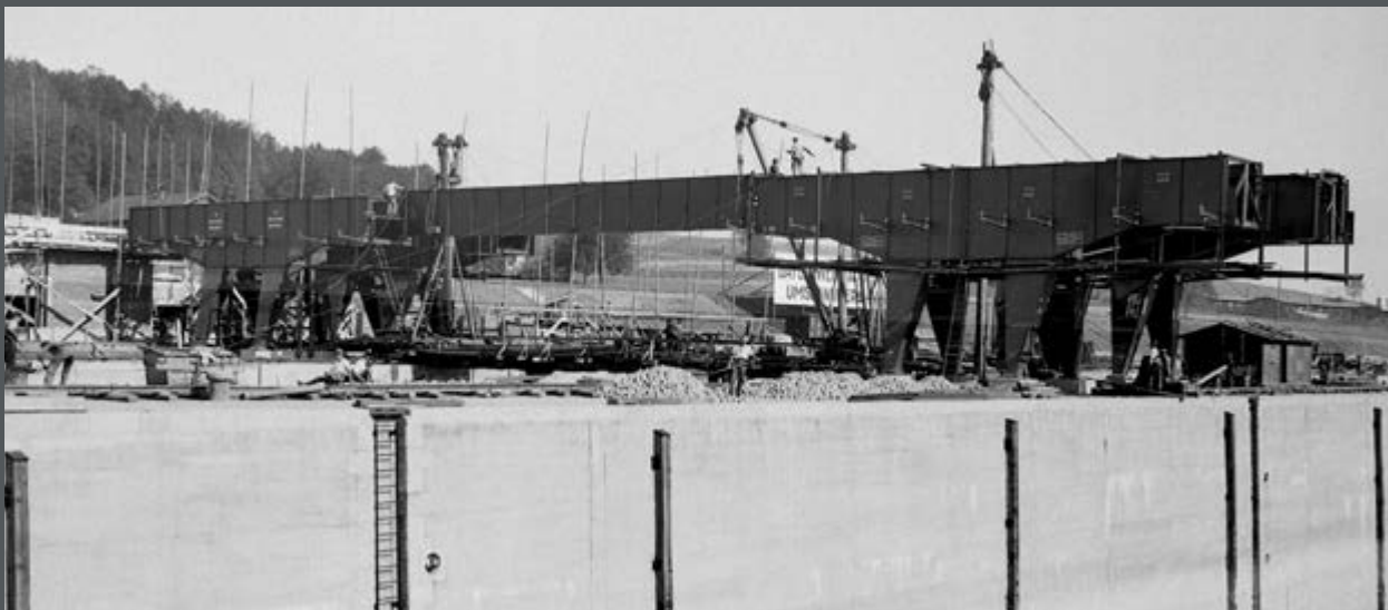
Bild 396: Eine doppelte Kabelbrücke (Kabelsteg, Kranbrücke) überquert eine Schleusenammer. (1926)
