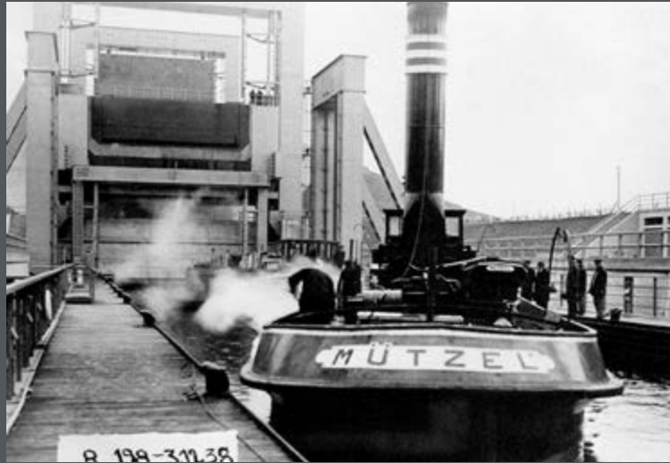
Bild 374: Schiffshebewerk Rothensee im Bau. Ein Schlepp- kahn und ein Schlepper haben den Trog fest- gemacht. (1938)
