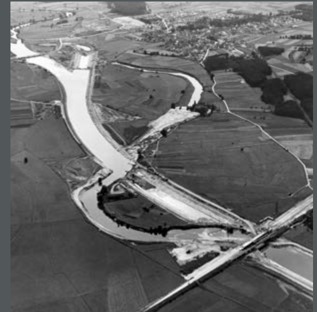
Bild 191: Bau der Staustufe Hausen am Main-Donau-Kanal, Streckenausbau bei Straßenbrücke B 470 (unten rechts). Die Regnitz ist hier Teil der Wasserstraße. (1965)
