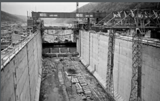
Bild 409: Die Schleusenkammer der Doppelkammerschleuse Jochenstein auf deutschem Staatsgebiet im Bau. (1954)
