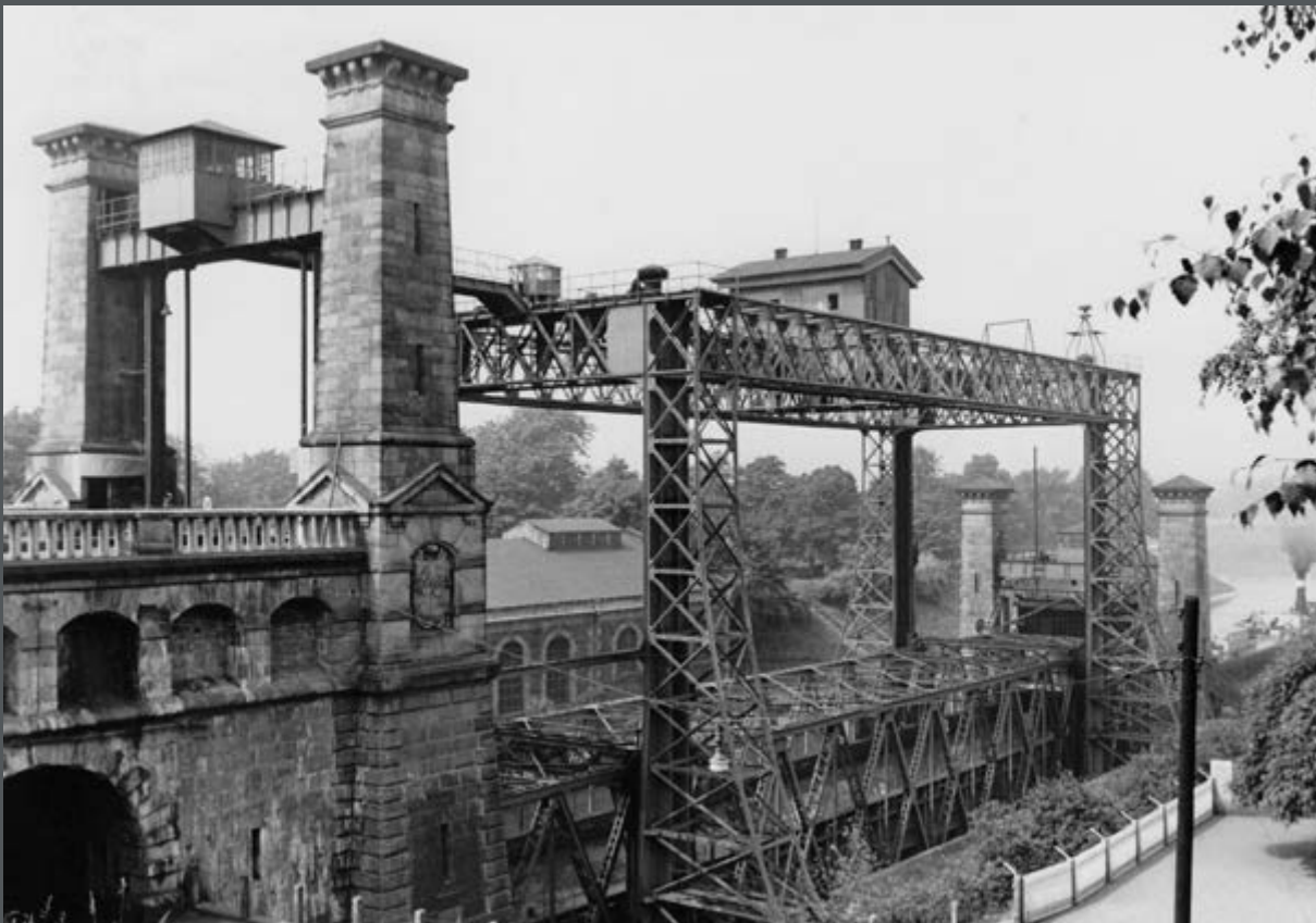
Bild 152: Erstes Abstiegsbauwerk zum Dortmund-Ems-Kanal – das alte Schiffshebewerk, Blick aufs Oberhaupt. (1900)
