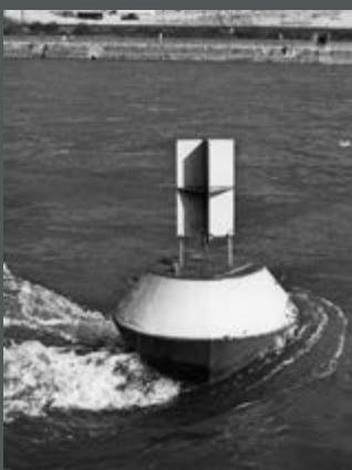
Bild 57: Eine spezielle Tonne wird im Bereich des Binger Lochs am Rhein zur Fahrwassermarkierung erprobt. (1969)
