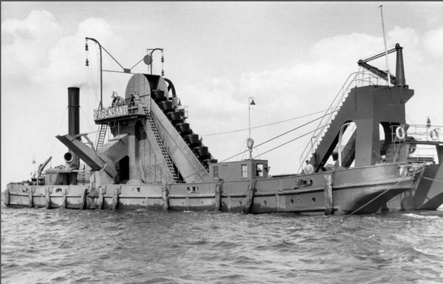
Bild 31: Die Arbeiten im Wasserbau erfordern schwimmende und/ oder fest zu verankernde Fahrzeuge. Beispiel: Eimer- kettenbagger „Pagensand“ im Einsatz auf der unteren Elbe. (1952)
