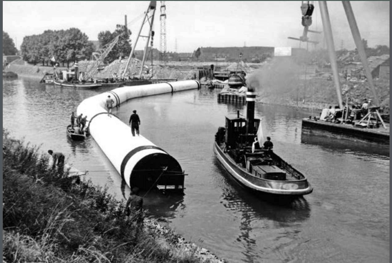
Bild 179: Düker (gelegentlich Syphon genannt) und Durchlässe im wasserbaulichen Sinne werden benötigt, wenn ein Gewässer unter Druck (Düker) oder frei fließend (Durchlass) unter einem Bauwerk durchgeführt wird. Der Durchlass ist allerdings per Definition auf eine lichte Weite von weniger als 2 Meter begrenzt (sonst Brücke genannt). Beim Bau von Kanälen werden unzählige beider Typen benötigt, die bei Kanalverbreiterungen wieder verändert werden müssen. Im Bild der Neubau des Berne-Dükers am Rhein-Herne-Kanal, Anschleppen eines Dükerrohrs zur Einbaustelle. (1952)
