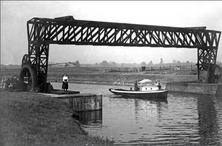
Bild 208: Altes Sperrtor Henrichsburg am Rhein-Herne-Kanal kurz vor der Einmündung in den Dortmund-Ems-Kanal, inzwischen abgebrochen. (1949)
