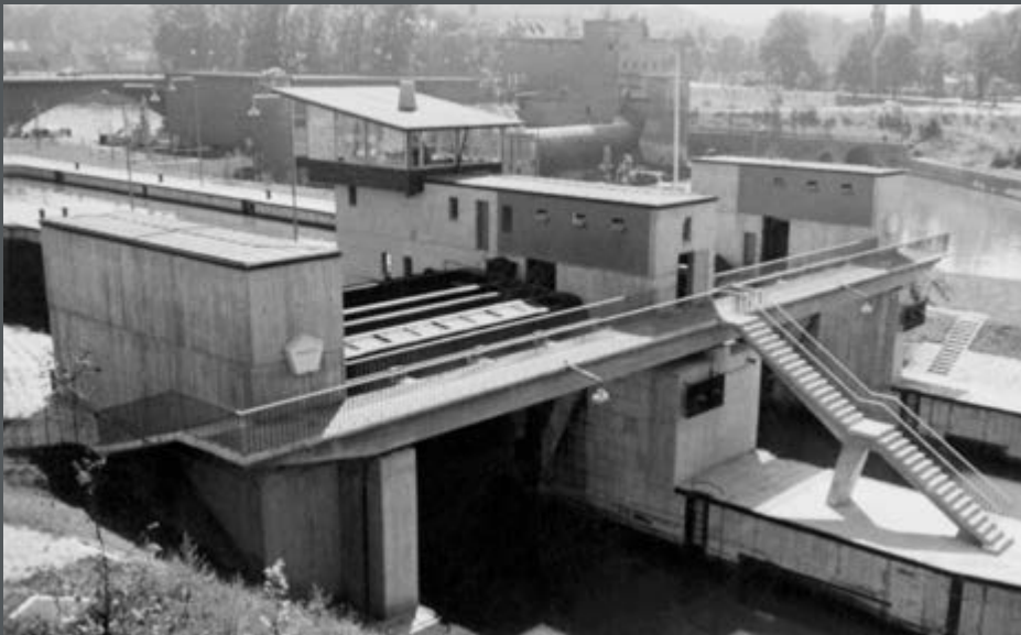
Bild 337: Unterhaupt der Doppelkammerschleuse Bad Cannstatt. (1958)
