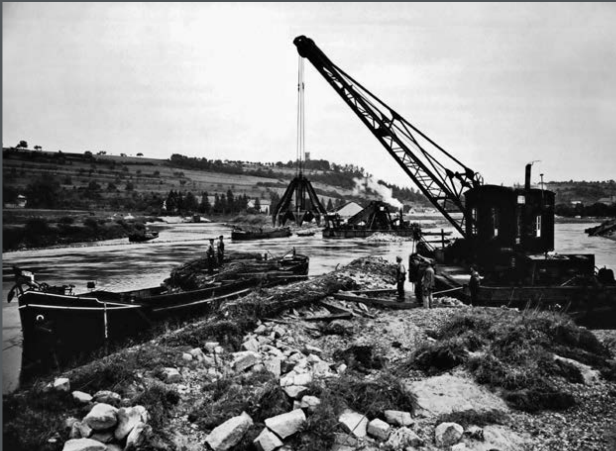
Bild 90: Flüsse als natürliche Wasserstraßen wurden schon immer durch Regulierungen verändert, damit sie sich als ganzjährig befahrbare und sichere Wasserstraßen eignen. Das Bild zeigt den Beginn des Durchstichs zum Bau der Staustufe Limbach am Main. (1940)
