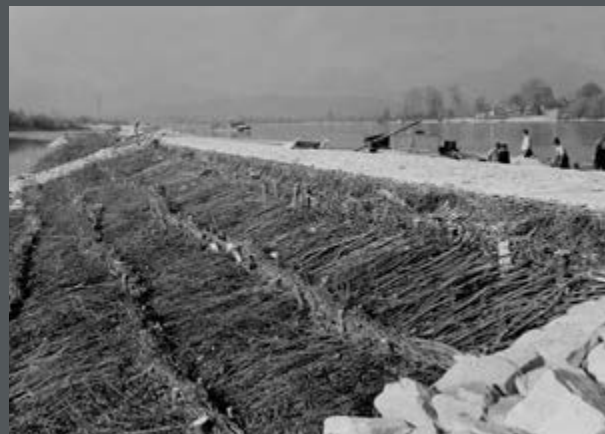
Bild 404: Herstellung des Lebendverbau an der landseitigen Leitwerkböschung bei Thundorf. (1953)
