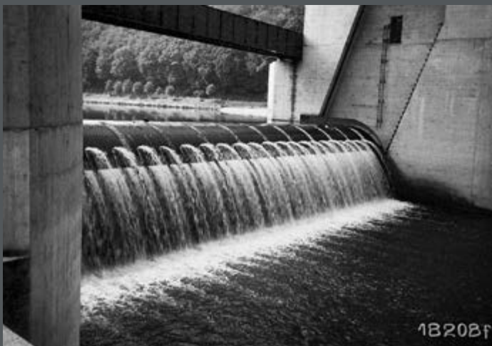
Bild 142: Überströmte Wehrwalze am Wehr Guttenbach am Neckar mit Strahlaufreißern. (1938)
