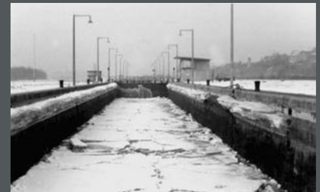
Bild 78: Die geschlossene, 40 cm dicke Eisdecke in der Schleusenkammer Ottendorf am Main wurde durch Absenkung des Wasserspiegels aufgebrochen. (1963)
