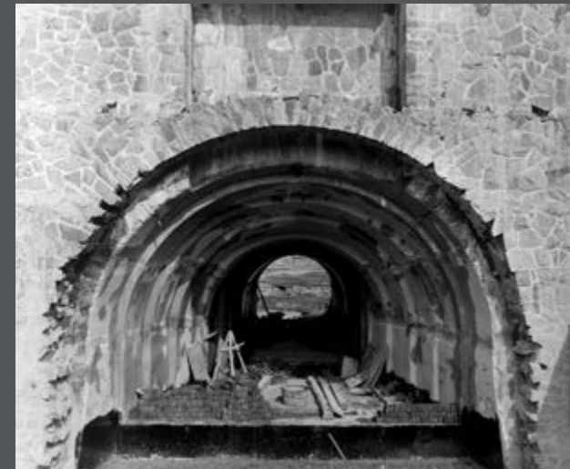
Bild 188: Blick in den vierten Stollen der Edertalsperre, der den Grundablass aufnimmt. (1912)
