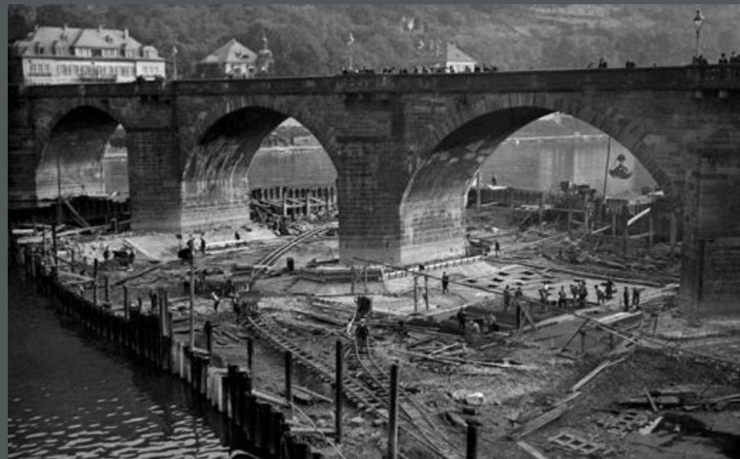
Bild 169: Sanierung der Fundamente der Alten Brücke (heute Carl-Theodor-Brücke) in Heidelberg am Neckar. (1924)
