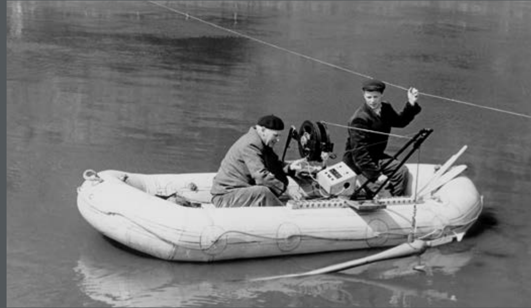
Bild 225: Messflügel im Einsatz am Altrhein, Messeinrichtung im Schlauchboot. (1965)
