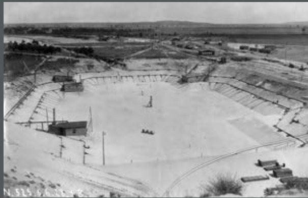
Bild 431: Blick auf die Baugrube im Juni 1928.
