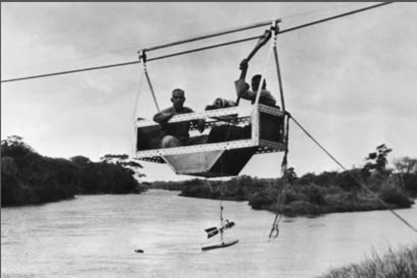
Bild 226: Messflügeleinsatz mit Zugseilbahn bei einer Dienstreise. (Südafrika, 1949)
