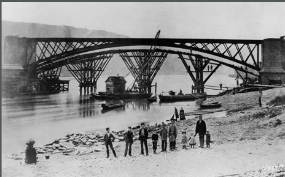
Bild 267: Die Eisenbahnbrücke zwischen Güls und Moselweiß an der Mosel im Bau. Die Holzschalung des stählernen Bogens wird abgenommen. (1877)
