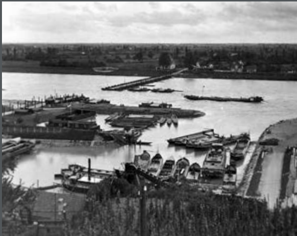
Bild 40: Der Bauhafen Breisach am Rhein mit Transport- und Motorbooten. Die Pontonbrücke ist für die Durchfahrt von Schiffen geöffnet. (1933)
