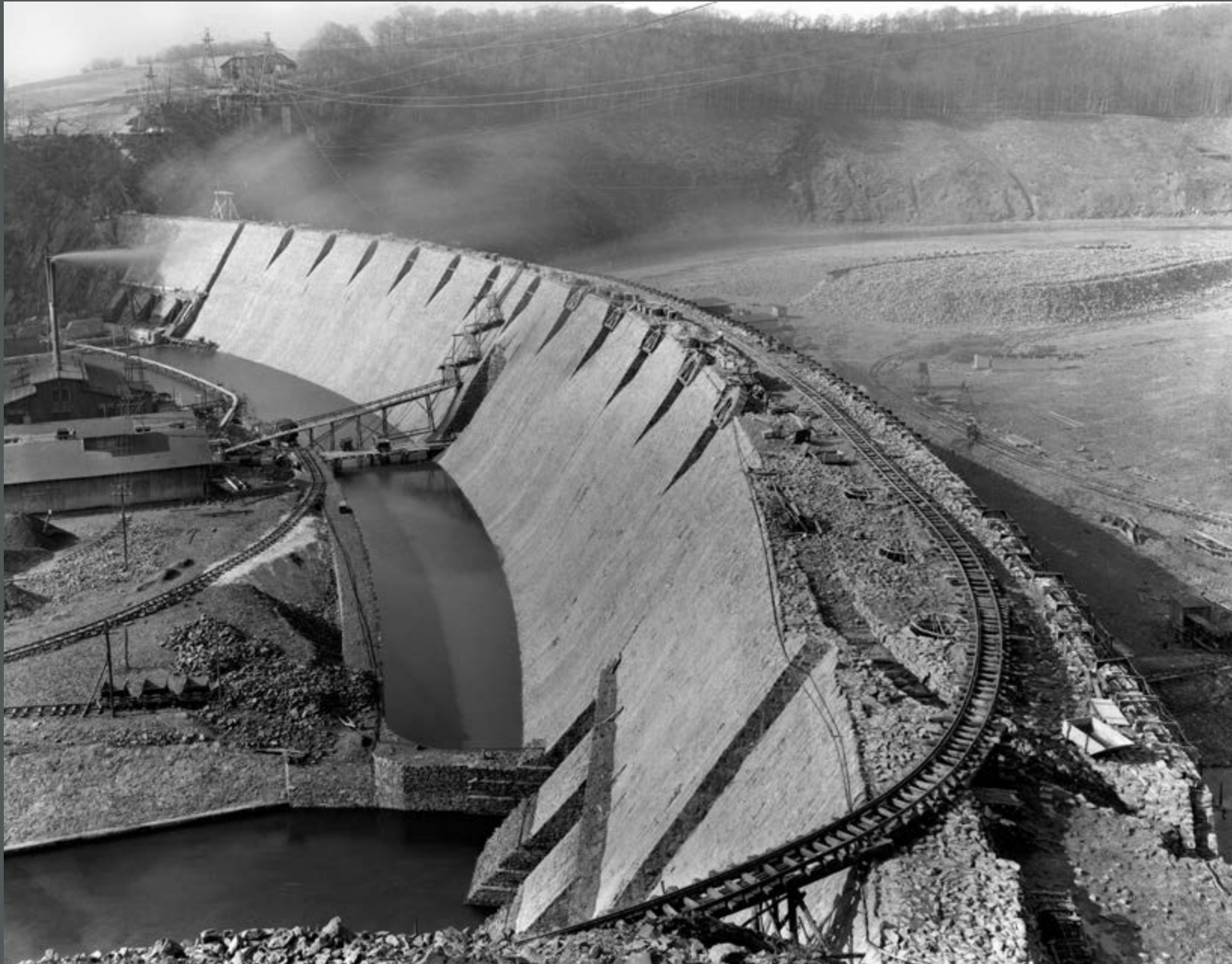
Bild 111: Luftseite der Mauer mit Untergraben und mit linken Durchlässen (im Vordergrund), die Eder mit Überlauf- vorrichtungen (im Hintergrund). Schienenbahnen auf der Mauer und im Unterwasser. (1913)
