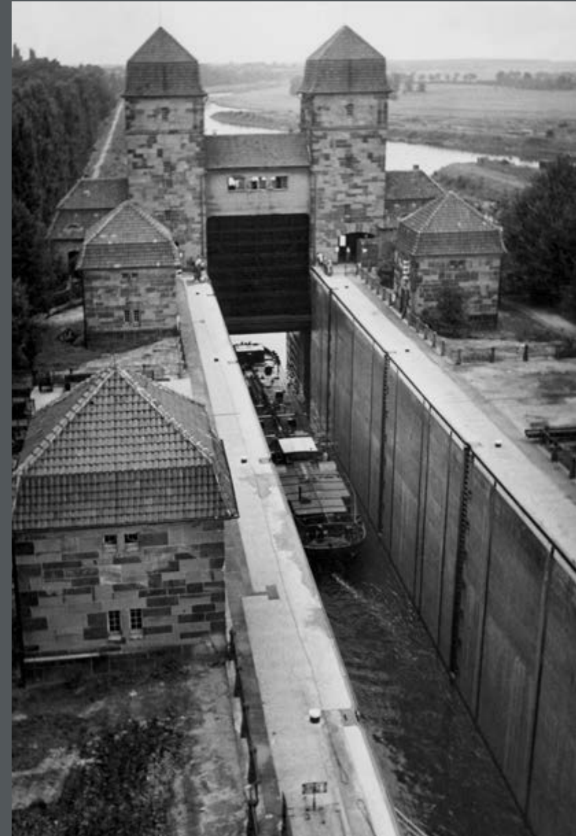
Bild 353: Die Verblendung der Schachtschleusen- kammer Minden wurde erneuert. (1950)
