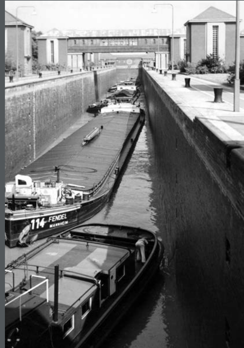
Bild 365: Blick in die Schleusenammer der Schleuse Anderten zum Unterhaupt mit geschlossenem Hubtor, in der Mitte die Brücke über die beiden Kammern. (1961)
