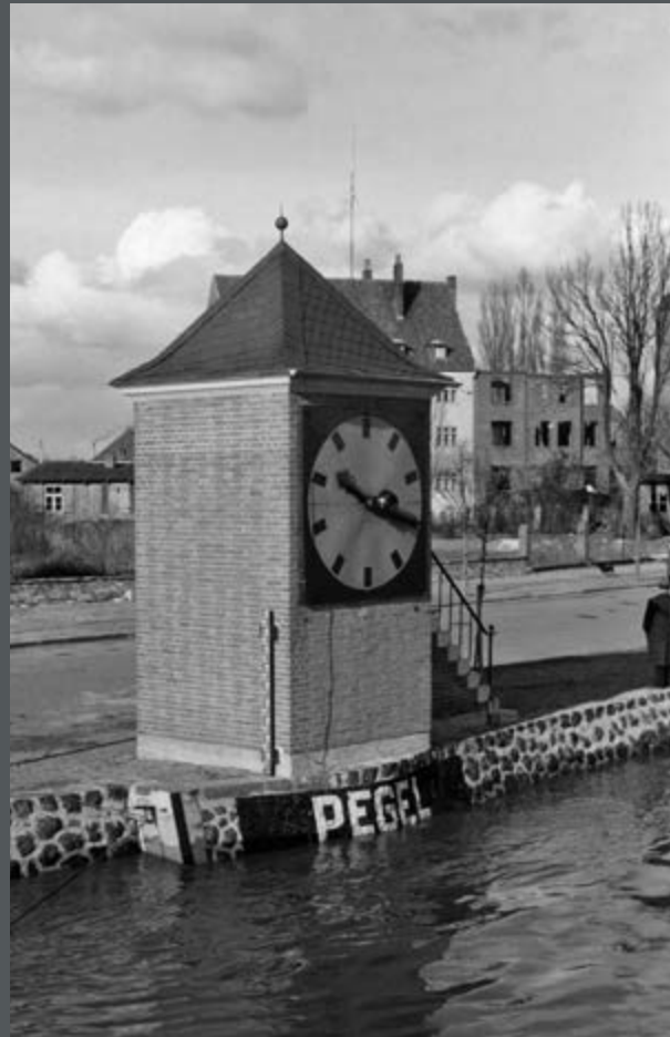
Bild 54: Das Pegelhaus (Grosßanzeigerpegel) Emmerich am Rhein mit Uhranzeiger bei Hochwasser. (1952)
