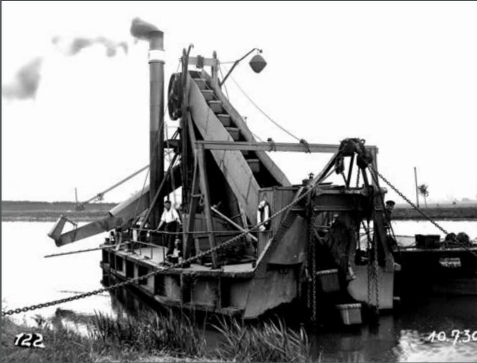
Bild 21: Dieser Löffelschwimmbagger kam schon 1911 beim Bau des Mittellandkanals zum Einsatz. (1930)
