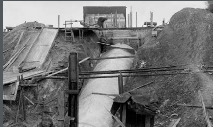
Bild 183: Bau des Dükers Pollhager Dorfgraben unter dem Mittellandkanal, das Dükerrohr ist fertiggestellt. (1913)
