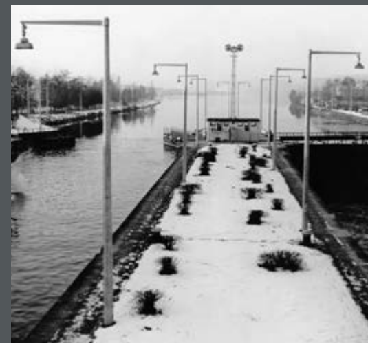
Bild 388: Mittelmauer der Schleuse Richtung Oberwasser, man erkennt die Lichtmaste und das alte Schleuseneinfahrtssignal. (1961)
