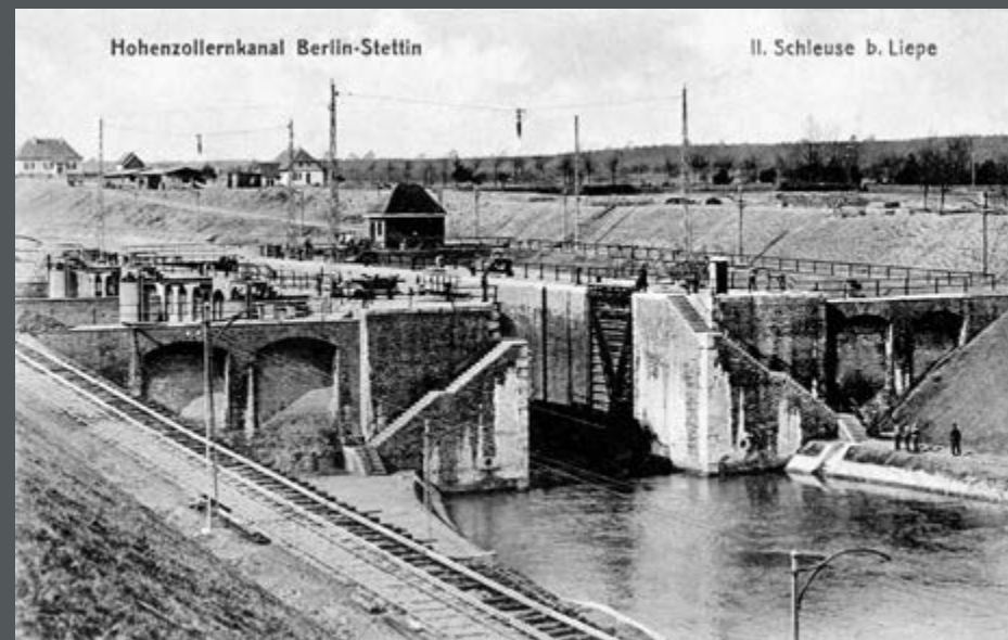
Bild 419: Blick auf die fertige Schleuse II. (1914)
