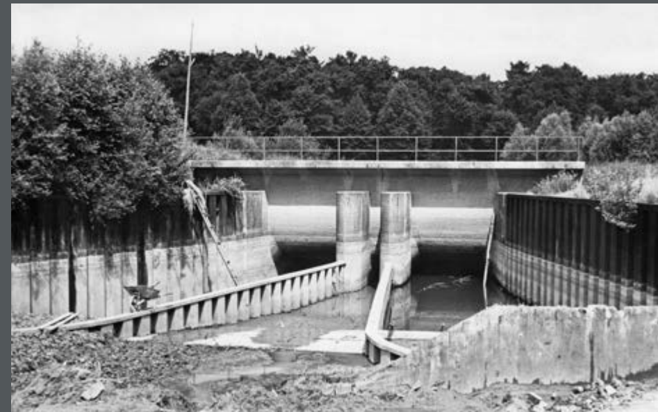
Bild 95: Unterseite des Auslaufs vom neuen Stever-Düker am Dortmund-Ems-Kanal. (1953)
