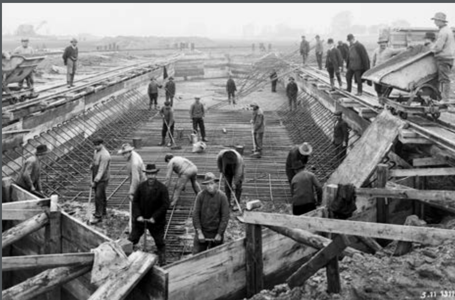
Bild 254: Betonieren des mittleren und breitesten Pfeilers B3 beim Bau der alten Kanalbrücke Minden am Mittellandkanal. Es gibt insgesamt fünf Flutpfeiler. (1911)
