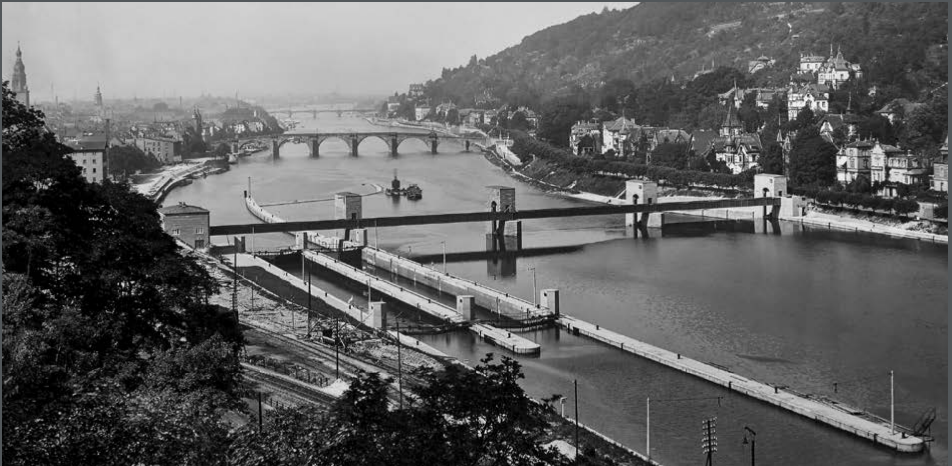
Bild 309: Staustufe Heidelberg vom Oberwasser aus gesehen. (1928)
