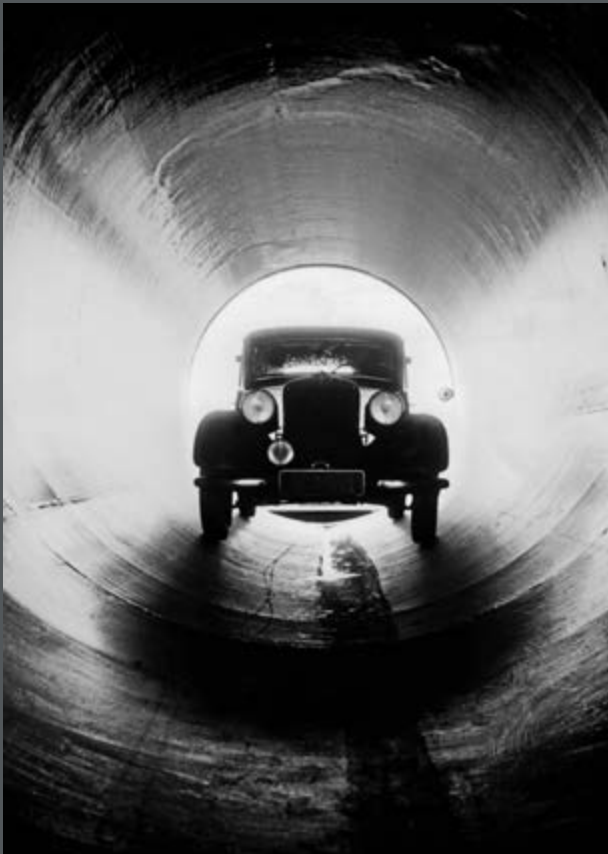
Bild 178: Ein alter Mercedes steht im Dükerrohr des Berne-Dükers am Rhein-Herne-Kanal (siehe Bild 179, rechts). Der Düker hat einen Durchmesser von 2,80 Meter. (1952)
