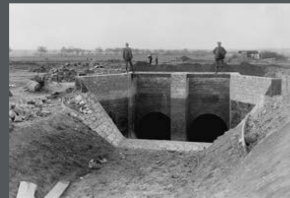
Bild 358: Bau des Holpe-Dükers, etwa 100 Meter westlich der Straßenbrücke bei Lauenhagen. (1914)
