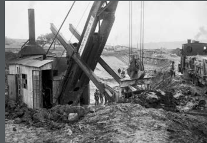
Bild 240: Ein Bagger der Firma Orenstein & Koppel AG beim Aushub an der Staustufe Kachlet an der Donau. (1922)
