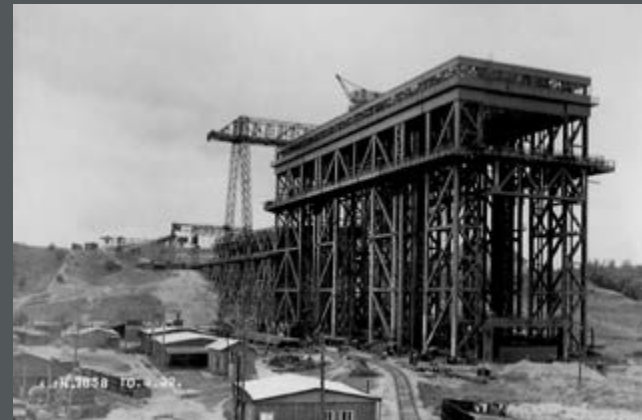
Bild 444: Baustelle vom Lagerplatzkran aus gesehen. (1932)
