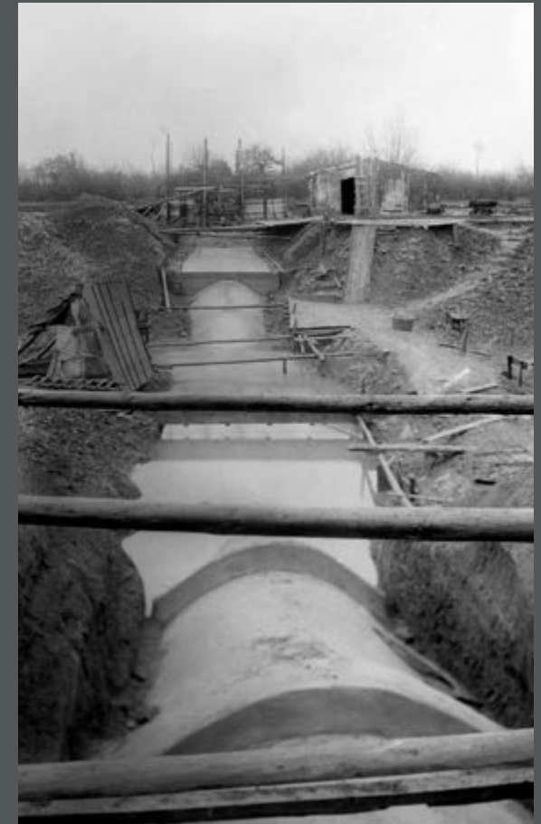
Bild 355: Der Hülshagener Düker Nr. 149, hier das fertiggestellte Dükerrohr. (1913)
