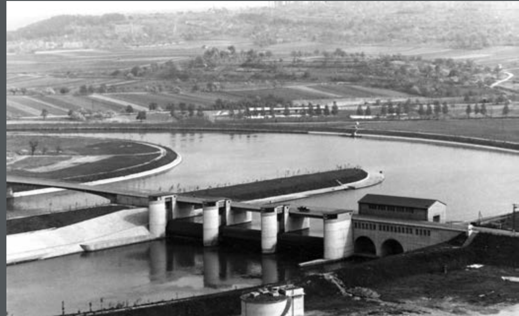
Bild 332: Gesamtansicht der Staustufe Besigheim. (1957)
