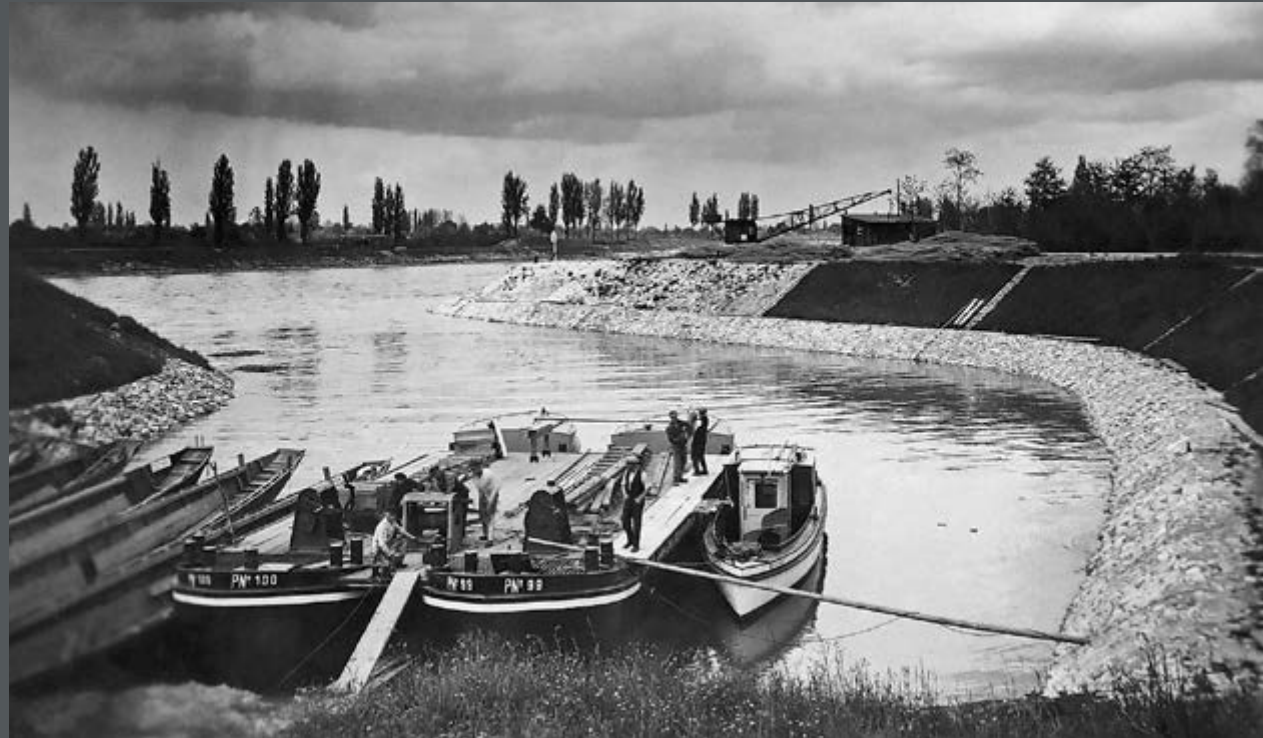
Bild 99: Beim Ausbau des Dortmund-Ems- Kanals wurde bei Amelsbüren eine Überholstrecke am rechten Ufer neu eingerrichtet. (1967)
