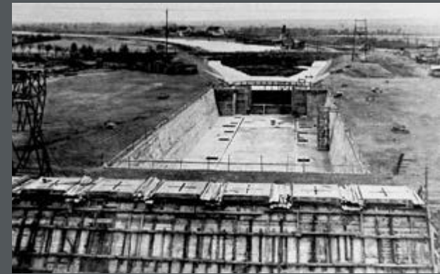
Bild 432: Baugrube im Dezember 1929.
