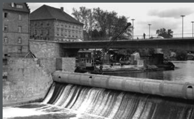
Bild 150: Altes Walzenwehr der Staustufe Schweinfurt am Main, unterströmt. (1963)
