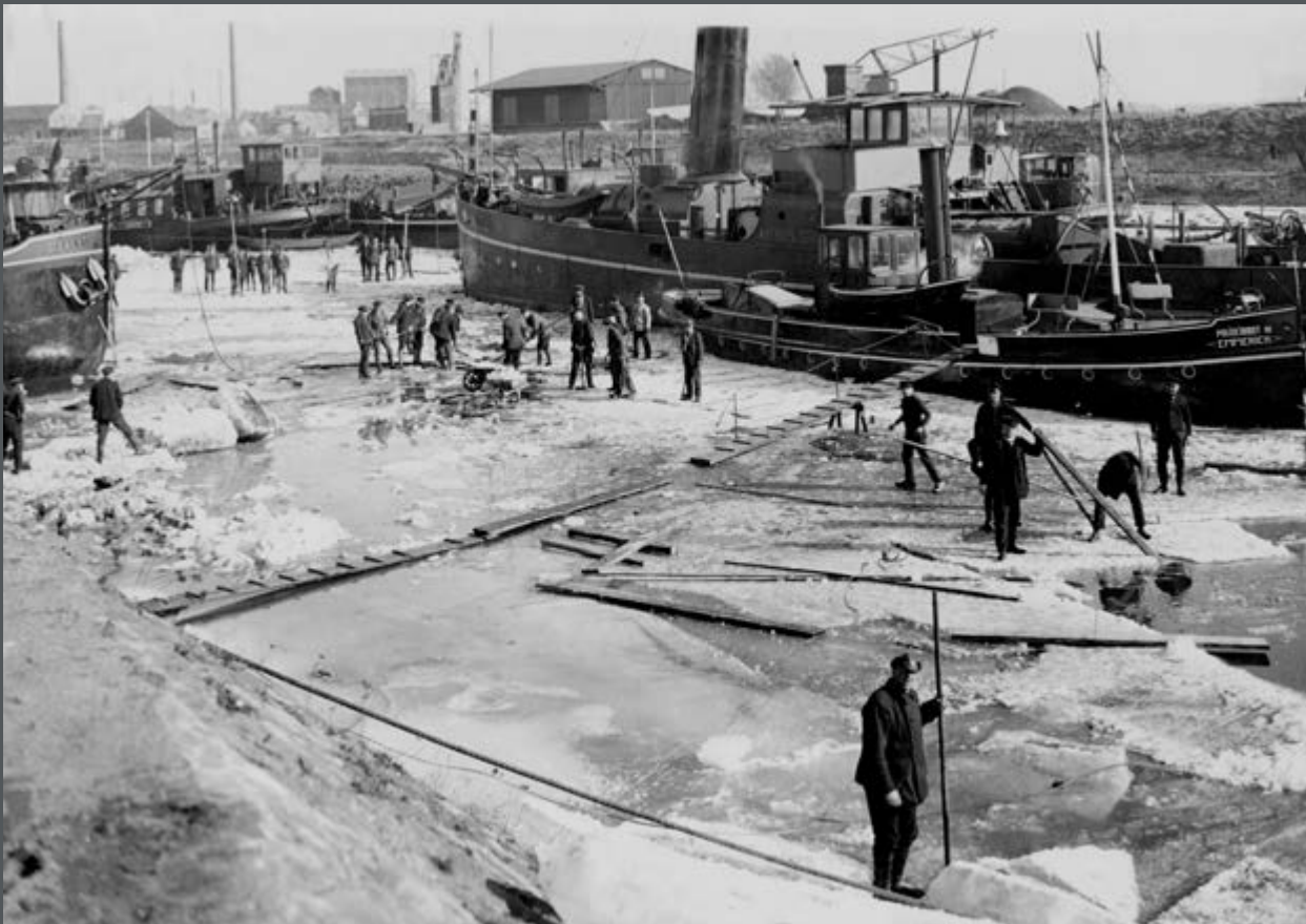
Bild 76: Hochwasser und andere Störfälle (z. B. starke Eisbildung, Einengung des Fahrwegs, Havarien) bedingen häufig, dass der komplette Schiffsverkehr eingestellt werden muss. Das Bild zeigt das Aufbrechen von Eis im Zollhafen von Emmerich am Rhein, als er beim kältesten Winter des 20. Jahrhunderts (Februar 1929) mit dem Rhein und Teilen der Nebenflüsse zugefroren war.
