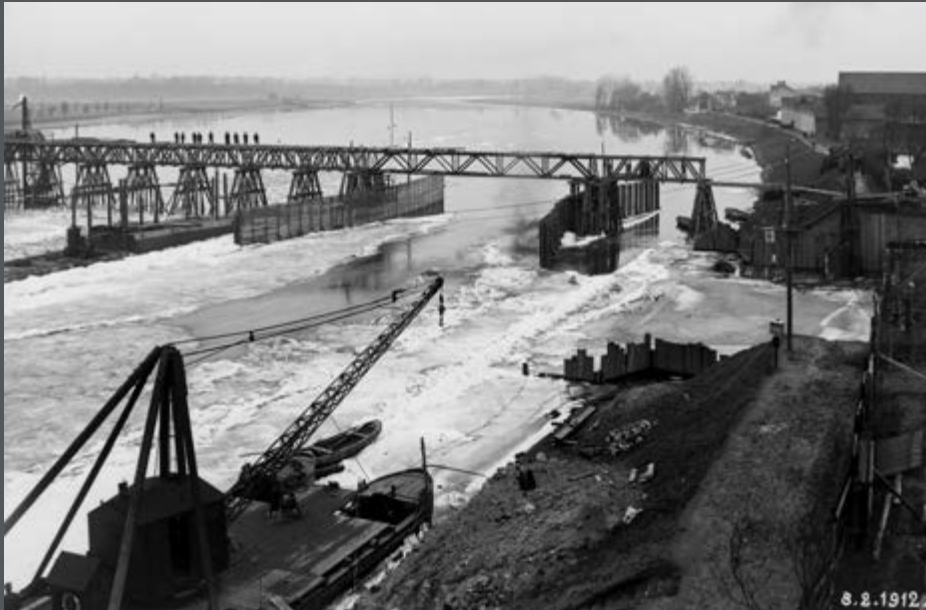
Bild 343: Die Baustelle der alten Kanalbrücke Minden bei Eis. (1912)
