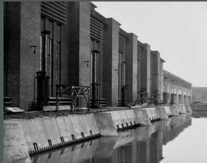
Bild 395: Blick vom linken Ufer, oberwasserseitig, auf das fertige Krafthaus, im Hintergrund das fertige Wehr. (1949)
