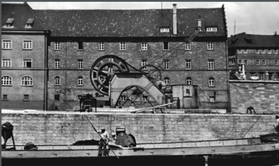
Bild 269: Antrieb des alten Hauptwehres der Staustufe Schweinfurt am Main vom neuen Oberkanal aus gesehen. (1963)
