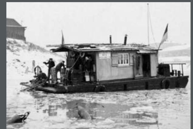
Bild 30: Taucherprahm „Düker“ im Rhein – die Prahm ist ein Schiffstyp ohne eigenen Antrieb. (1950)
