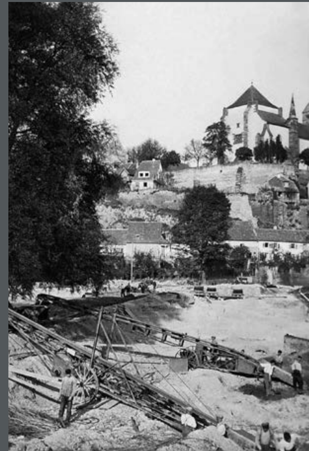
Bild 237: Beim Bau der Liegestelle Breisach am Rhein wird die mit Hand ausgehobene Erde mit Loren und Transportbändern weiter verfrachtet. (1931)
