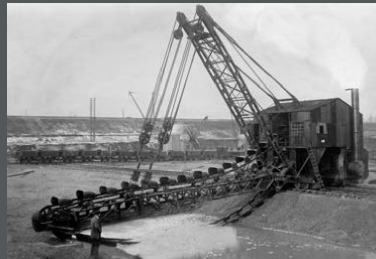
Bild 315: Eine Dampf- ramme auf Ponton rammt Stegdalben im Oberwasser für die Schleuse Feudenheim. (1928)
