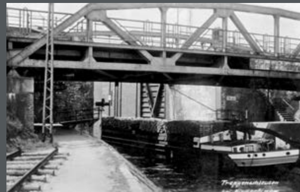
Bild 424: Blick vom unteren Vorhafen auf die letzte Schleuse IV, aus der gerade ein Dampfboot ausfährt. Am rechten Bildrand die Treidelanlage zum Transport der Schiffe. (1914)
