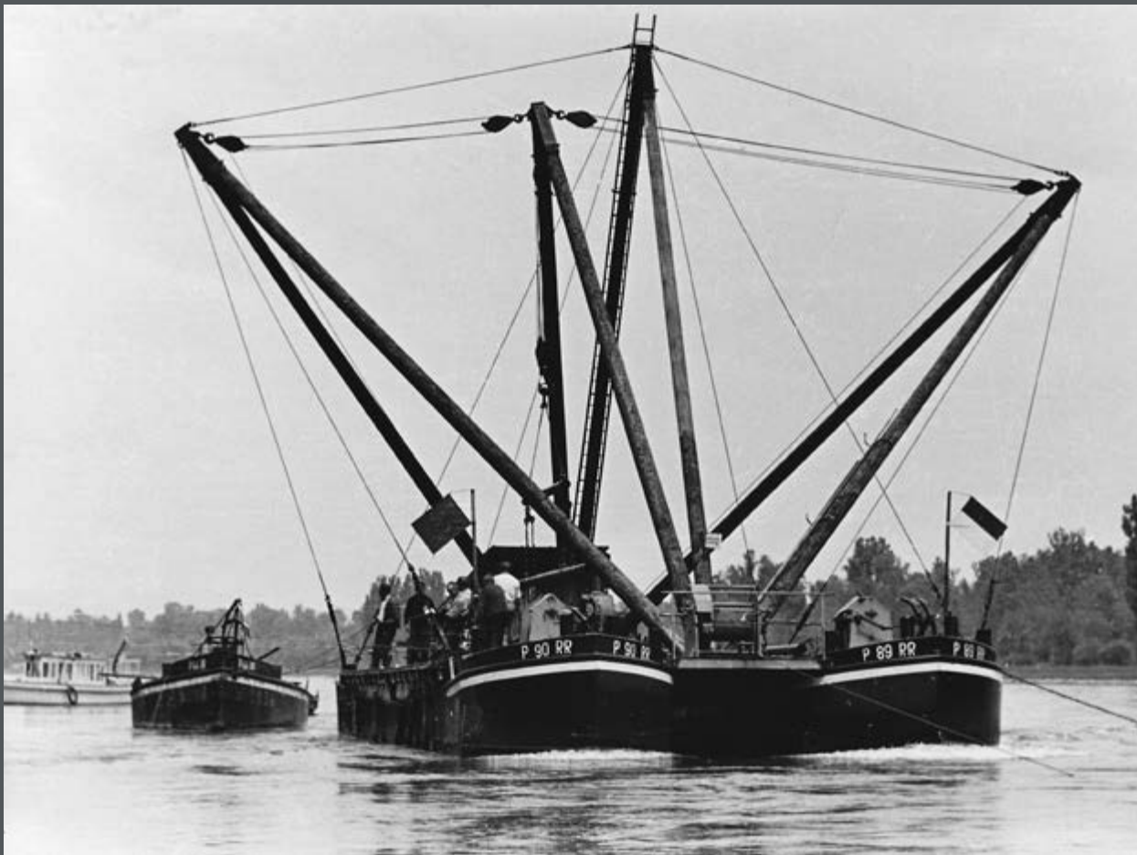
Bild 28: Mechanisierte Senkbrücke auf Ponton im Rhein. Mit dieser Vorrichtung werden z.B. Faschinen auf die Sohle abgesenkt. (1953)
