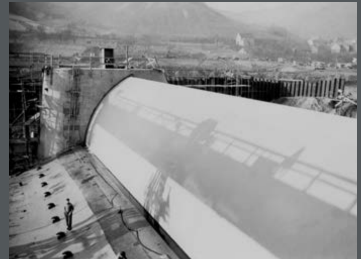
Bild 140: Der erste Wehrverschluss der Wehranlage Detzem an der Mosel vor der Probeflutung, Blick auf die Strahlaufreißer der Wehrschwelle. (1960)
