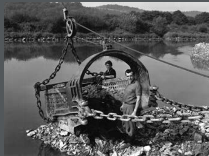
Bild 277: Die Flussstrecke der Oder bei Glogau soll ausgebaut werden. Dazu wird der Faschinenunterbau vom Ufer aus belastet und versenkt. (1937)
