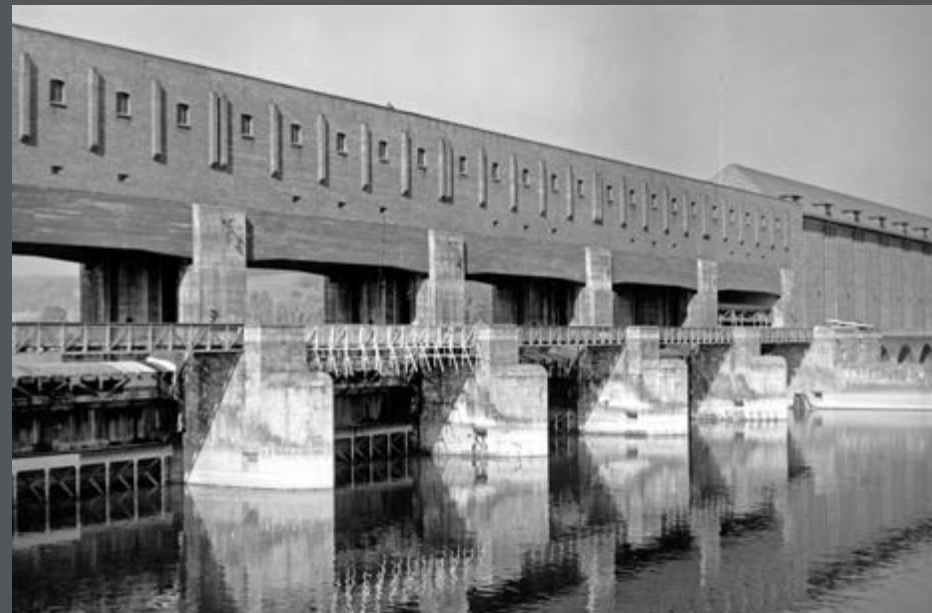
Bild 390: Das Wehr von Unterstrom mit den Schützen. (1962)
