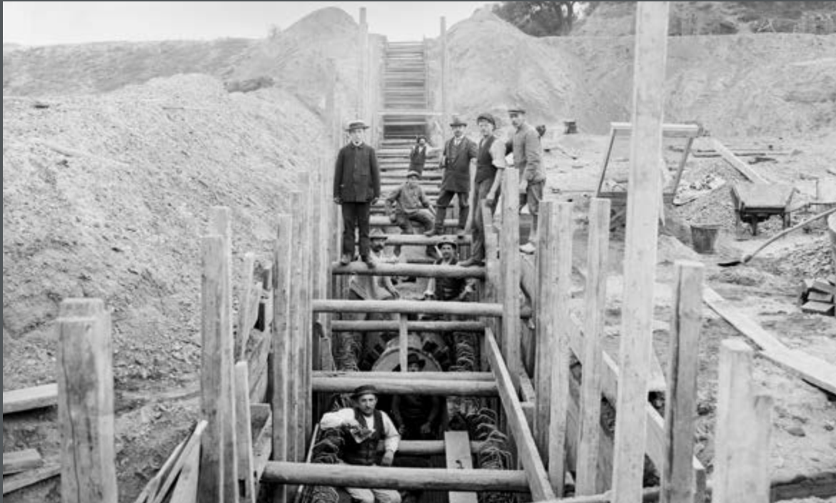
Bild 239: Schalungsarbeiten beim Bau einer Rohrleitung für das Pumpwerk der Schleusenanlage Minden am Mittel- landkanal. (1915)
