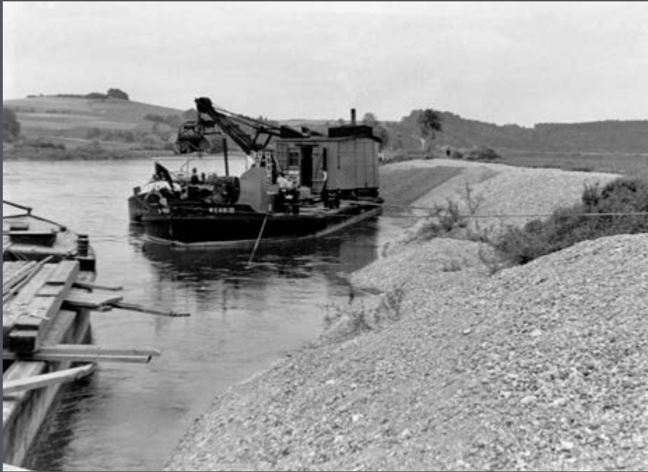
Bild 401: Auf das tiefgehend beschädigte rechte Donauufer bei Kapfelberg wird eine Pflasterung auf die Steinschüttung aufgebracht. (1953)
