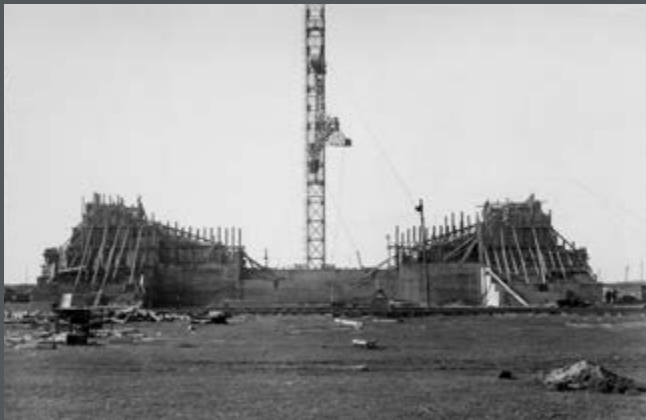
Bild 367: Vorderansicht des Kanalbrücken-Widerlagers, Kanalbrücke über die Elbe bei Hohenwarthe. (1930)
