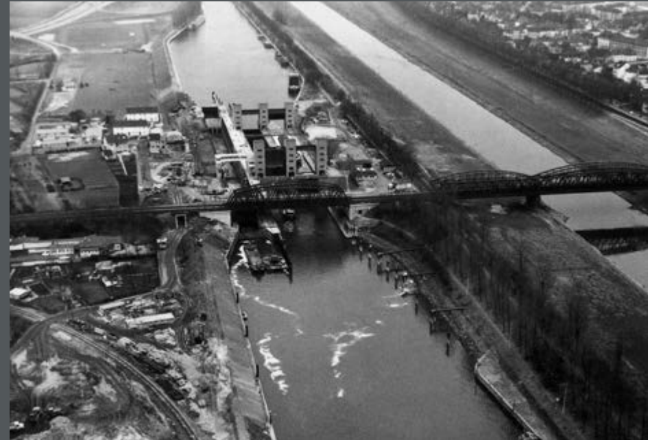
Bild 311: Baustelle der Ersatzschleuse Feudenheim, rechts der Wehram Ladenburg. (1971)
