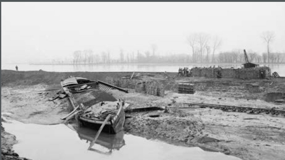
Bild 345: Erdarbeiten in der Ausmündung des Unteren Vorhafens der Schleuse. Der durch Hochwasser gesunkene Kahn ist zerstört. (1913)
