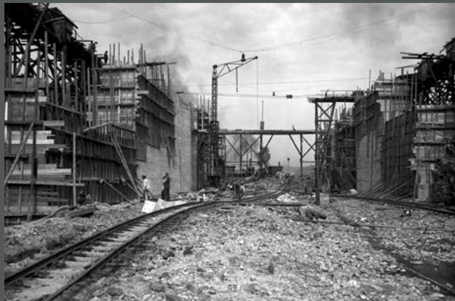
Bild 385: Blick auf die Arbeiten in der Südschleuse. (1924)
