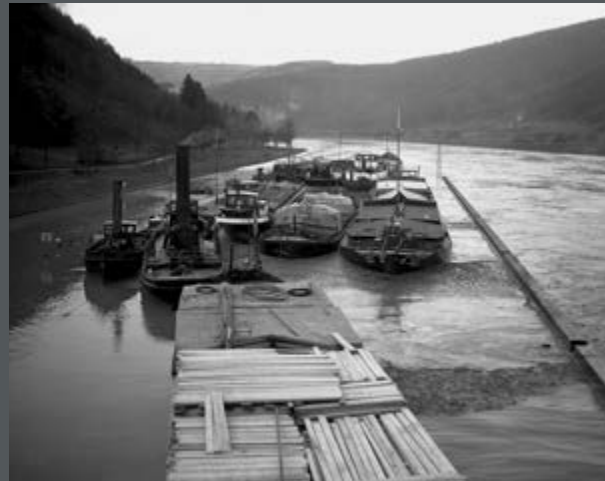
Bild 41: Schiffe im unteren Vorhafen der Schleuse Rockenau am Neckar bei Hochwasser. (1937)
