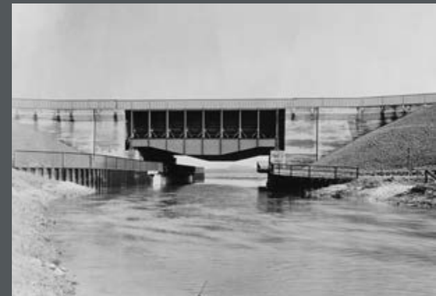
Bild 194: Der Dortmund-Ems-Kanal wird bei Olfen in einer Kanalbrücke über die Stever geführt. (1949)
