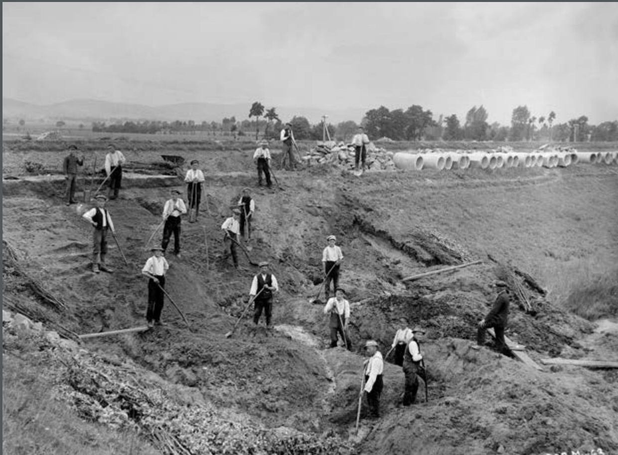
Bild 233: Beim Erdbau hat sich die Arbeitsweise innerhalb eines Jahrhunderts extrem verändert: Die damals übliche körperliche Arbeit mit Hacke und Schaufel wird heute längst von Maschinen durchgeführt. Das Bild zeigt die Sanierung einer Rutschung an der Innenböschung des Mittellandkanals bei Hahnen. (1915)
