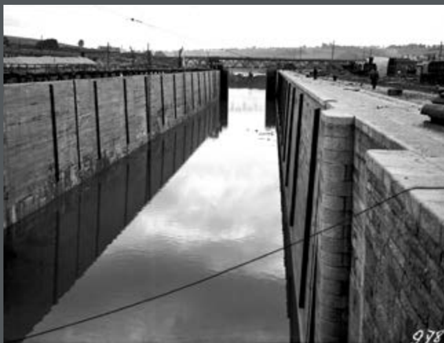
Bild 387: Blick flussabwärts auf die fertige Südschleuse, die Stemmtore sind eingesetzt. (1925)
