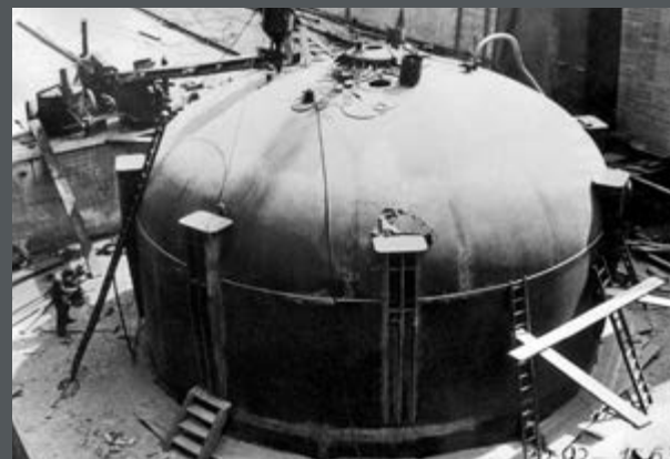
Bild 163: Arbeiten am Schwimmer (L=35 m, Ø 10 m) des Hebewerks Rothensee sind beendet, Aufnahmekonsolen für das Stützgerüst sind gut zu erkennen. (1937)
