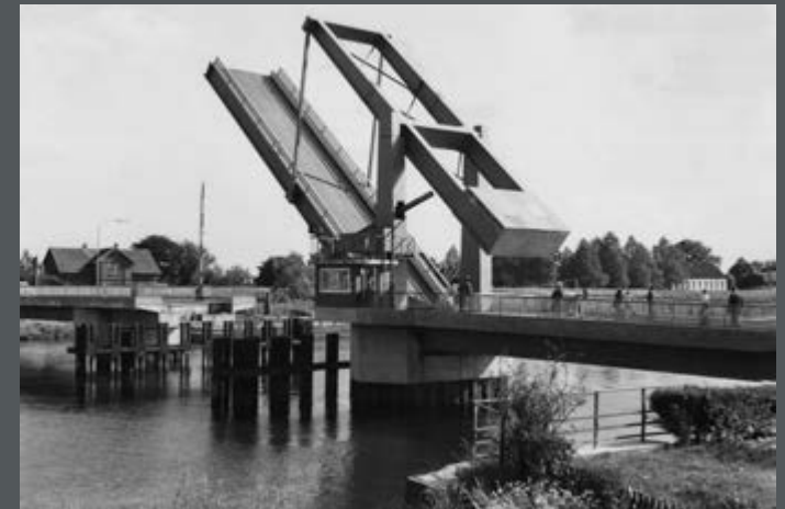
Bild 167: Die neue Klapp-Hubbrücke über die Stör bei Heiligenstedten wird geöffnet, die alte Brücke fiel einer Kollision zum Opfer. (1967)
