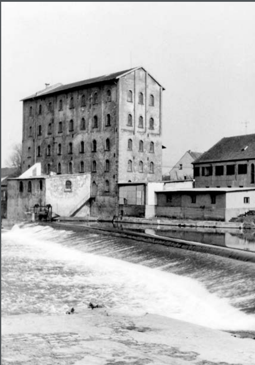
Bild 147: Blick von Unterwasser auf das untere feste Streichwehr der Saarstufe Kleinblittersdorf. (1962)
