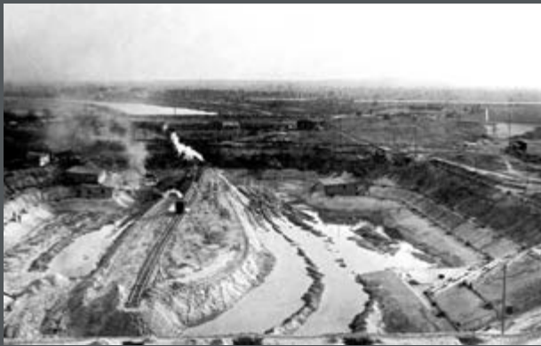
Bild 430: Ausheben der Baugrube 1925 bis 1926.
