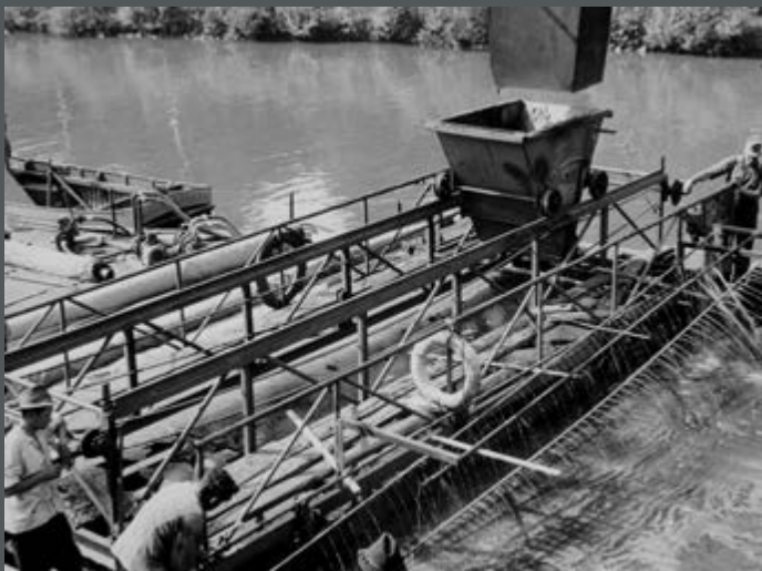
Bild 276: In einer Versuchsstrecke am Dortmund-Ems-Kanal werden Stahlbetonplatten als Böschungsschutz eingebaut. (1954)
