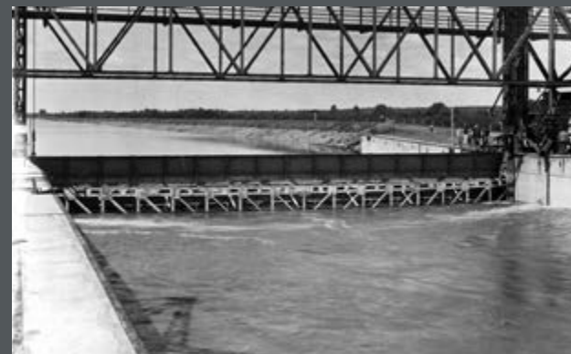
Bild 453: Blick auf den fertigen Dambalkennotverschluss im Unterwasser für die später dahinter liegende Trogkammer. Im Hintergrund der Abschluss der Kanalbrücke zum Schiffshebewerk (man erkennt den Geländesprung). Das Schiffshebewerk ist noch nicht vorhanden. (1929)
