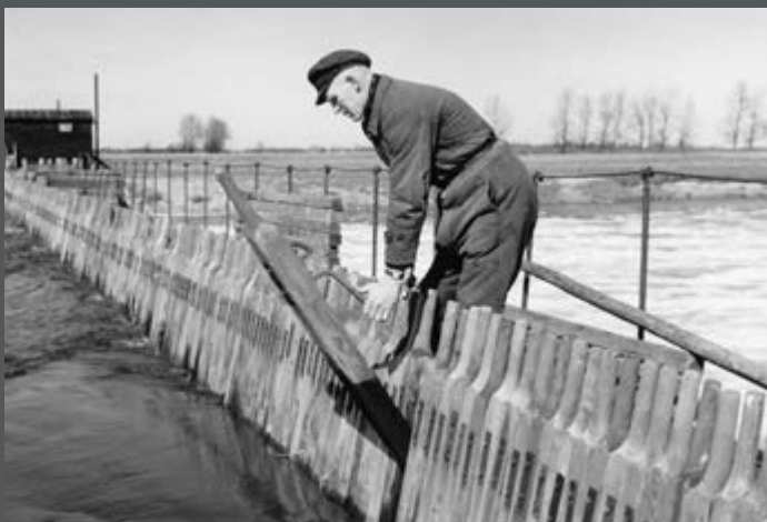
Bild 144: Bei Nadelwehren lassen sich die Wasserstände durch Ziehen einzelner Nadeln regulieren. Das Bild zeigt das alte Nadelwehr Bollingerfähr am Dortmund-Ems-Kanal. (1940)
