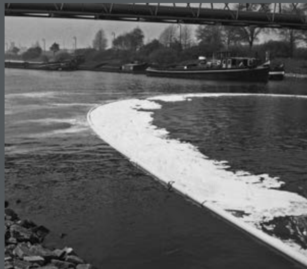
Bild 88: „Oilstop“ – Schlingelanlage im Oberwasser der Schleuse Gelsenkirchen (Rhein-Herne-Kanal). Zusammenziehen der Schaumdecke. (1963)
