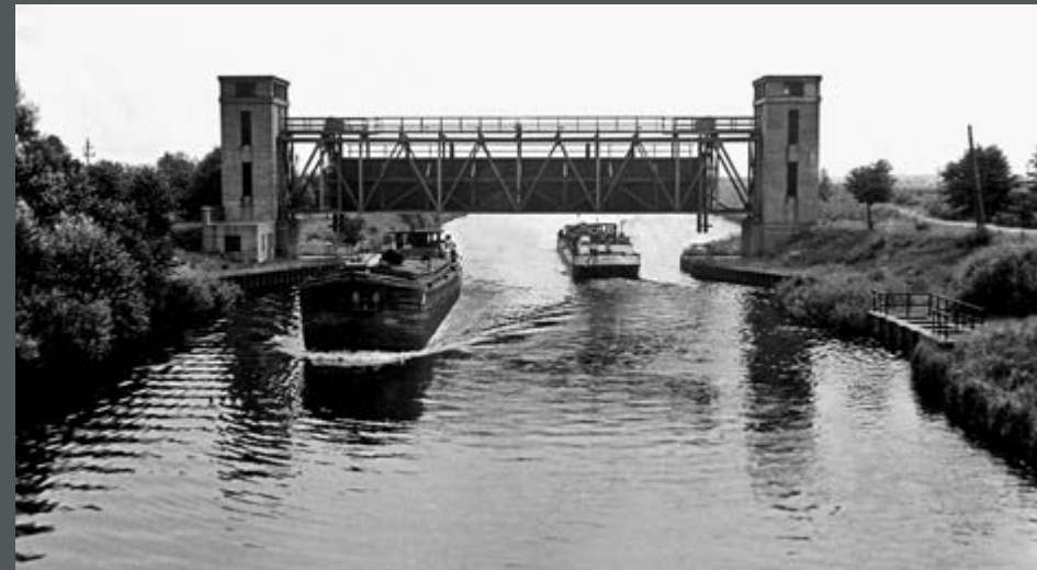
Bild 211: Blick von Osten auf die Sicherheitstoranlage Sedelsberg von 1934 am Küstenkanal gegen Hochwasser. (1952)
