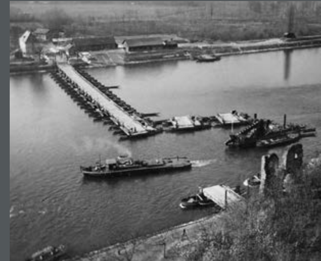
Bild 86: An der Pontonbrücke über den Rhein bei Marckolsheim von 1873 (zerstört 1944 durch Krieg) werden einzelne Pontons zur Durchfahrt für die Schiffe entfernt. (1933)
