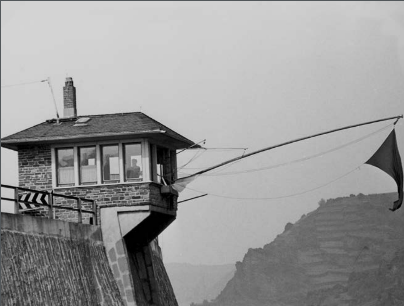
Bild 51: Wasserstraßen sind Verkehrswege und benötigen wie alle Verkehrsarten allgemeingültige Regelungen für einen geordneten risikofreien Schiffsverkehr. Geregelt wurde früher mit Wahrschaustationen (Lotsen von Schiffen mit Hilfe von Licht- oder Flaggsignalen bis 1972), später mit Radaranlagen. Blick auf die Wahrschaustation mit Flaggen bei Betteck am Rhein. (1969)
