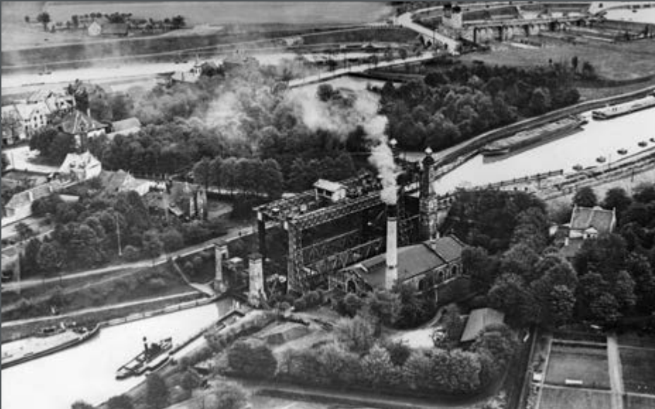
Bild 154: Das alte Schiffshebewerk Henrichsburg von Südwest aus gesehen – Abstiegsbauwerk 1 zum Dortmund-Ems-Kanal. Im Hintergrund (oben rechts) die alte Schachtschleuse – Abstiegsbauwerk 2 des Dortmund-Ems-Kanals. (1945)
