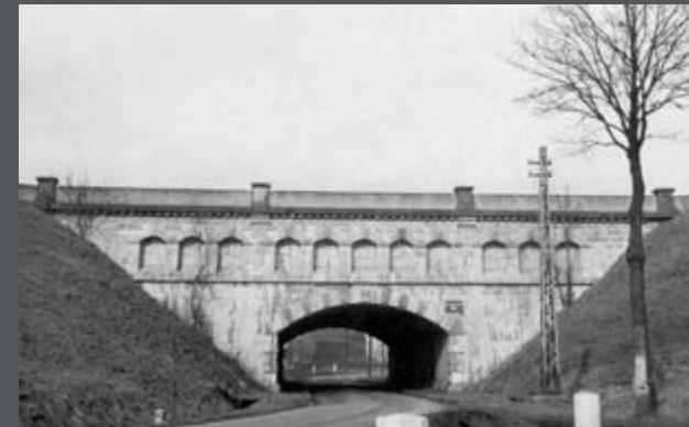
Bild 193: Überführung des Dortmund-Ems-Kanals über die Landstraße bei Olfen-Lüdinghausen, „Alte Fahrt“ Olfen. (1950)
