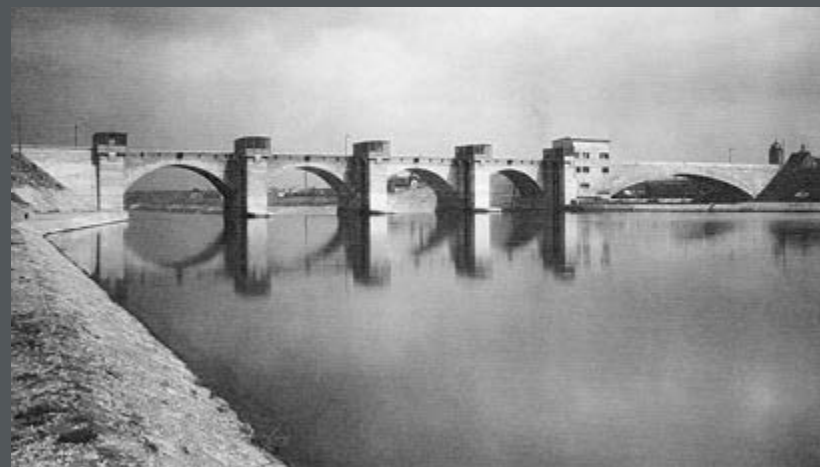
Bild 171: Die Wehrbrücke des Wehrs Neckarsulm am Neckar von Oberwasser. Rechts die Brücke über den Neckarkanal, dazwischen das Dienstgebäude. (1930)
