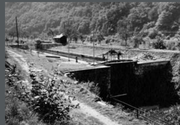
Bild 129: Schleuse Kalkofen an der Lahn von 1882 mit zwei Stemmtoren. (1951)
