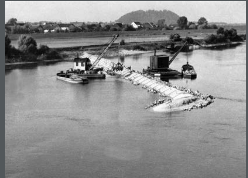
Bild 400: Der Stau durch die Stufe Kachlet reicht bis zu einer Länge von 25 km, die verbleibenden ca. 160 km Bundeswasserstraße bis Kelheim sind aber bei Niedrigwasser kaum befahrbar. So wurden seit 1938 Niedrigwasserregulierungen zwischen Regensburg und Vilshofen durchgeführt, außerdem in den 50er-Jahren wieder. So wurde beispielsweise das Mittelwasserleitwerk oberhalb der Deggendorfer Brücke in dieser Zeit wiederhergestellt. (1952)
