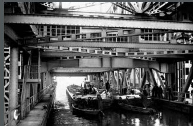
Bild 446: Blick in den Trog beim Ausfahren der Schiffe. (1934)
