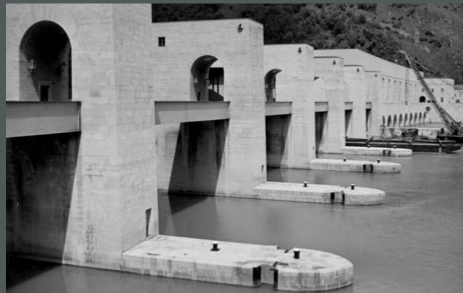
Bild 415: Blick von Unterwasser auf das Wehr und das Laufwasserkraftwerk. Die Ländergrenze verläuft durch das Wehr. (1961)
