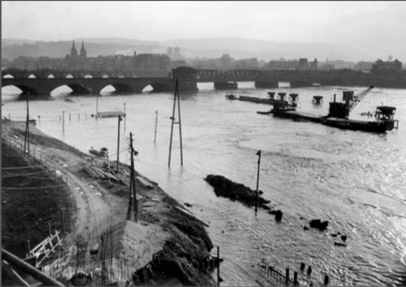
Bild 69: Die Baustelleneinrichtung mit Geräten zum Wiederaufbau der Neuen Moselbrücke wurde beim Hochwasser 1952 in Koblenz an der Mosel überschwemmt.
