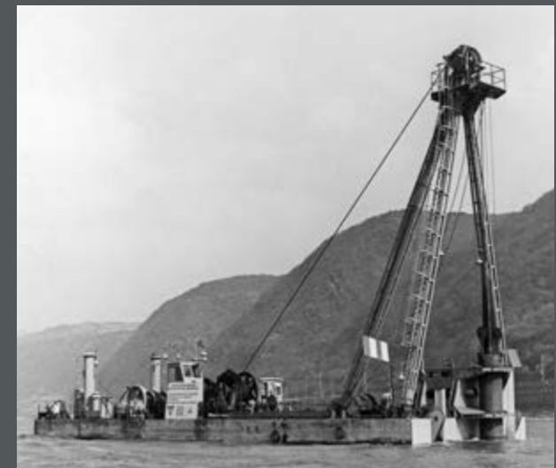
Bild 89: Freifallmeißel bei Felsbeseitigungsarbeiten im Rhein bei Oberwesel. (1960)
