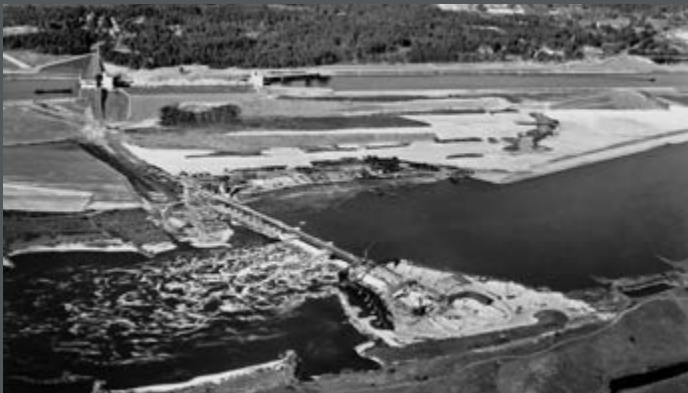
Bild 118: Luftbild der Staustufe Geesthacht mit Wehr in der Elbe (Wehrram) und Seitenkanal mit Schleuse. (1959)
