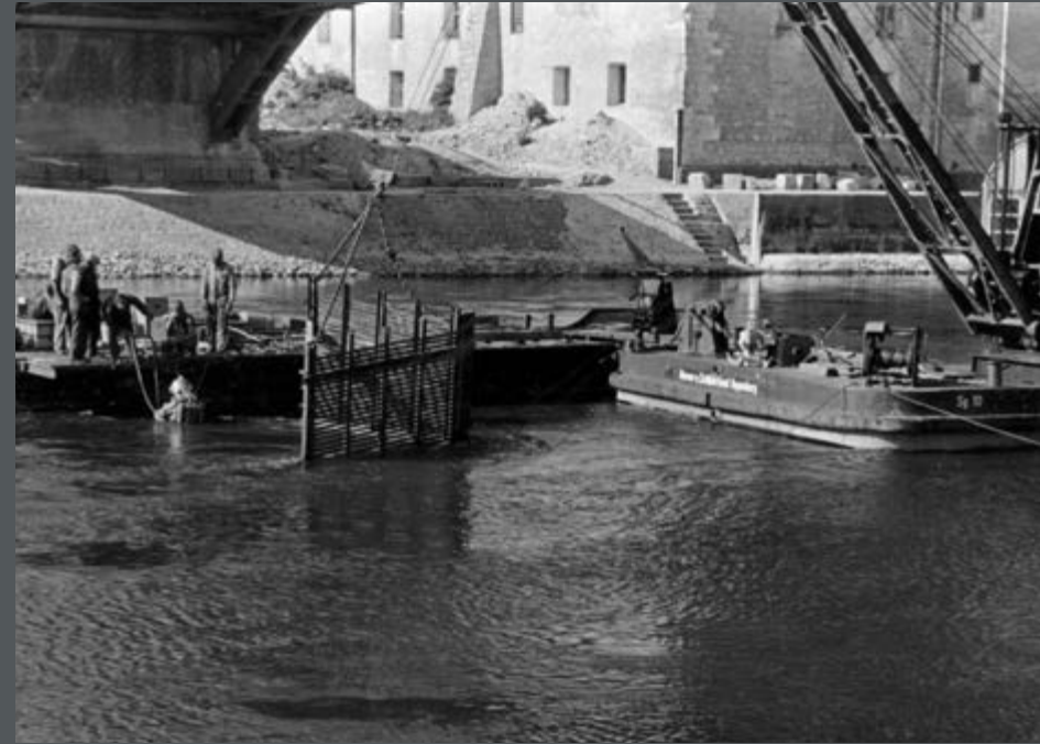
Bild 402: Räumung von gesprengten Brückentrümmern unter Verwendung eines Tauchschildes unter der inneren Straubinger Straßenbrücke. (1950)
