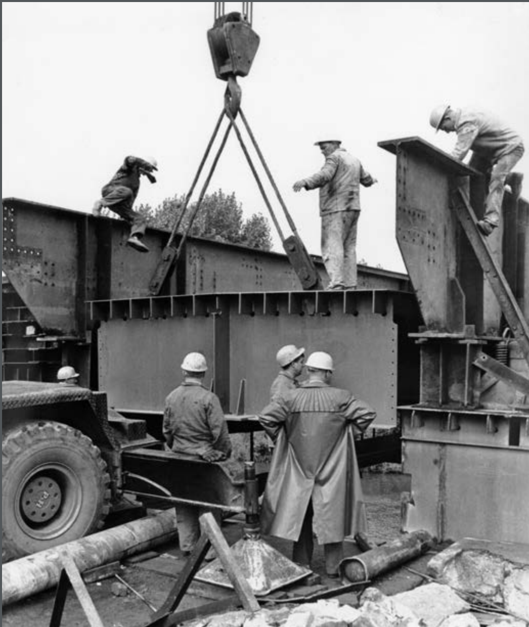
Bild 271: Das Mittelstück der Brücke Nr. 484 am Datteln-Hamm-Kanal wird eingesetzt. (1966)
