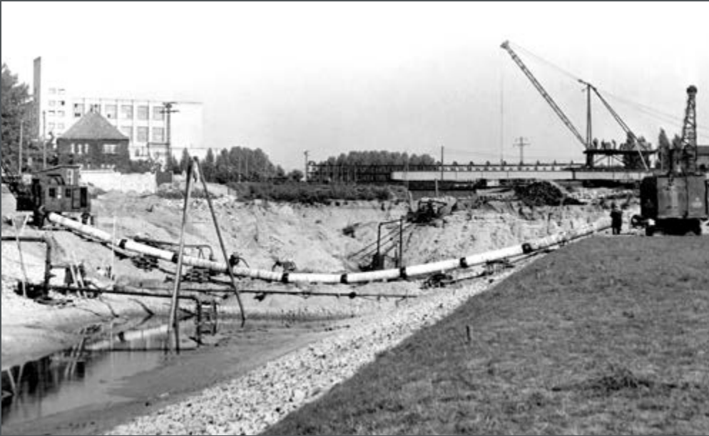
Bild 180: Verlegung des Dükers Greven an der Ems für die Binnenentwässerung. (1953)
