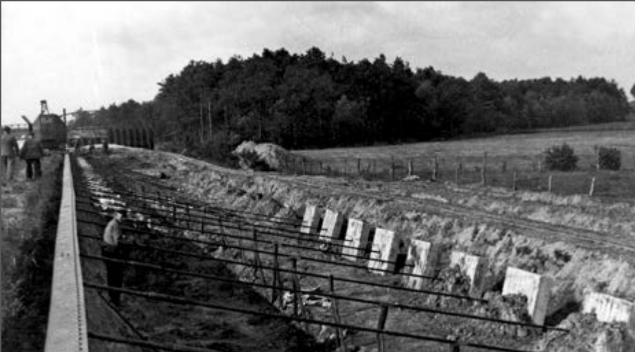
Bild 92: Rückverankerung einer Spundwand mittels Betonteil „toter Mann“ am Dortmund-Ems-Kanal. (1936)
