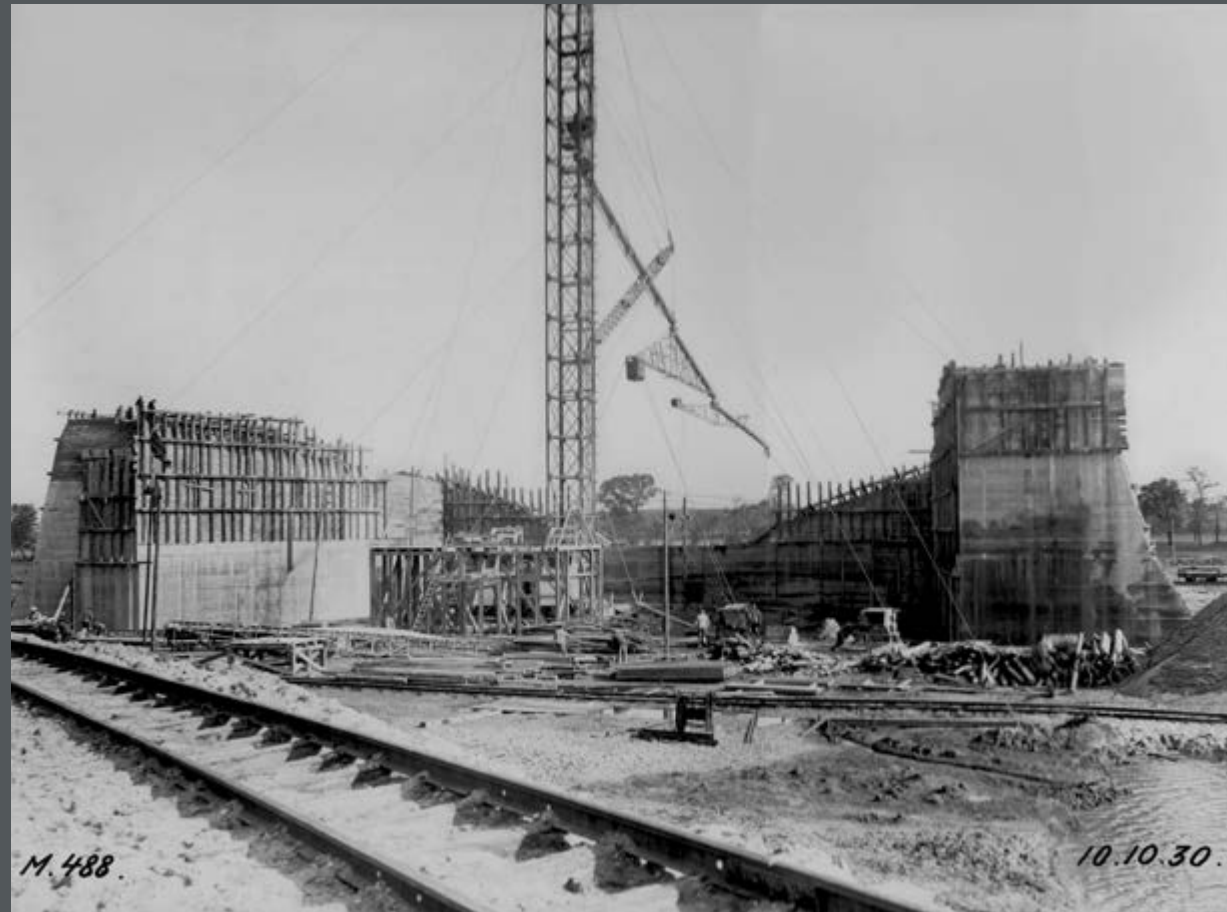
Bild 369: Der Mittellandkanal wird in einer Kanalbrücke bei Hohenwarthe über die Elbe geführt. Hier die Rückansicht des Bauwerks beim Abbruch der Vormischanlage. (1930)
