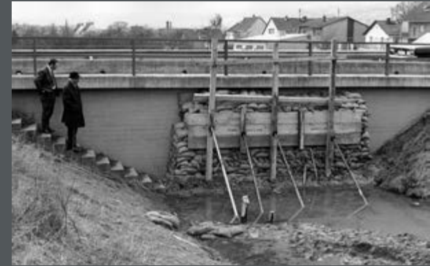
Bild 187: Durchlässe und Fußgängerunterführungen werden mit Sandsäcken gegen Druckwasser vom Rhein abgedichtet. (1970)
