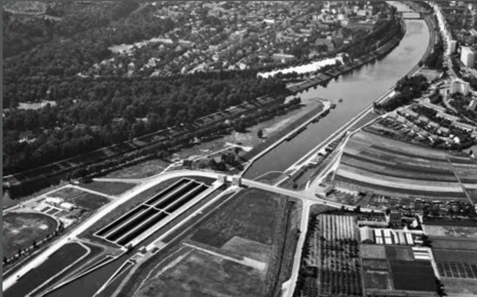
Bild 132: Schleusenanlage Bamberg mit 3 Sparbecken. In der Bildmitte trennt sich der Main-Donau-Kanal von der Regnitz ab. (1968)
