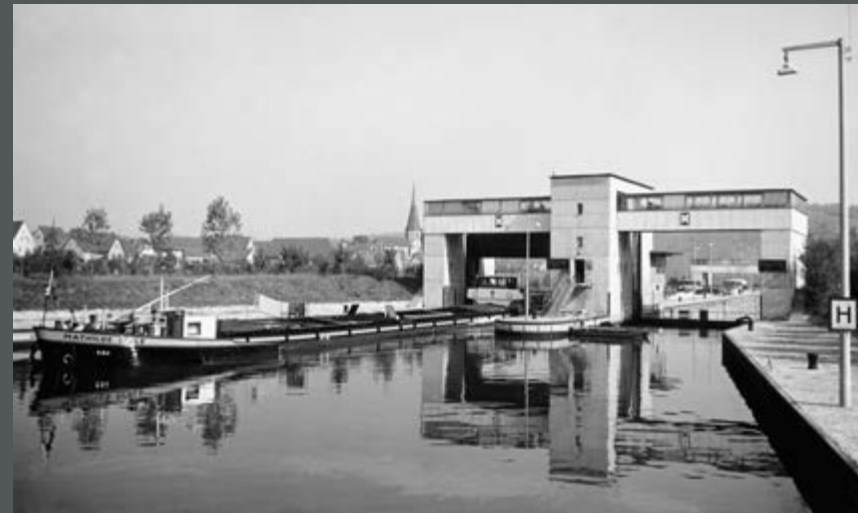
Bild 334: Doppelschleuse Besigheim von Oberstrom. (1961)
