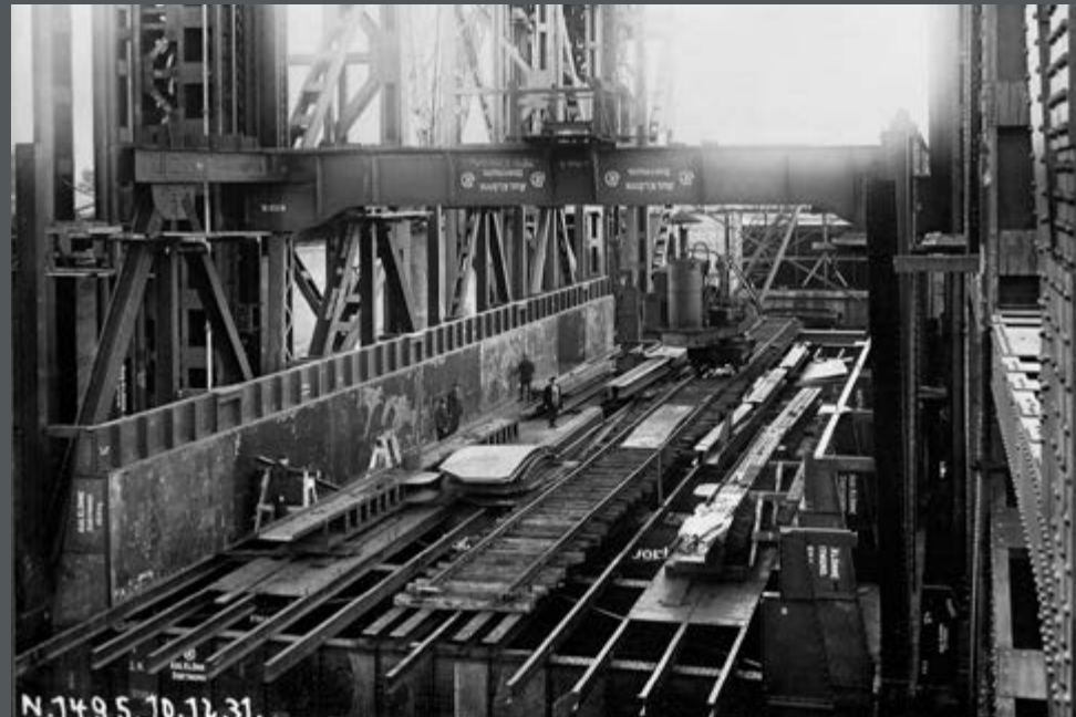
Bild 441: Trogtteil im Bau. (1931)
