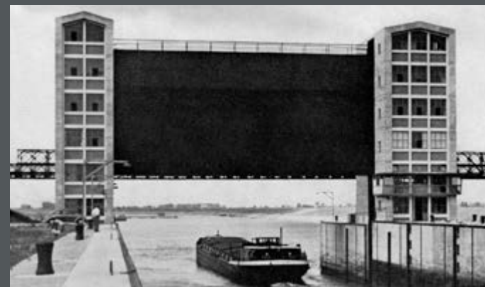
Bild 135: Hubtor der Doppelschleuse Geesthacht an der Elbe. (1960)
