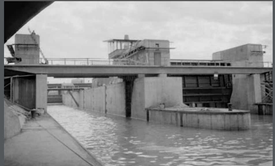
Bild 338: Unterer Vorhafen und Doppelkammerschleuse Bad Cannstatt. (1958)
