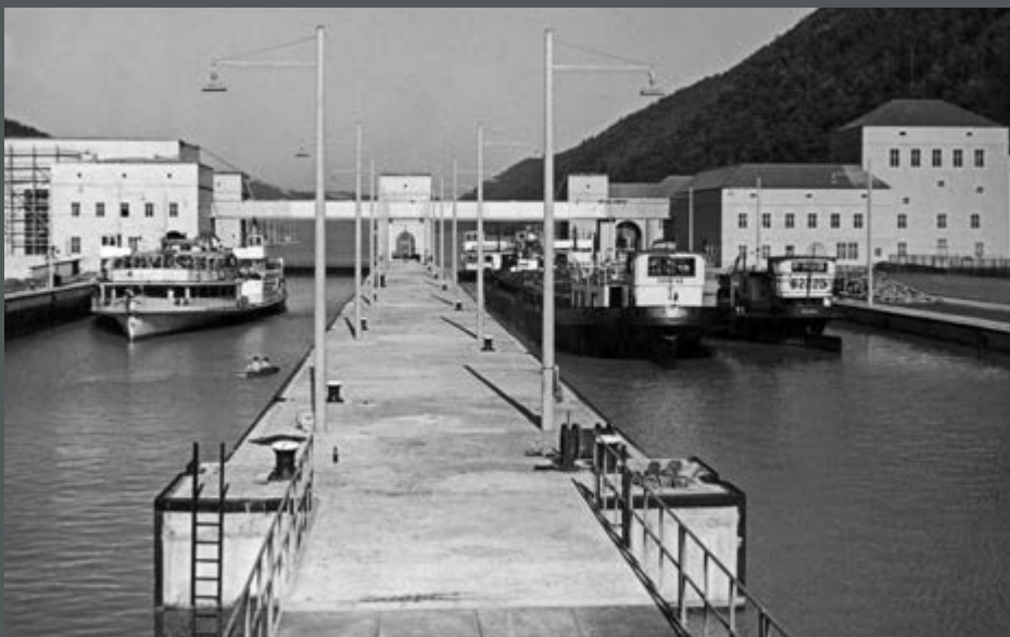
Bild 414: Blick von Unterwasser auf die Doppelkammerschleuse auf dem rechten, deutschen Ufer der Donau. (1956)
