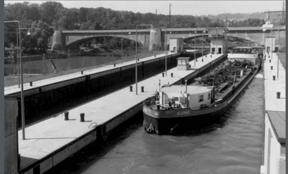
Bild 336: Schleusung eines Tankschiffes in der rechten Schleusenkammer der Doppelkammerschleuse Bad Cannstatt. (1958)
