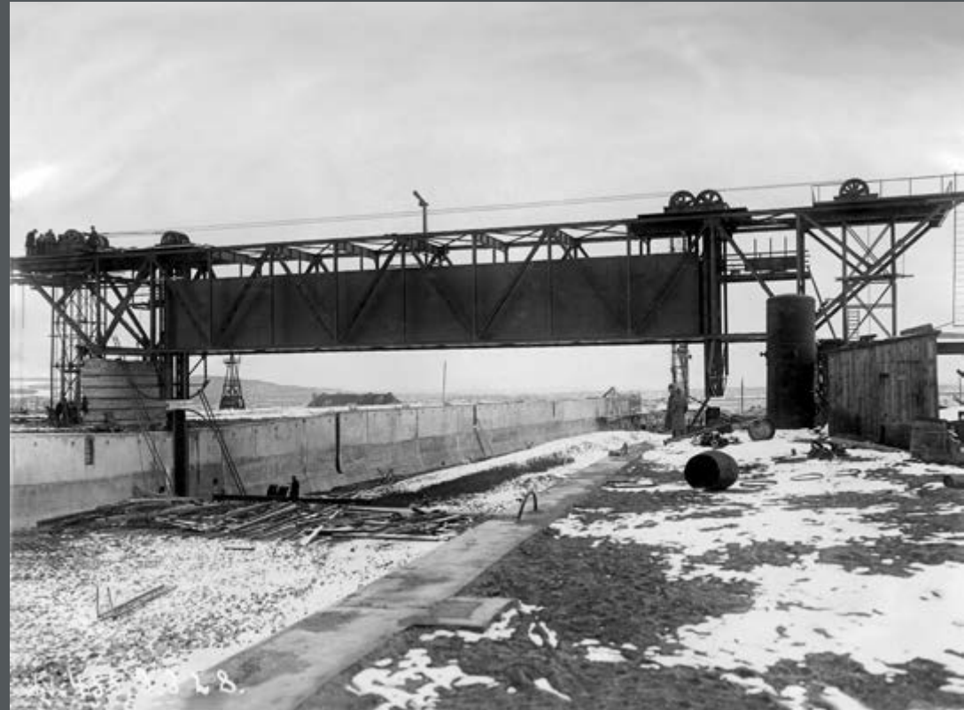
Bild 452: Das Sicherheitstor im angehobenen Zustand. (1928)
