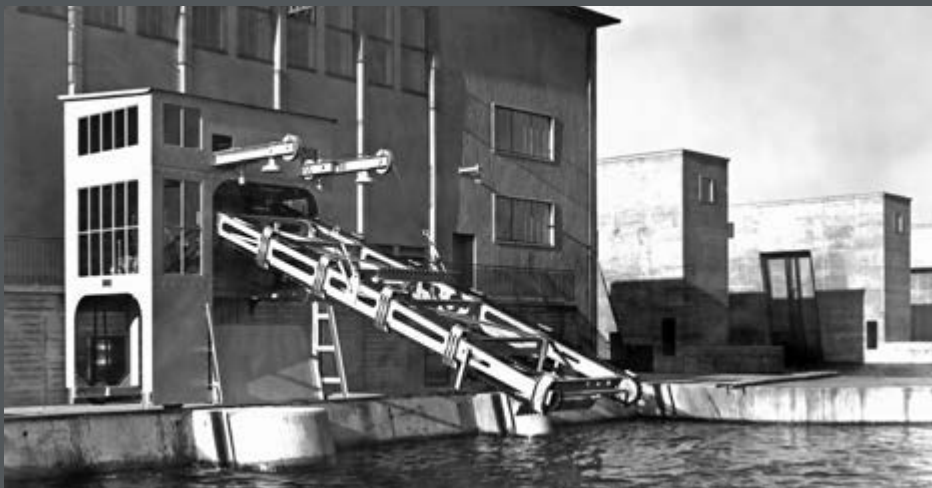
Bild 220: Kraftwerke sind schiffahrtsbezogen eigentlich Nebenbauwerke. Eine Rechenreinigungsmaschine am Kraftwerkseinlauf der Staustufe Limbach am Main. (1951)
