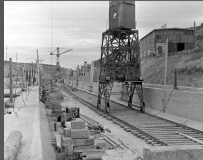
Bild 247: Fahrbare Turmdrehkräne beim Bau der Schleuse Goß- mannsdorf am Main. (1949)
