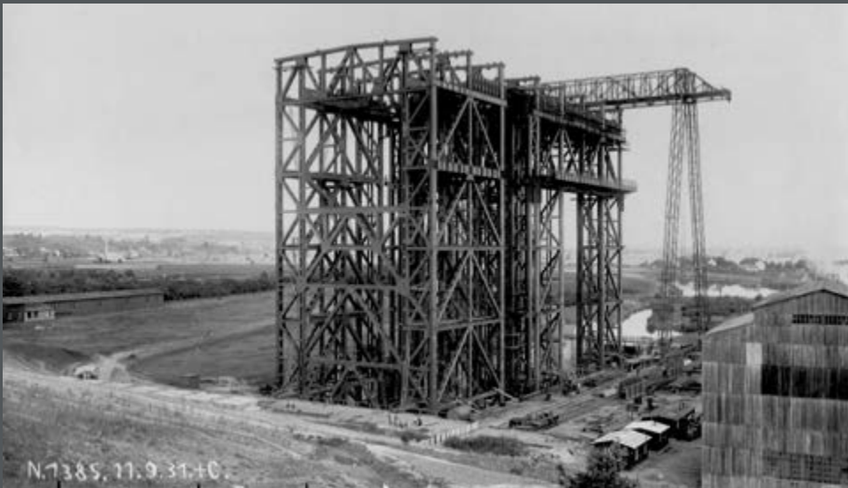
Bild 437: Blick auf die Baustelle des Schiffshebewerks. (1931)
