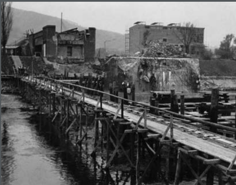
Bild 168: Behelfsbrücke in Holzkonstruktion mit Feldbahngleis für die kriegszerstörte Daimler-Brücke in Untertürkheim am Neckar. (1945)
