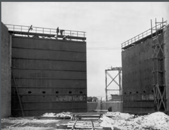
Bild 386: Blick von der Schleusenammer auf das fertig eingesetzte Obertor in der Südschleuse. (1924)
