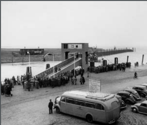
Bild 48: Neubau des Fähranlegers Glückstadt - Wischhafen an der Elbe. (1965)
