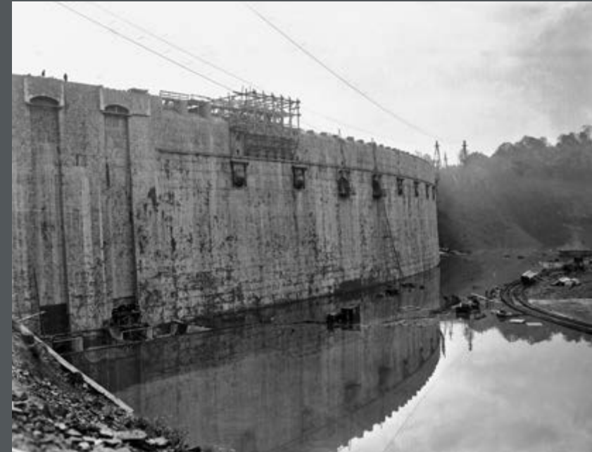
Bild 108: Wasserseite der Sperrmauer vom linken Hang aus gesehen. Die Arbeiten auf der Flusssohle ruhen wegen Überschwemmung. (1913)
