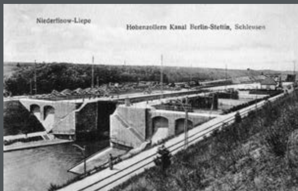
Bild 420: Die Schleuse III der Schleusentreppe Niederfinow. (1919)
