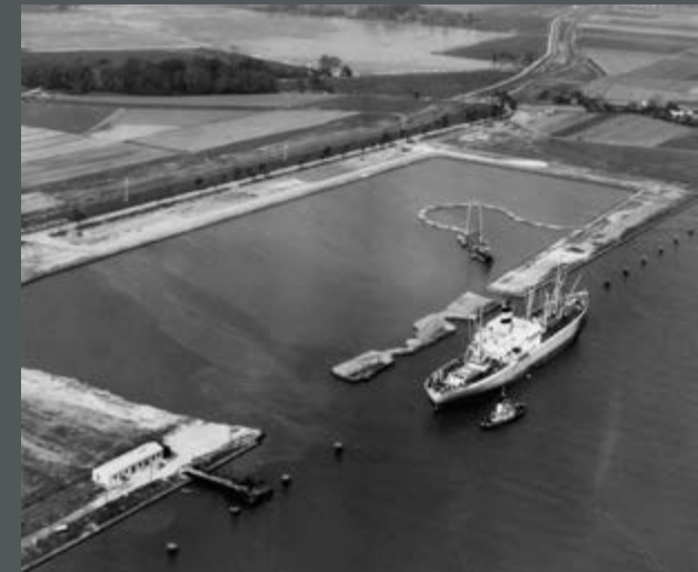
Bild 50: Im östlichen Teil des Ölhafens am Nordufer des Nord-Ostsee-Kanals ist eine Ölsperre angelegt. (1962)
