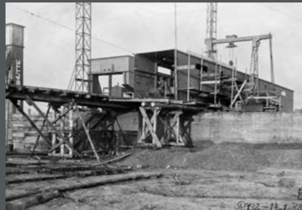
Bild 370: Die Spindel im Schiffshebewerk Rothensee wurde mit Hilfe eines Seilzuges in die Spindelmutter eingedreht. (1938)
