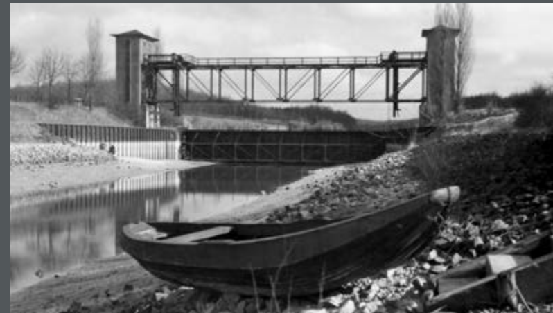
Bild 205: Sicherheitstor Schlieker in der „Neuen Fahrt“ Olfen von 1937 am Dortmund-Ems-Kanal, das Tor ist geschlossen, der Wasserspiegel abgelassen. (1954)
