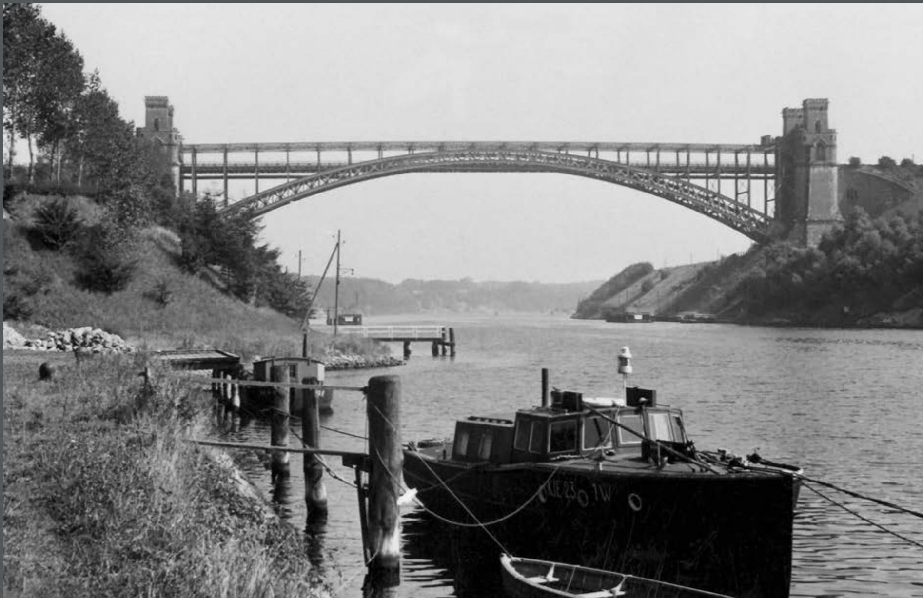
Bild 177: Hochbrücke Levensau (Straßen- und Eisenbahnbrücke von 1894) am Nord-Ostsee-Kanal vor dem Umbau 1954. (1951)
