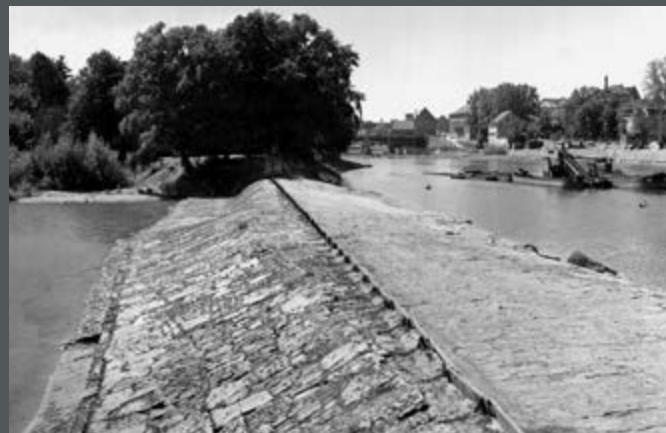
Bild 148: Festes Streichwehr mit umlegbarem Aufsatz beim Umbau der Staustufe Schweinfurt am Main. Der Stauraum rechts ist abgesenkt. (1949)
