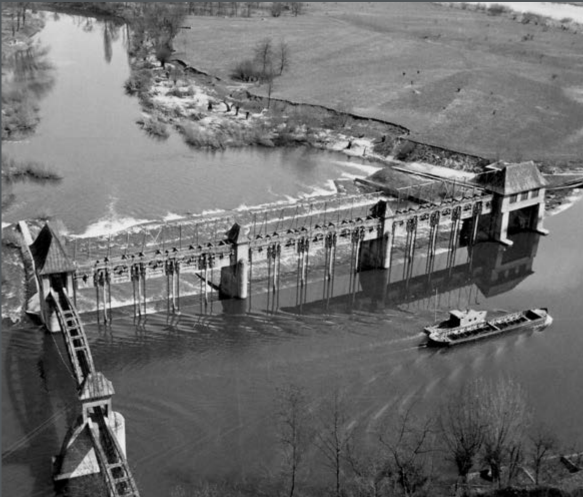
Bild 140: Der erste Wehrverschluss der Wehranlage Detzem an der Mosel vor der Probeflutung, Blick auf die Strahlaufreißer der Wehrschwelle. (1960)
