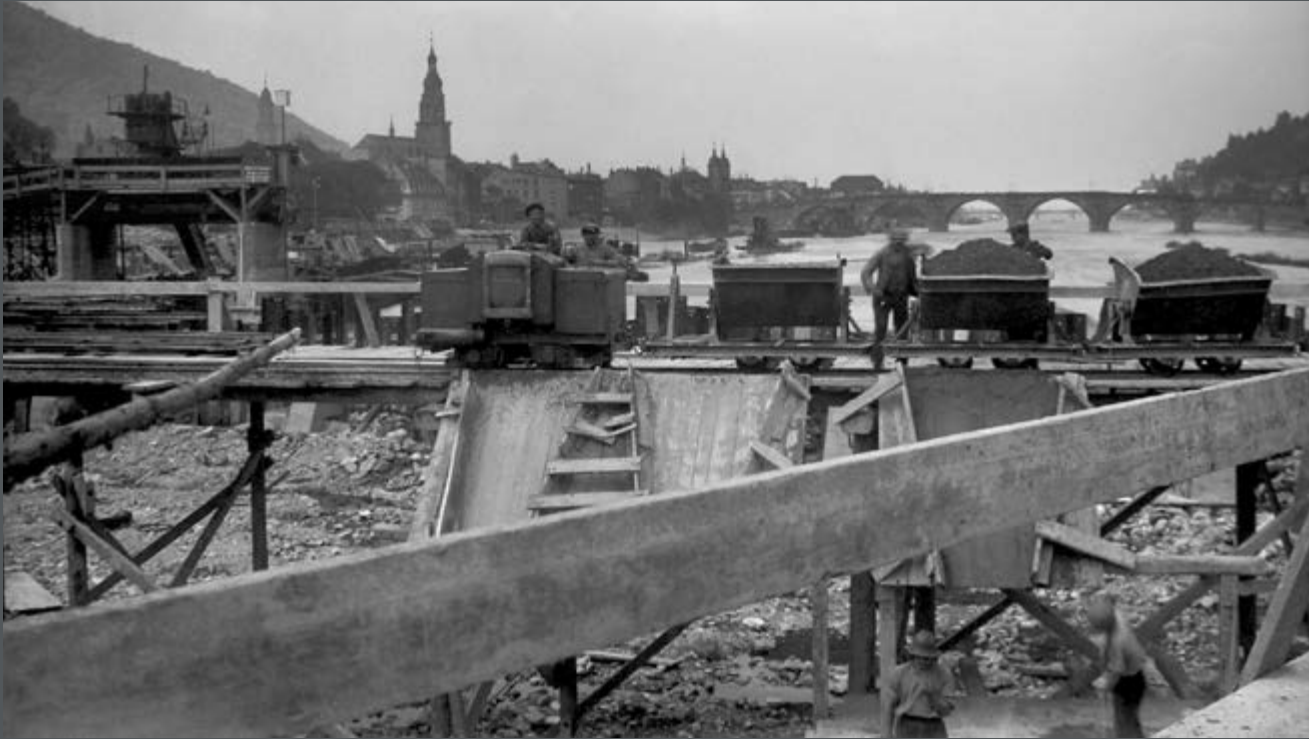
Bild 315: Eine Dampf- ramme auf Ponton rammt Stegdalben im Oberwasser für die Schleuse Feudenheim. (1928)
