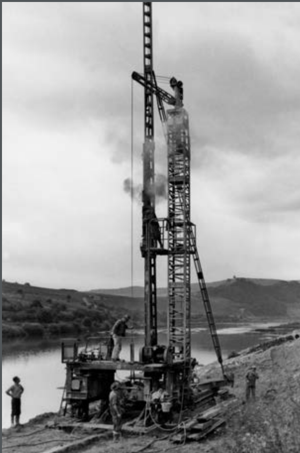
Bild 235: Herstellung einer Etmo-Dichtwand nahe der Haltung St. Aldegund an der Mosel. (1963)
