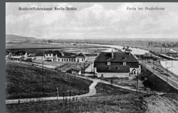
Bild 422: Blick Richtung Osten auf die fertige Schleuse IV mit dem Bauhof (Vordergrund) und auf das Unterwasser. Dort wird noch der untere Vorhafen ausgebaggert. (1914)
