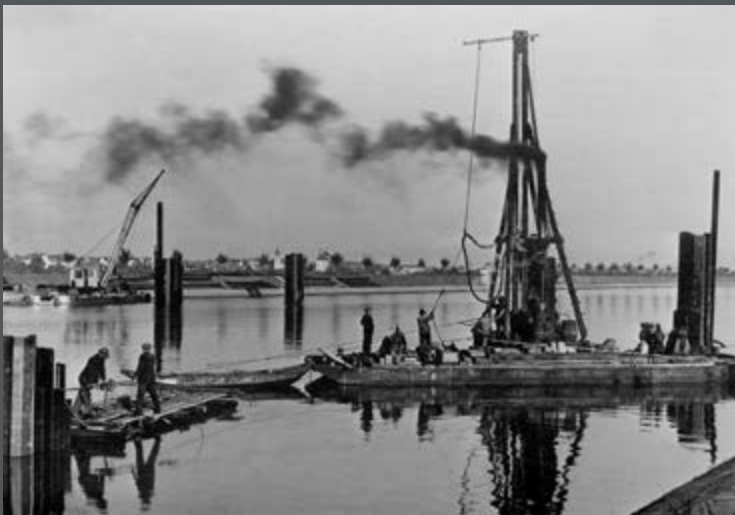
Bild 315: Eine Dampf- ramme auf Ponton rammt Stegdalben im Oberwasser für die Schleuse Feudenheim. (1928)
