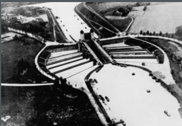
Bild 127: Luftbild der alten Schachtschleuse Henrichsburg am Dortmund-Ems-Kanal mit ehemaligen Sparbecken. (1945)
