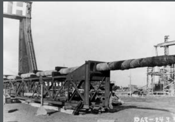
Bild 372: Die Spindeln für das Schiffshebewerk Rothensee werden in Transportgerüsten mit einer außen liegenden Leiterkonstruktion angeliefert. (1937)
