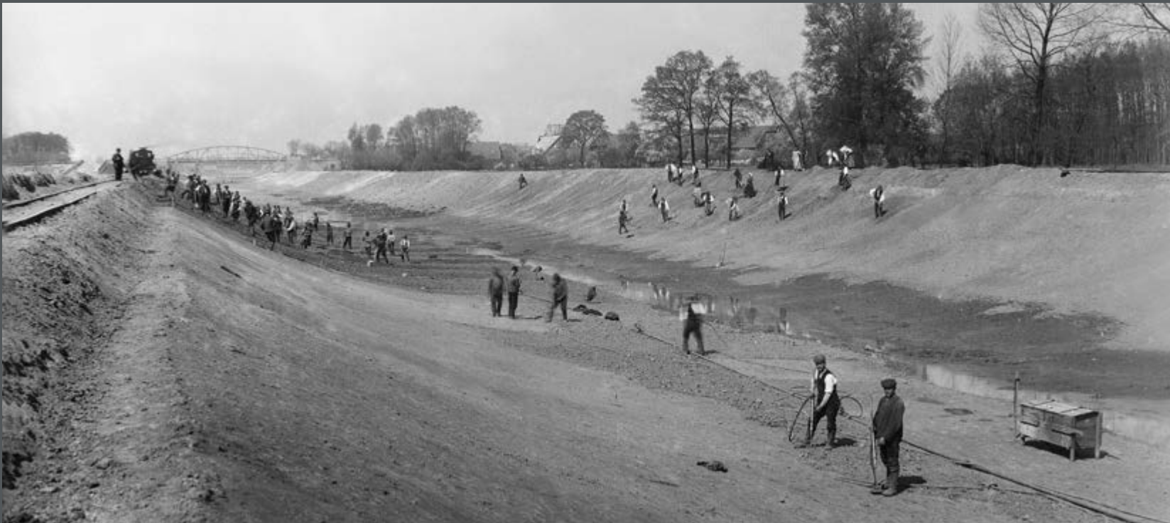
Bild 245: Arbeiten an der Tondichtung des Mittellandkanals mittels Pressluft- Tonstampfanlage. (1914)
