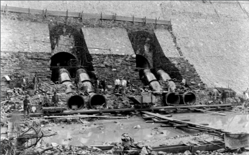
Bild 107: Grundablässe in den Stollen, von der Luftseite aus gesehen. (1912)
