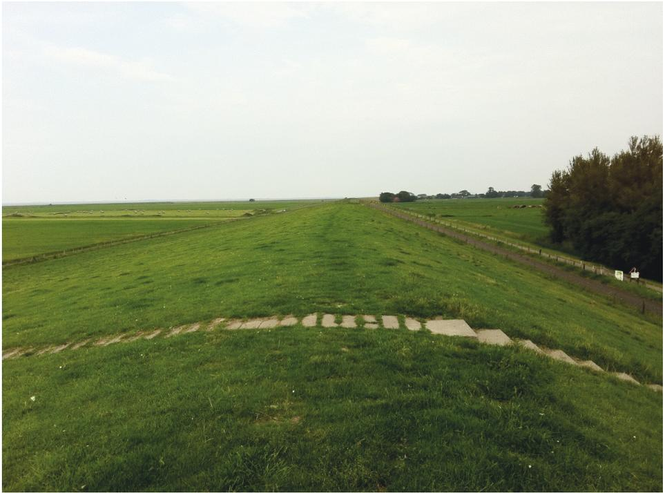
Abbildung 1: Deich als linienförmiges Hochwasserschutzbauwerk (Foto: Schüttrumpf 2011).
