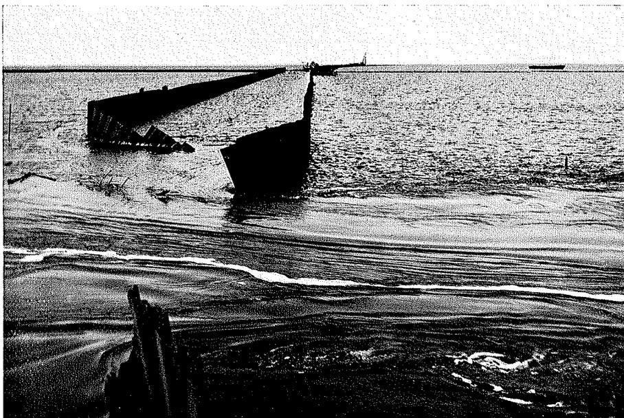
Abb. 4. Bruch der Spundwände an einem Nebenriel.
