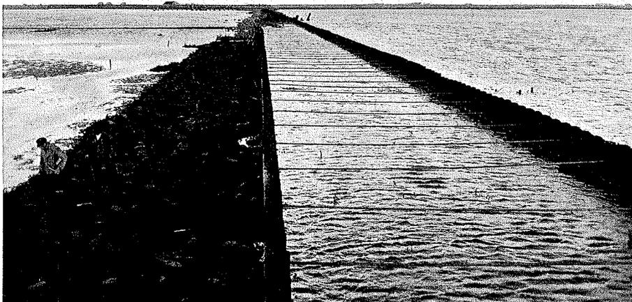
Abb. 3. Längsspundwände des Dammes.
