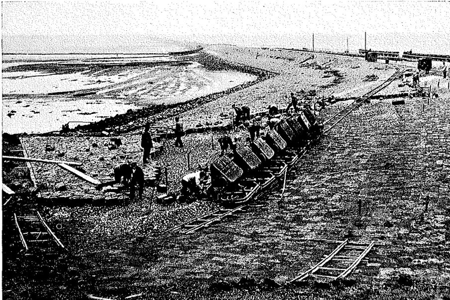
Abb. 12. Bau des Dammanschlusses an den Deich.
