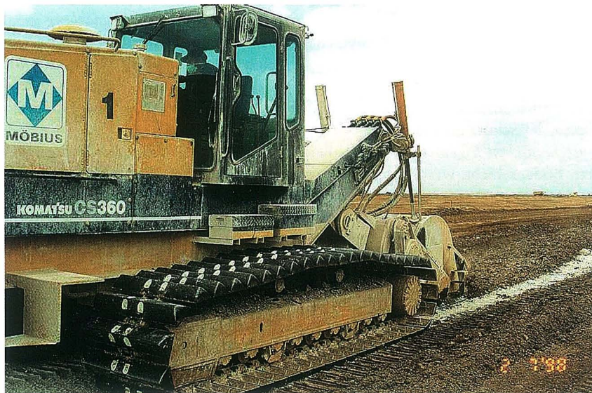
Abb. G 48h: Verbesserungsmaßnahmen durch Fräsen
