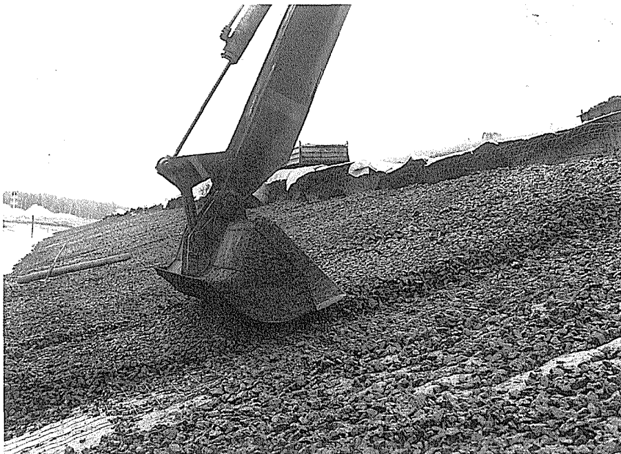
Abb. G 53: Verlegen von Mastixgstein mit dem Hydraulikbagger, leichtes Andrücken mit der leeren Schaufel
