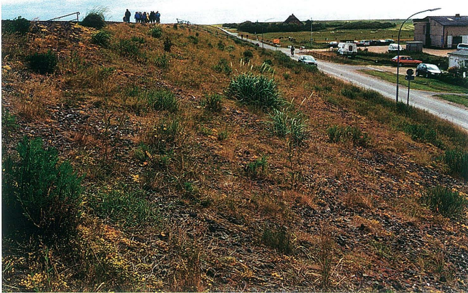
Abb. G 51c: Deichverstärkung Tümlauer Koog 1994/95 (Westabschnitt), Stat. 2+660 bis Stat. 2+860: Deckwerk aus 20 cm Mastixschotter auf der Außenböschung bis zur Dammkrone und 15 cm bis zum Fuß der Binnenböschung über das gesamte Deichprofil – wasserdurchlässig und begrünt
