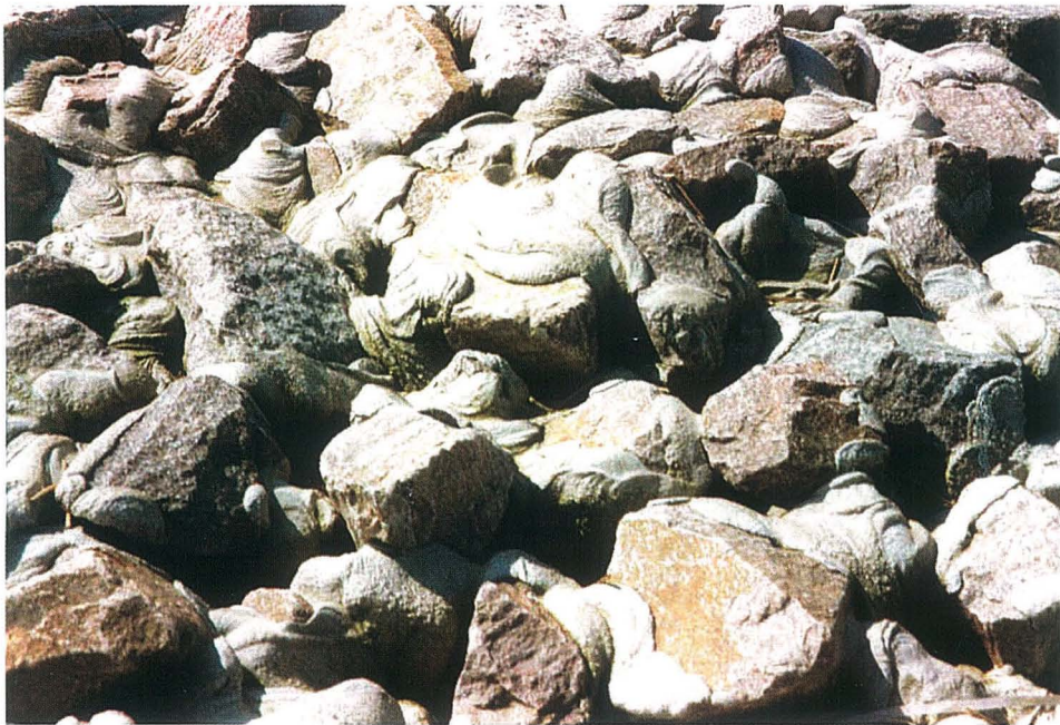
Abb. C 1: Verklammertes Deckwerk (Colcrete-Verfahren)
