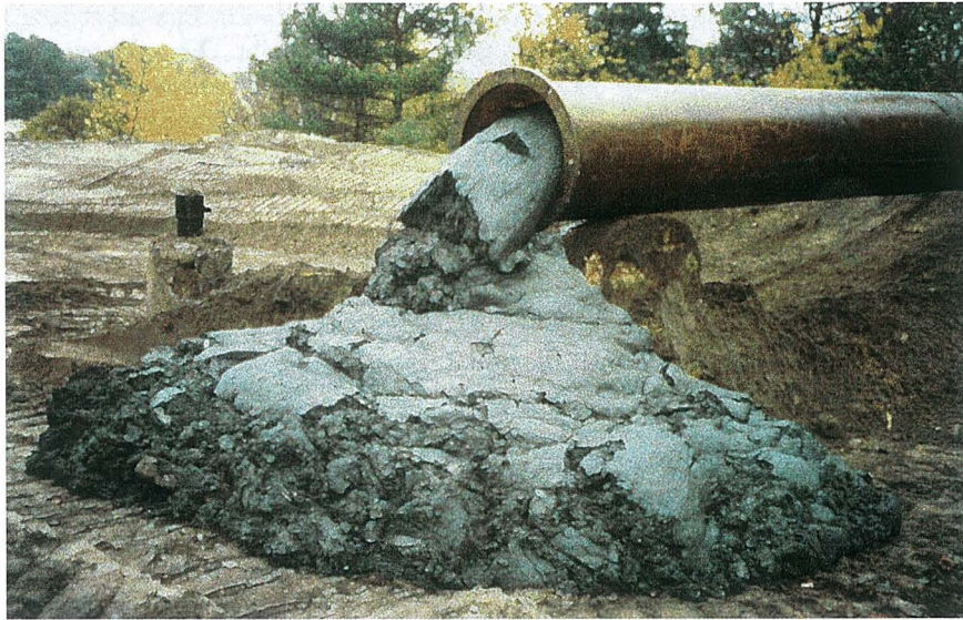
Abb. G 48c: Verbringen von Baggergut mit Großkolbenpumpe
