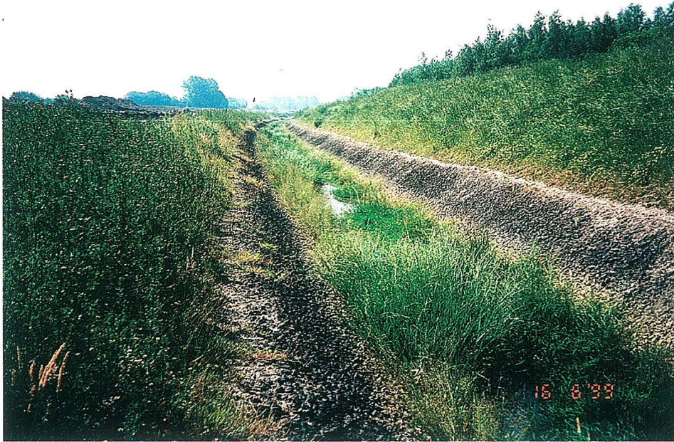
Abb. G 55b: Deich im Tidebereich des Elbe-Ästuars mit höherem Vorland bei Glückstadt, wasserseitiger Entwässerungsgraben zur schnelleren Wasserabführung: Begrüntes offenes Deckwerk aus Mastixgestein
