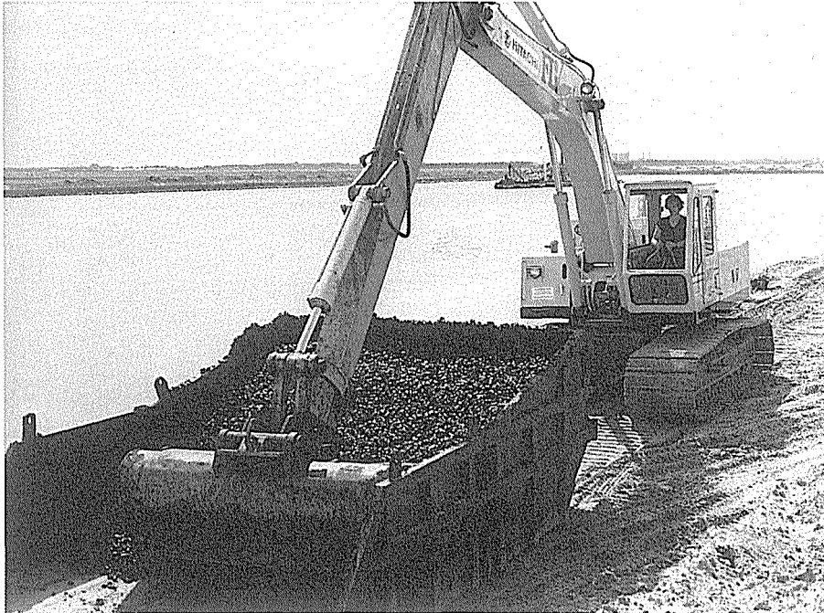
Abb. G 52: Container zur Zwischenlagerung von Mastixgstein an der Einbaustelle (BITUMARIN, 1990)
