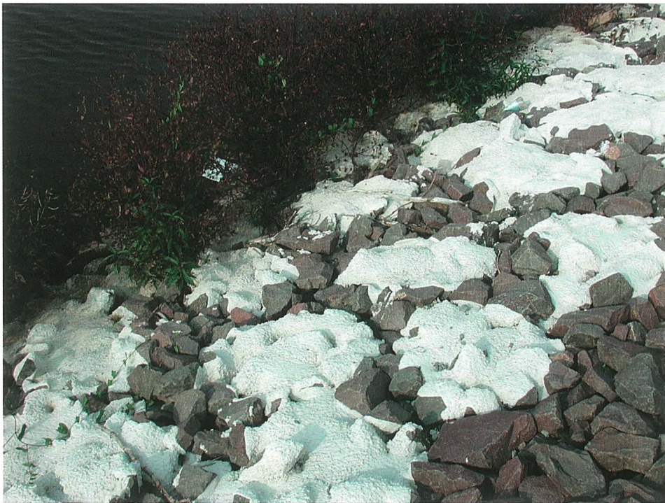
Abb. C 2: Verblockung: Deckwerk mit vergussarmen Zonen (Verblockungssystem Möbius)
