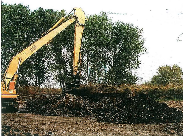
Abb. G 48f: Bodenverbesserung durch Fräsen
