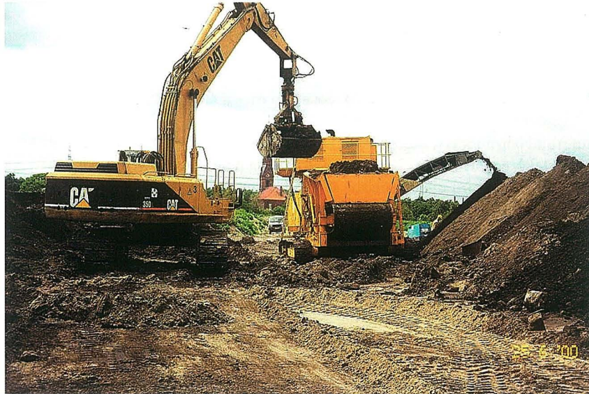
Abb. G 48g: Bodenverbesserung durch Aufbereitungsgeräte
