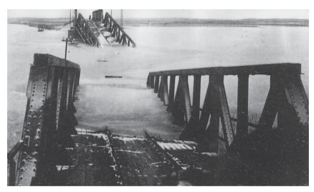
Abb. 3.1: Durch die Sturmflut am 30./31.12.1913 zerstörte Eisenbahnbrücke (Klör-Brücke) zwischen Bresewitz und Pruchten in Vorpommern (Darß-Zingster Boddengewässer). Foto: Archiv HUPFER
