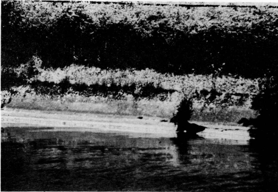
Bild 7: Ufersicherung mit Betonplatten
