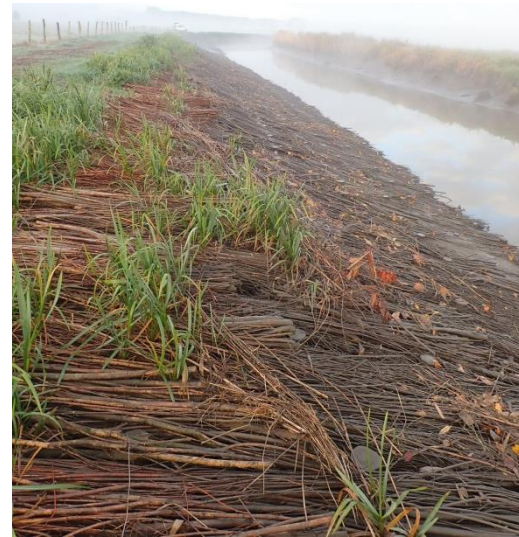
Packfaschinat zur Uferunterhaltung scharliegender Deiche bei Einbau (links) und 4 Wochen später (rechts).
