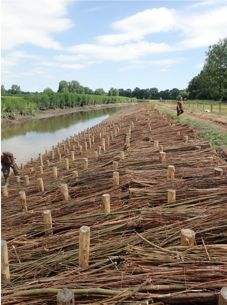
Packfaschinat zur Uferunterhaltung scharliegender Deiche bei Einbau (links) und 4 Wochen später (rechts).
