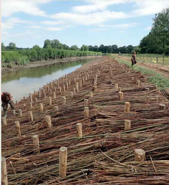
Totholzspreitlage ausgeführt als Packfaschinat zur Uferunterhaltung scharfliegender Deiche (WSA Weser-Jade-Nordsee)
