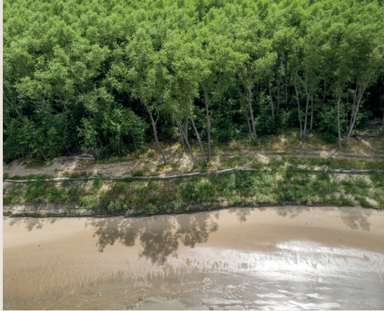
Beispiel einer Weidenspreitlage an der Elbe (BAW)
