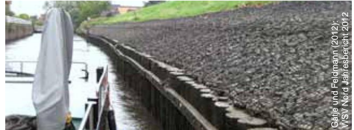
Eingebaute Pfahlwandsicherung (2012)
