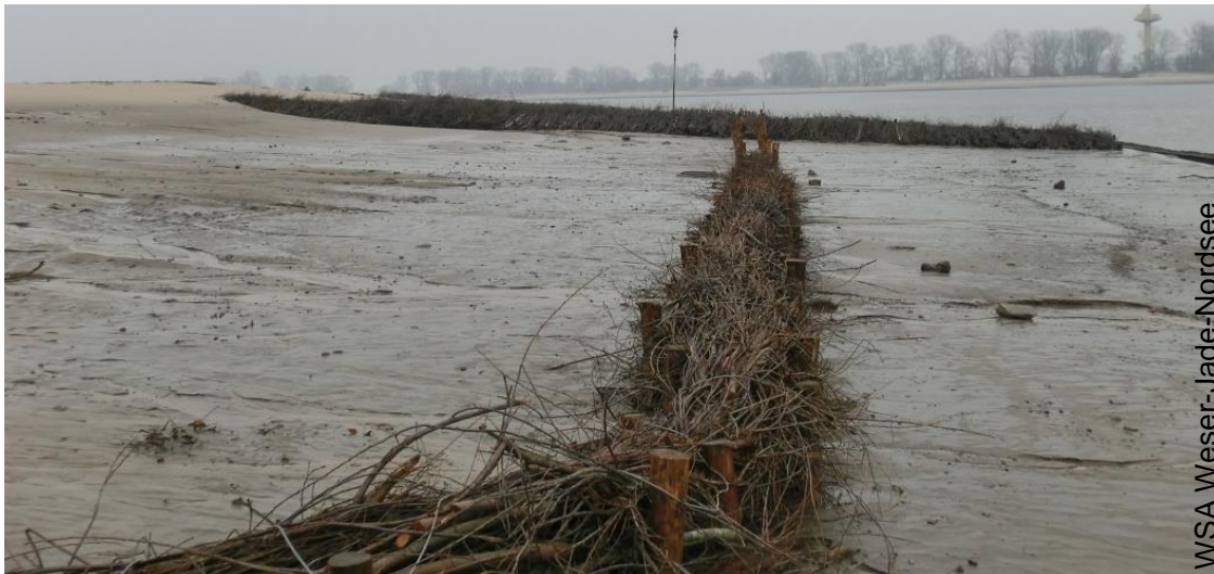
Leitdamm aus verspanntem Faschinenmaterial. Aufnahmen während des Baus in 2013.
