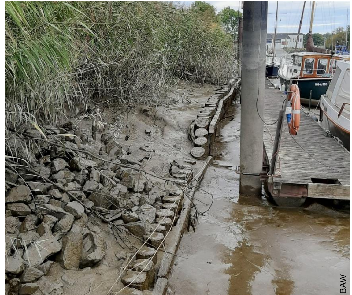
Maßnahme im Oktober 2020
