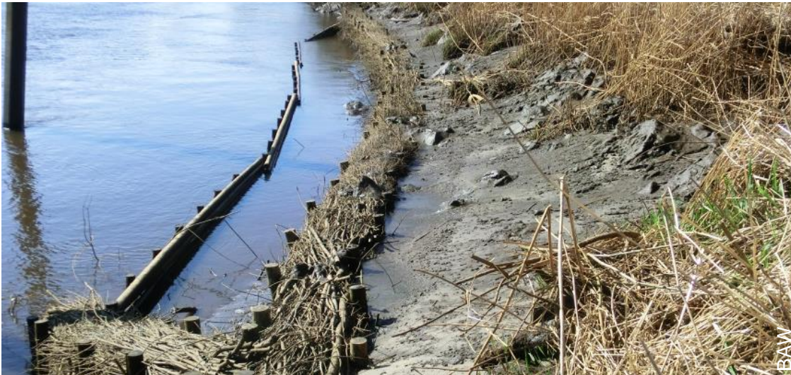
Versuchsstrecke 3 an der Wümmе: Buschkiste mit vorgelagerter Pfahlwand (2014)
