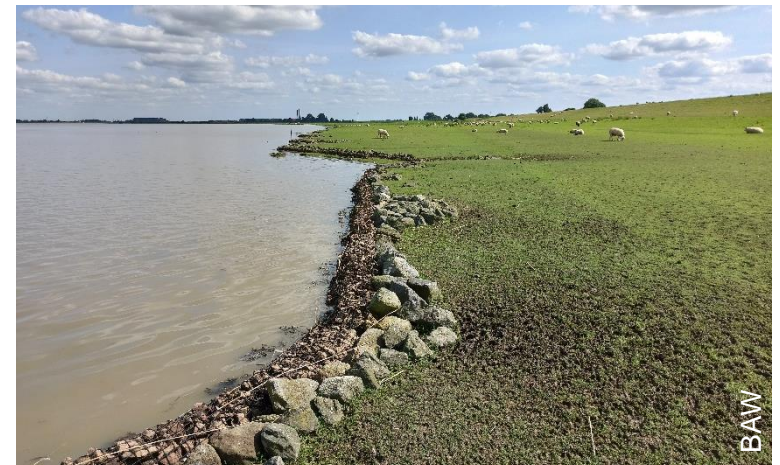
Erosives Ufer vor dem Bau der Maßnahme (links) und unmittelbar danach (Mitte) sowie in 2021 (rechts).
