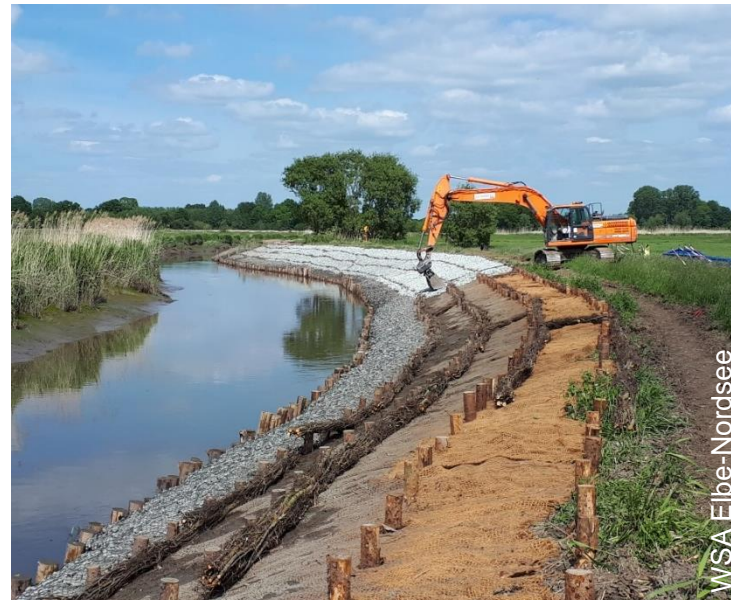
Bau der Maßnahme in 2020.
