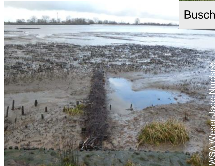
Buschkiste kurz nach Instandsetzung im Januar 2024.
