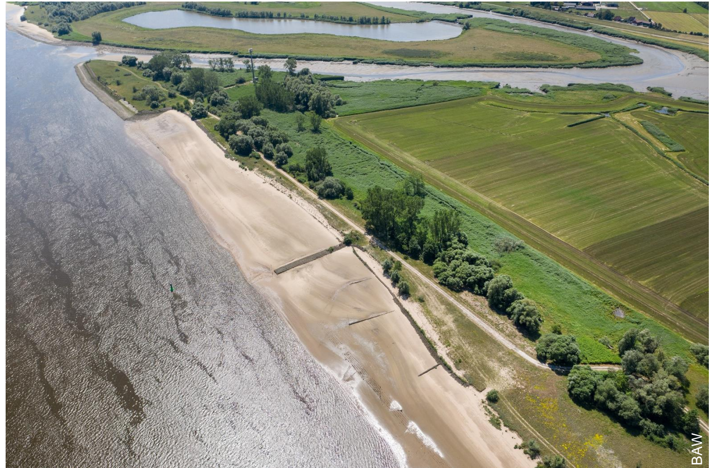
Spreitlagen-Längsbauwerk oberhalb der Bühnen.
