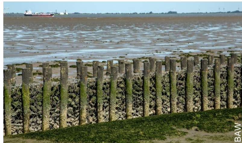
Sicherung der Abbruchkante mit Faschinenmatten in 2020.
