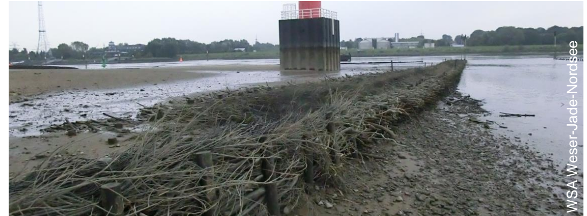
Buschleitdamm in Abschnitt 1 an der Hafenausfahrt bei km 25,0 in 2014.
