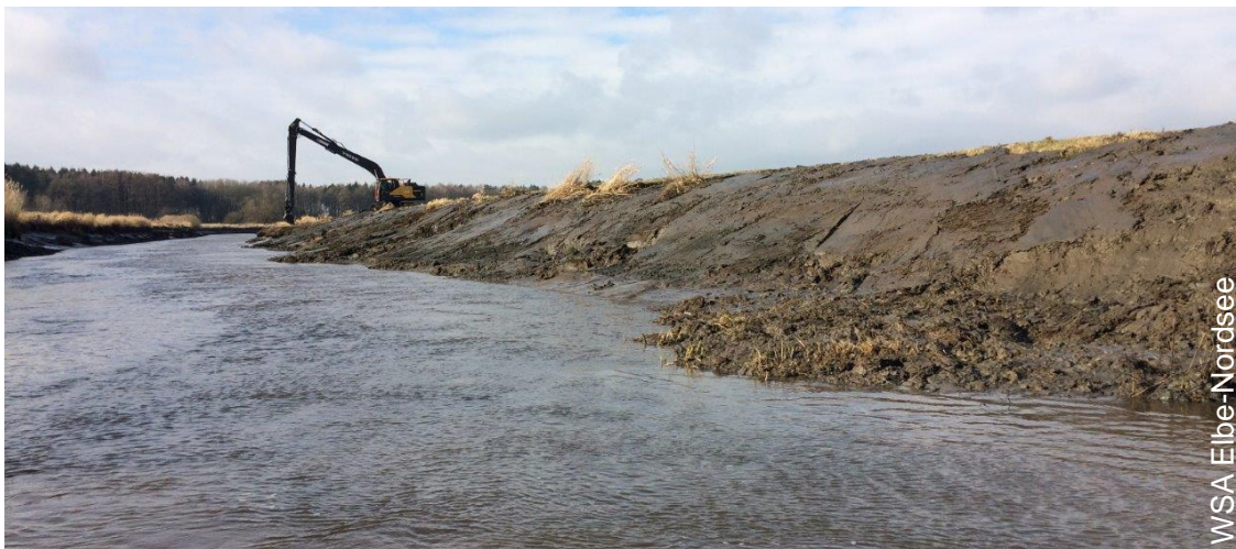
Böschungprofilierung in 2019.
