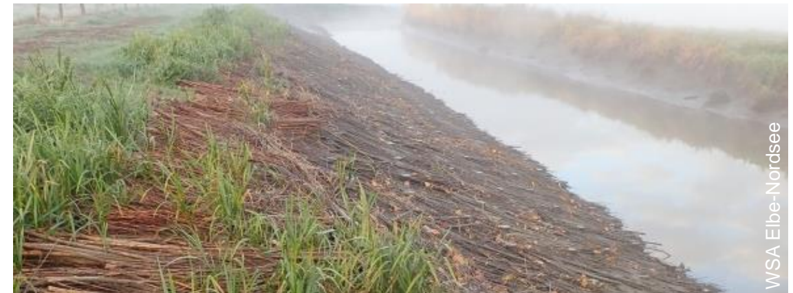
Maßnahme 4 Wochen nach Bauabschluss in 2018.
