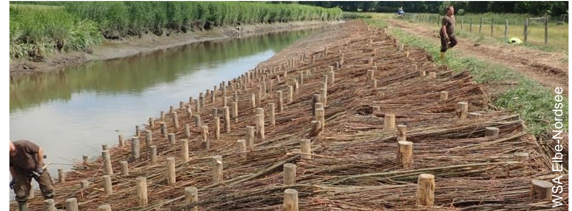
Maßnahme während des Baus in 2018.
