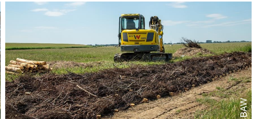
Sicherung der Abbruchkante mit Faschinenmatten in 2020.
