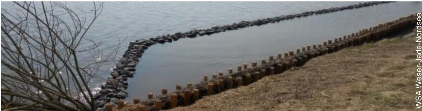
Parallelwerke aus Buschkisten und Schüttsteinen direkt nach dem Bau in 2018.
