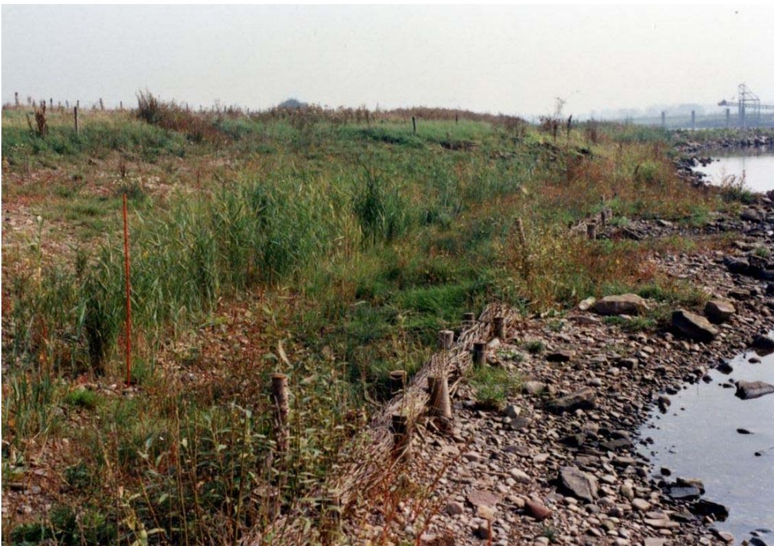
Bild 9.5: Röhrichtpflanzung am abgeflachten Ufer, geschützt durch eine Weiden-Faschine (Abschnitt 9; Sept. 1989)
