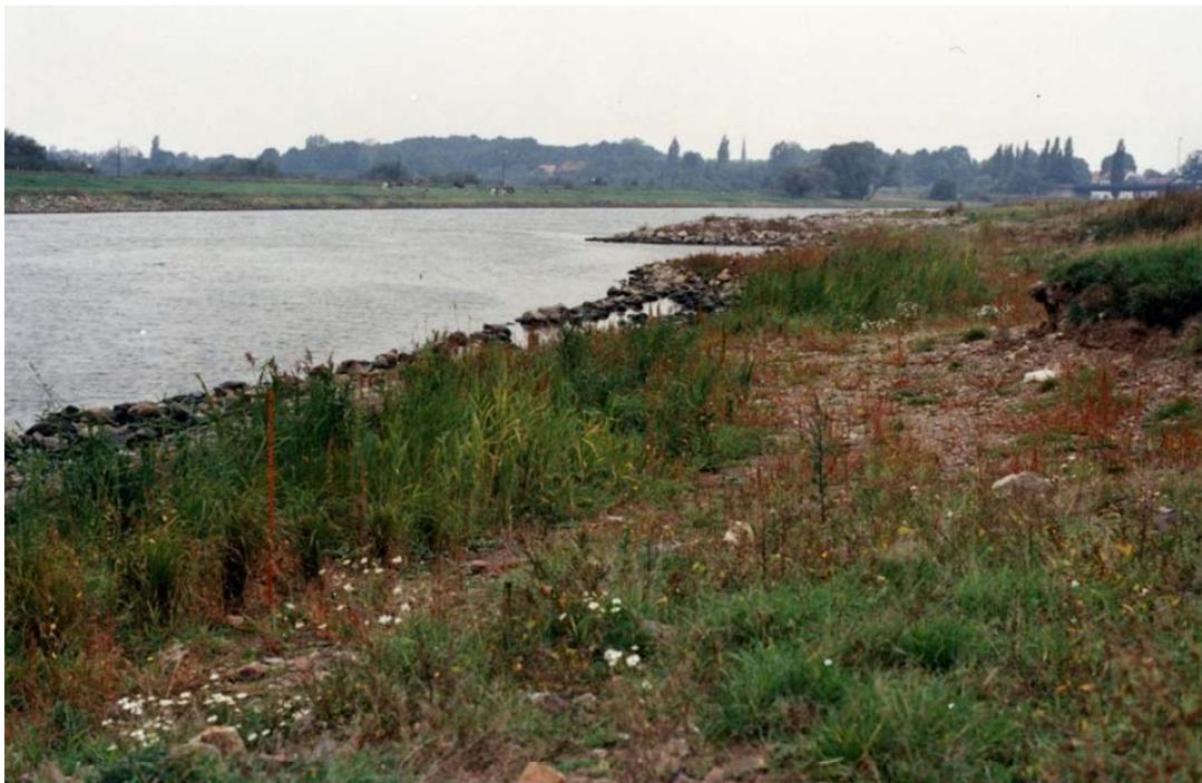
Bild 9.1: Schilf- und Seggenpflanzung an der abgeflachten Uferböschung: flusswärts ist der vorgeschüttete Steinwall sichtbar (Abschnitte 1 und 2; Sept. 1989; zu den Standorten der Fotos des Kap. 9 siehe Anlage 9.3)
