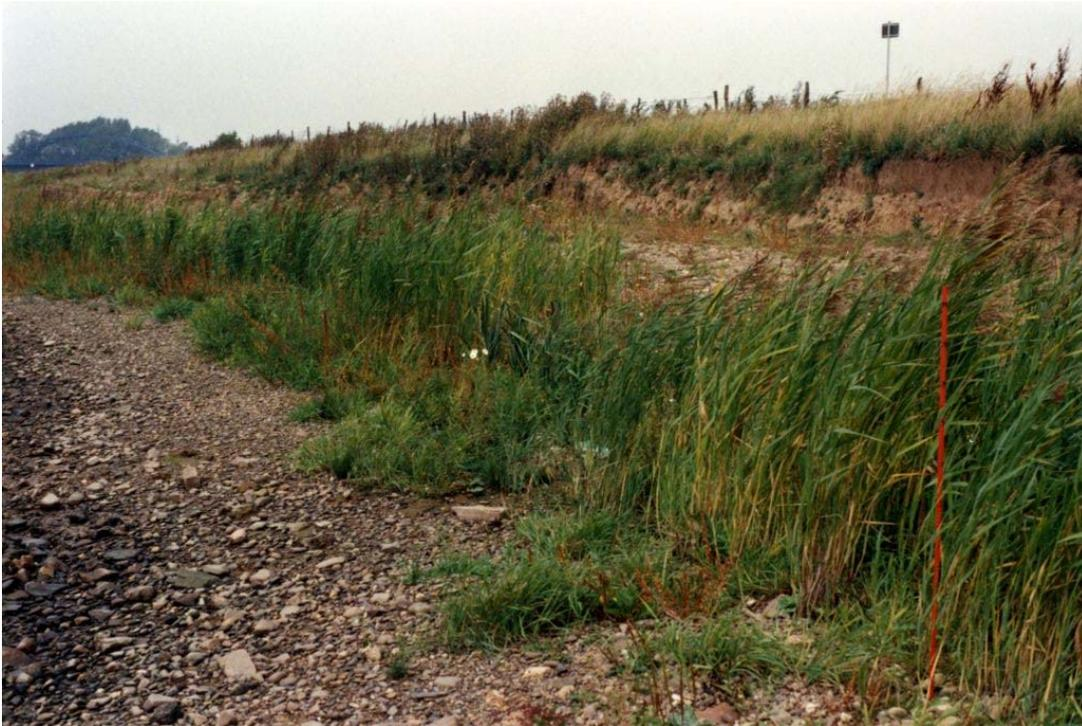
Bild 9.2: Röhrichtpflanzung an abgeflachter Uferböschung, Blick vom Ufer zur Steilkante (Abschnitt 2; Sept. 1989; der rote Stab ragt 1 m aus der Erde)
