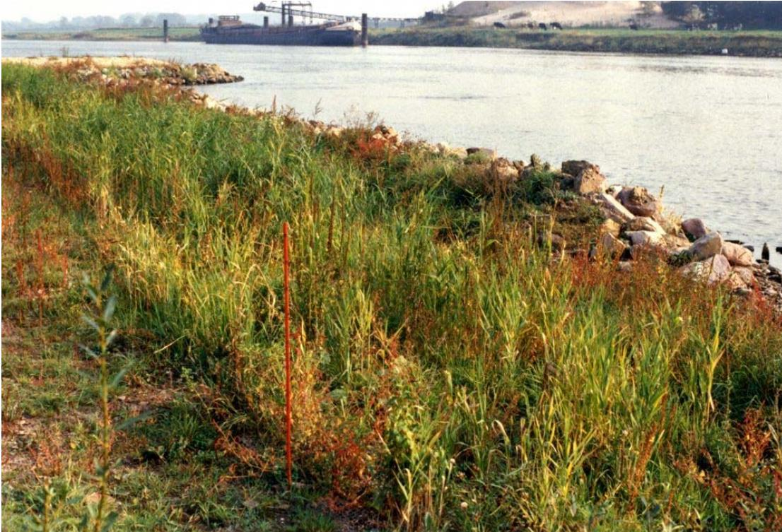
Bild 9.4: Röhrichtpflanzung am abgeflachten Ufer mit Steinwall. Im Hintergrund: Verladeanlage des Kieswerkes am gegenüberliegenden Ufer (Abschnitt 7; Sept. 1989)
