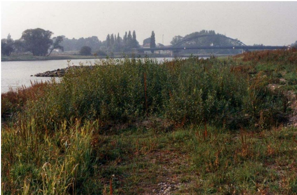
Bild 9.6: Die neu angelegten Weiden-Spreitlagen haben kräftig ausgeschlagen. Im Hintergrund: Straßenbrücke zwischen Stolzenau und Leese (Abschnitt 7a; Sept. 1989)
