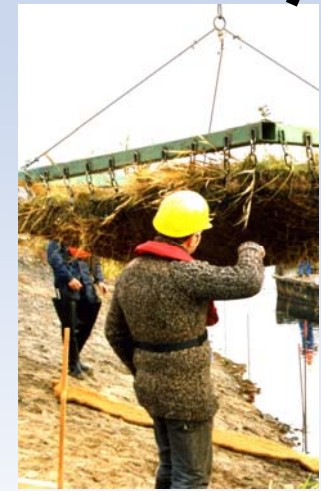
Géoattes pré-végétalisées avec roseaux
