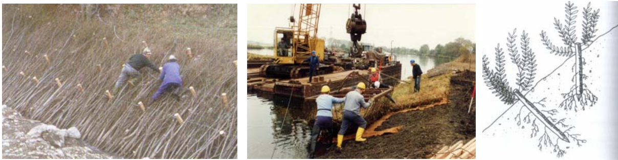
Abbildung 2: Biologische Ufersicherungen, links: Spreitlagen, Mitte: Vegetationsmatten, rechts: Stechkölzer
