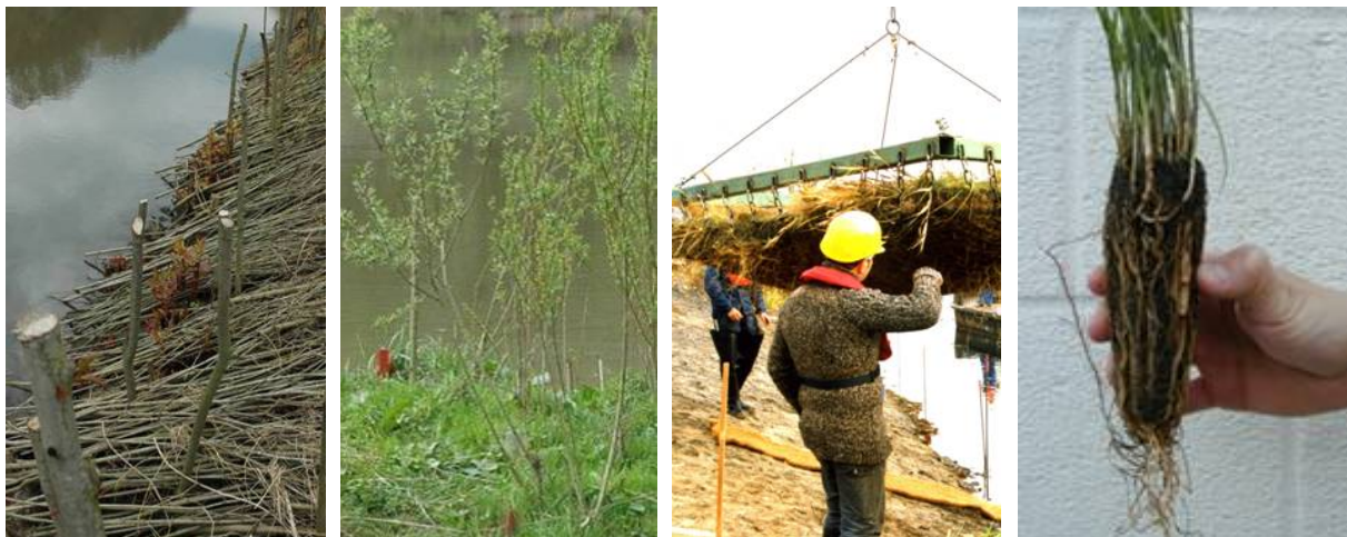
Abbildung 2: Verschiedene alternative Ufersicherungsmaßnahmen. Von links nach rechts: Weidenspreitlagen in Kombination mit Setzstangen, erster Blatt-Austrieb bei Setzstangen, Verlegung von Schilfmatten, bewurzelter Schilfballen. Quelle: Schneider, Wegener (BfG) .
