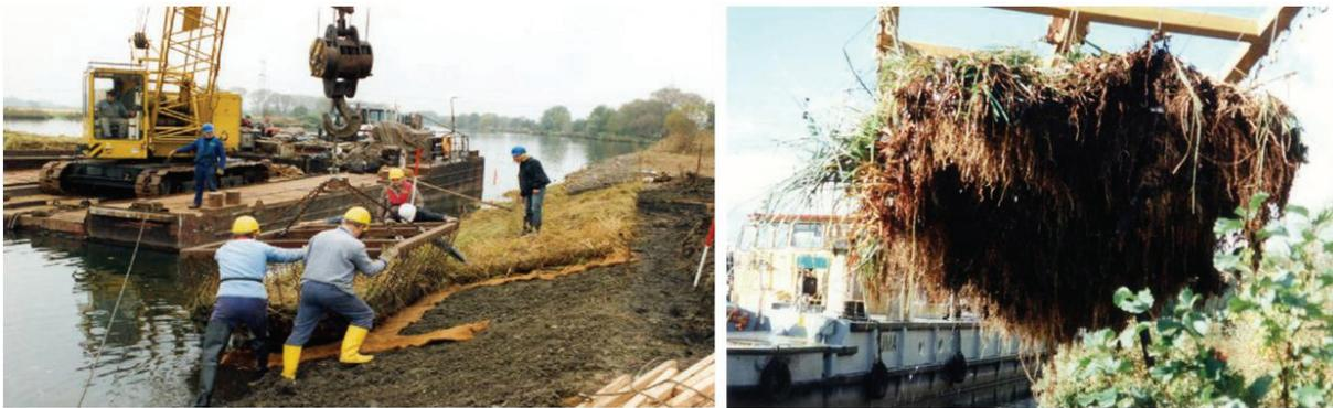
*Bild 6: Kammerdeckwerk: Einbauzustand/ Zustand nach 4 Jahren (Deckwerksaufnahme)*
