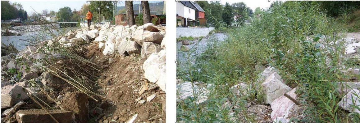
*Bild 7: Mit Steckhölzern begrünte Steinschüttung: Einbauzustand/ Zustand nach etwa 3 Monaten*
