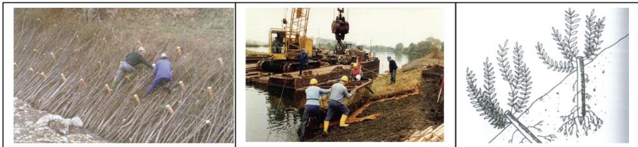
**Bild 3:** Flächig wirkende Ufersicherungen - links: Spreitlagen, Mitte: Kammerdeckwerke; Punktuell wirkende Ufersicherungen - rechts: Stekhölzer
