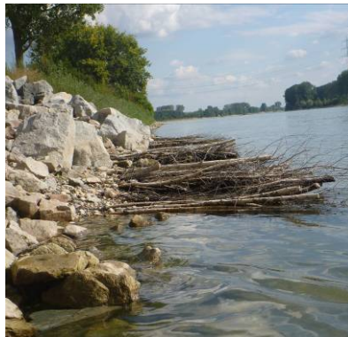
Abb. 2: Einbau von Totholzfaschinen und unterschiedlicher Substrate.
