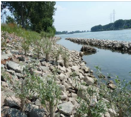
Abb. 1: Strukturverbesserung durch die Anlage eines wellengeschützten Bereichs, den Einbau von Totholz (Wurzelteller) und Bepflanzungen.
