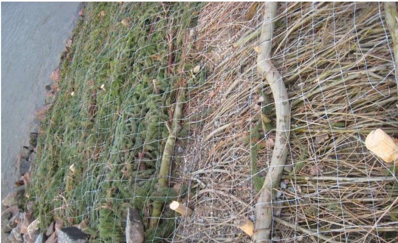
Bild 4.4-1: Versuchsfeld 3 nach Einbau (14.12.2011)
