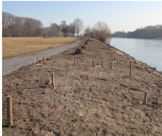
Bild 4.10-2: Zwei Reihen Setzstangen zwischen Betriebsweg und Böschungsschulter (Blickrichtung stromauf) - 22.2.2012
