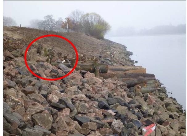
Bild 4.10-4: Ausfachungsbuhne und Weidensetzstangen (Markierung) (14.12.11)
