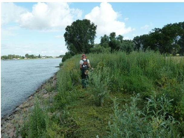
Bild 4.10-14: Freistellen der Weidensetzstangen per Freischneider (10.7.12)
