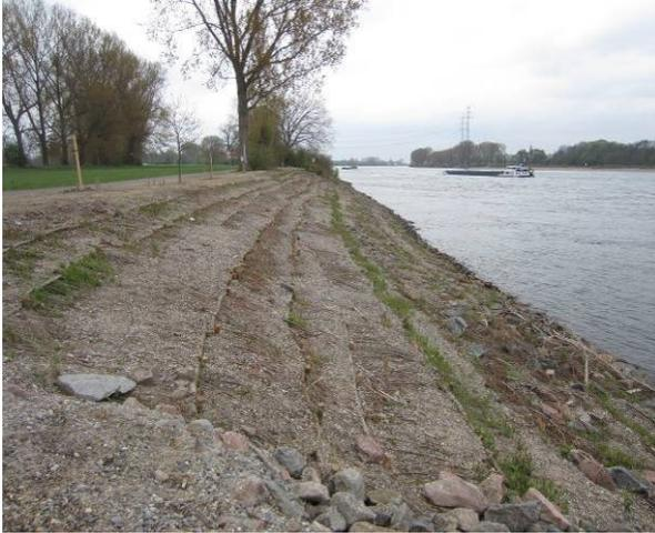
Bild 4.4-4: Erste Triebentwicklung überwiegend im Bereich der uferparallel aufgebraachten Riegelhölzer (16.4.2012; Blick nach oberstrom)
