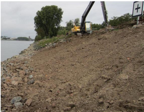
Bild 4.10-1: Böschungsoberfläche unmittelbar nach Rückbau der Steinschüttung (Blickrichtung stromab) - 13.9.2011
