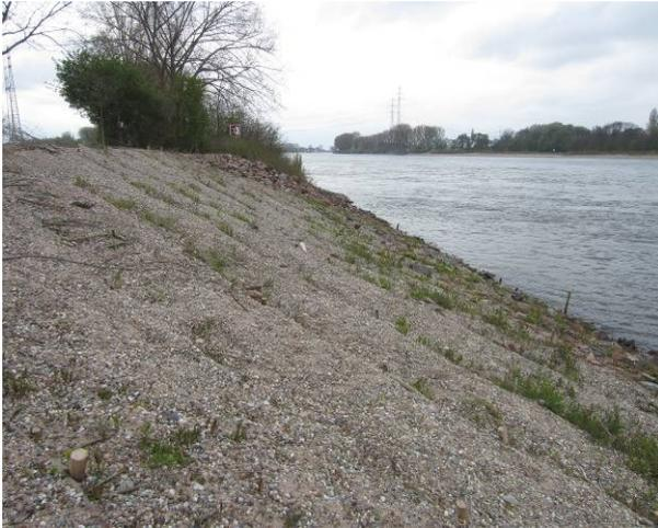
Bild 4.3-6: Erste Triebentwicklung überwiegend im Bereich der diagonal angeordneten Riegelhölzer (16.4.2012)
