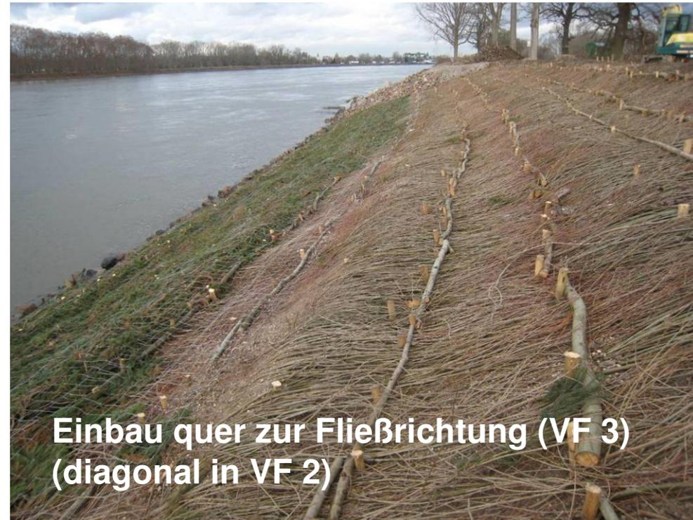
dichte Verlage, Befestigung mit Querriegeln, Pflöcken, Drahtverspannung, Maschendraht + Reisigabdeckung, Abdeckung mit kiesig-sandigem Substrat
