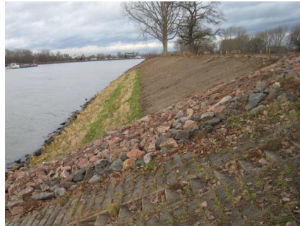
Bild 5: Röhrichtgabionen und Steinmatratzen nach Fertigstellung, 14.12.2011 (VF 5)
