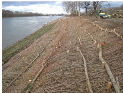
Bild 7: Weidenspreitlagen unmittelbar nach dem Einbau, 14.12.2011 (VF 3)
