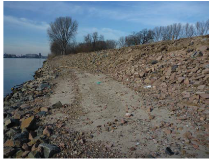
Bild 13: VF 9 ohne Böschungsschutz (22.02.2012)
