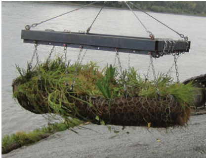
Bild 4: Röhrichtgabionen während des Einbaus auf einem Kornfilter, 12.10.2011 (VF 5)
