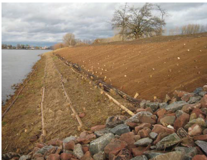
Bild 6: Pflanzmatten auf Filtervlies und Kokosgewebe über Nassansaat unmittelbar nach dem Einbau, 14.12.2011 (VF 7)
