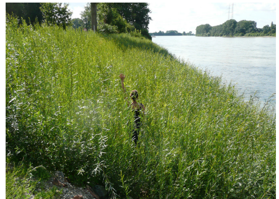
La rive droite du Rhin – km 440,820 à km 440,950 (tapis de branches à rejets de saule)
