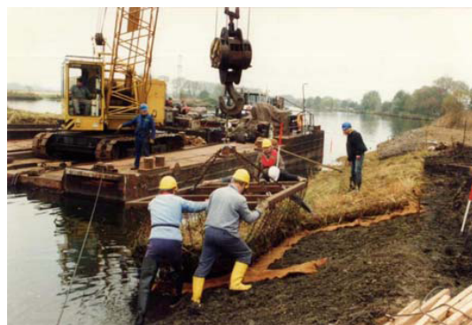
La rive droite de la Havel inférieure (UHW) – km 35,70 (mise en place)
