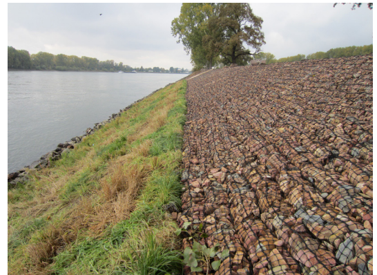
La rive droite du Rhin – km 441,000 à km 441,110 (gabions de roseaux, nattes de pierres)
