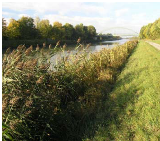
La rive gauche du Mittellandkanal – km 189,50 à km 190,00
