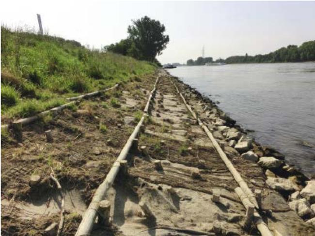
Abb. 6: Schadhafte Pflanzmatten nach langem Einstau im unteren Böschungsbereich 15.7.2013 (VF 7)
