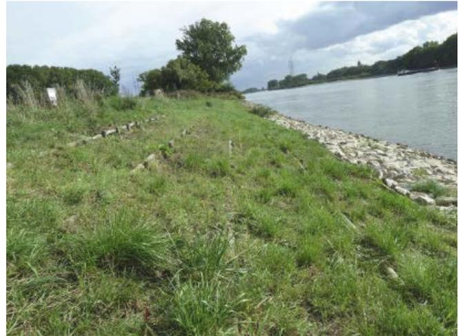
Abb. 7: Gut entwickelte Pflanzmatten im oberen Böschungsbereich (Oktober 2014)
