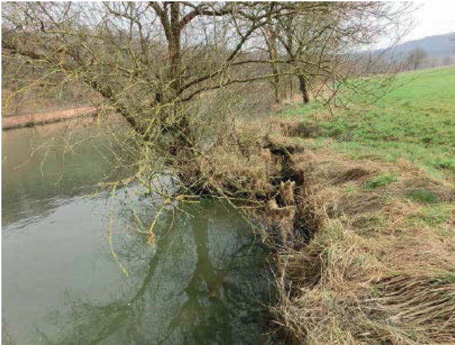
Abb. 6: Lokale Erosion stromabwärts hinter einem einzeln stehenden Baum – Ne-km 77,40, Blickrichtung stromauf (März 2015)
