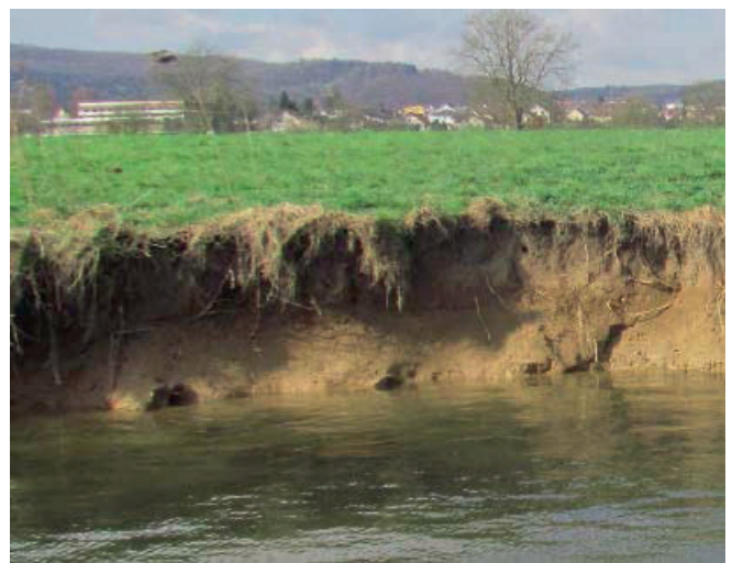
Abb. 5: Aktueller Uferzustand – Ne-km 79,70 (März 2015)
