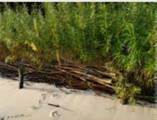
Walze aus austriebsfähigem Weidenreisig an der Elbinsel Hanskalbsand. Quelle: Schmitt (BfG)
