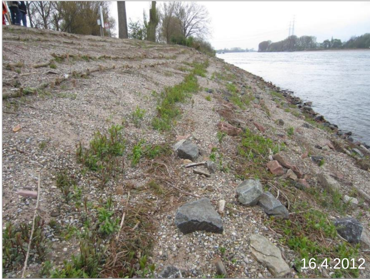
Auffällig: Bevorzugte Austriebe im Bereich der Querriegel
