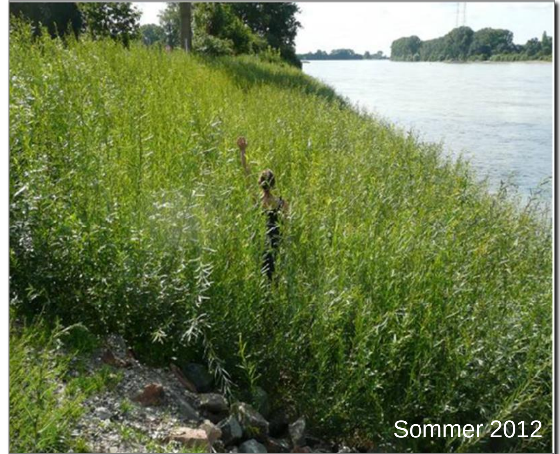
Gute Stabilisierung mit zunehmendem Wurzel- und Sprosswachstum
