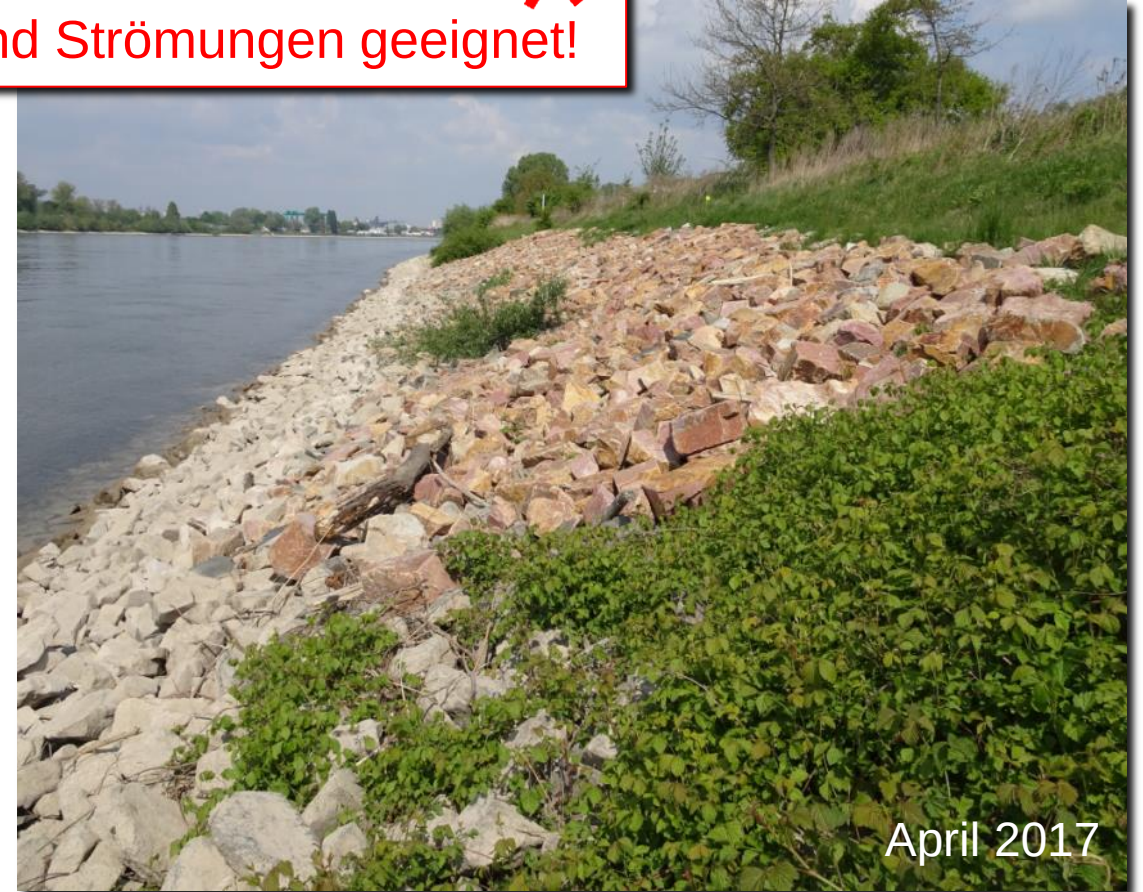
Sanierung mit Wasserbausteinen (einlagig) Anfang 2017 - nach Zunahme der Schäden
