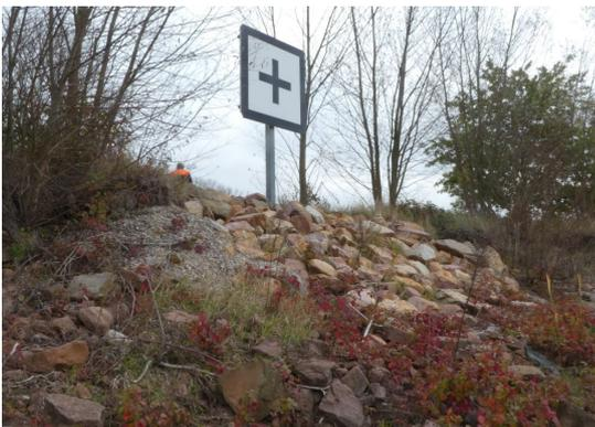
Bild 39: Mit Wasserbausteinen gesichertes km-Schild bei km 441,500 (7.11.2017) (Foto: BAW)
