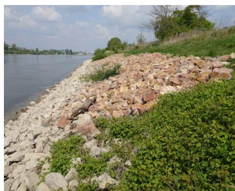
*Bild 28: links: Größte Schadstelle im VF 7a, oben, km 441,200 (11/2015), rechts: Zustand nach der Sanierung (4/2017) (Fotos: BAW)*
