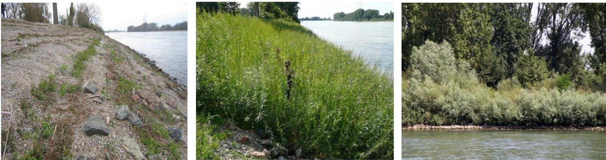
Bild 9: Übersicht: Entwicklung Weidenspreitlagen im VF 3 – 4/2012 (links), 7/2012 (Mitte), 7/2017 (rechts) (Fotos: BAW)
