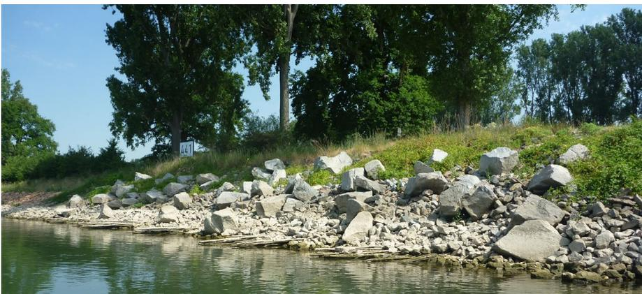
*Bild 32: Bewuchsfreie untere/mittlere und stärker bewachsene, hydraulisch weniger belastete obere Böschungszone (06/2017) (Foto: Steffen Wieland, BfG)*
