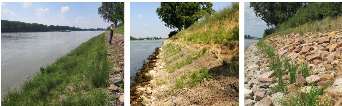
Bild 17: Entwicklung der Gabionen, von links: 07/2012 – 07/2013 – 07/2017 (mit einer Steinlage sanierter Zustand) (Fotos: BAW)
