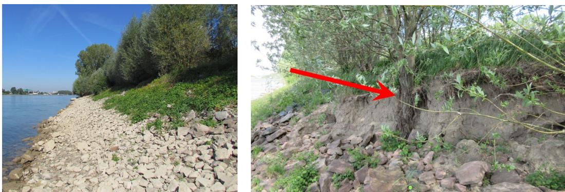
Bild 37: links: Aus dem Untergrund freigespülte alte Wasserbausteine im VF 9 (8.9.2016), rechts: Freigespülte Setzstangen (26.4.2018) (Fotos: BAW)
