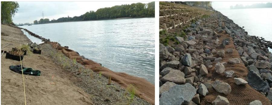
Bild 29: Röhrichtwalzen beim und nach dem Einbau 2011 (Fotos: Katja Behrendt/Hans-Werner Herz, BfG)
