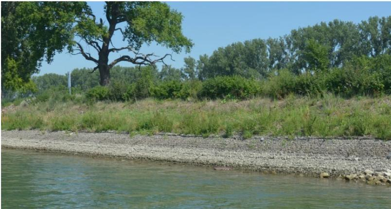
*Bild 20: VF 5b – Steinmatratzen, in der oberen Böschungshälfte gut bewachsen, in der unteren nahezu ohne Bewuchs (2.7.2015) (Foto: BAW)*
