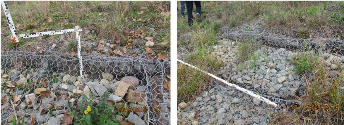
*Bild 18: Röhrichtgabionen am 10.11.2015, senkrechte Kante durch Steinverlagerungen innerhalb der Gabionen (Fotos: BAW)*
