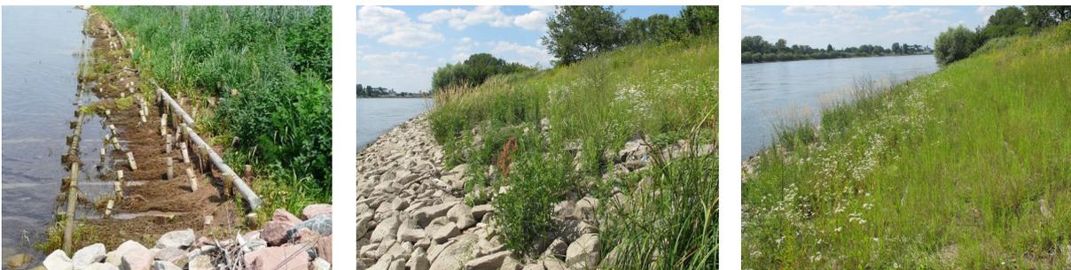
Bild 22: Schäden im unteren Böschungsbereich 5/2012 (links), sanierter Zustand 7/2017 (Mitte); gute Entwicklung im oberen Böschungsbereich (rechts) 7/2017 (Fotos: BAW)
