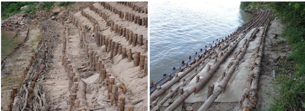
Abbildung 8: Woll-Saatmatte und abbaubares Geotextil nach Hochwasser; links: 21.05.2024; rechts: 13.06.2024 (Fotos: ABz Worms/Oppenheim).
