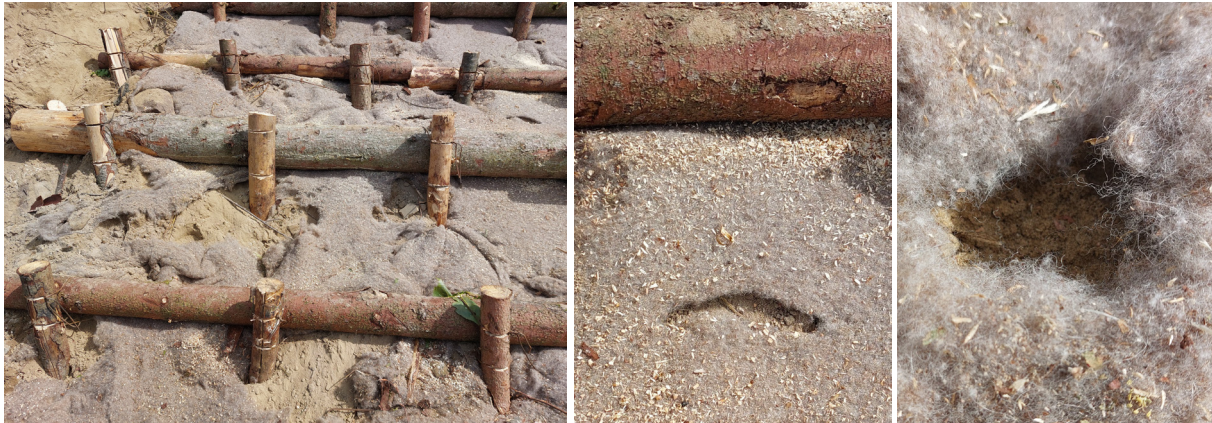
Abbildung 7: Beim Einbau beschädigte Saatmatte am 17.04.2024 (Fotos: BAW).
