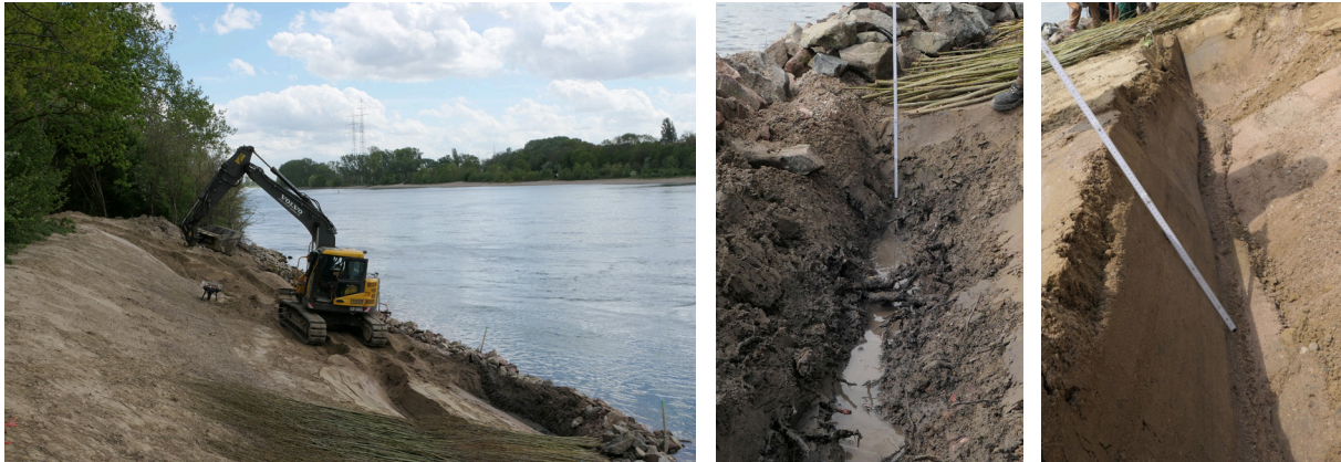
Abbildung 2: Einbindegräben im VFv2.3.u am 15.04.2024 (Wasserstand: MW -7cm); links: angelegte Gräben; Mitte: unterer Graben; rechts: oberer Graben (Fotos: BAW).
