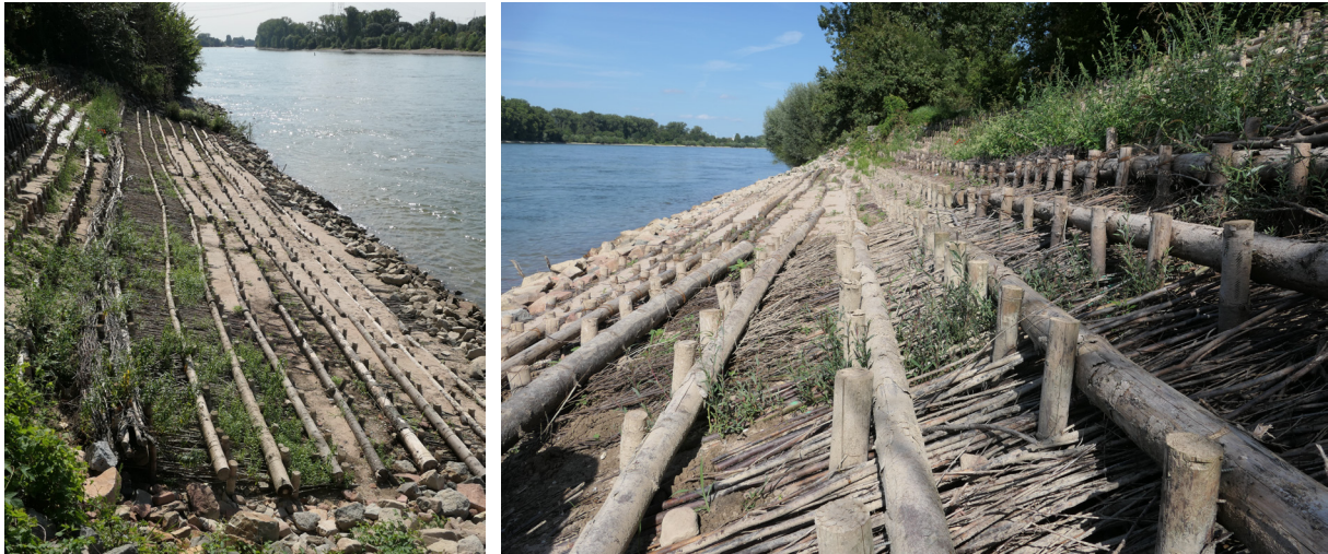
Abbildung 10: Weidenspreitlage am 22.08.2024; im Hintergrund des rechten Abbildung sind die Weiden des Versuchsfelds 3 abgebildet (Fotos: BAW).
