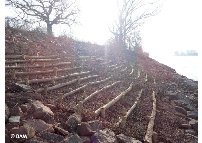
März 2021: Untersuchung des Einflusses des Geotextils auf Wurzel- und Sprossbildung unter Wasserstraßenbedingungen
