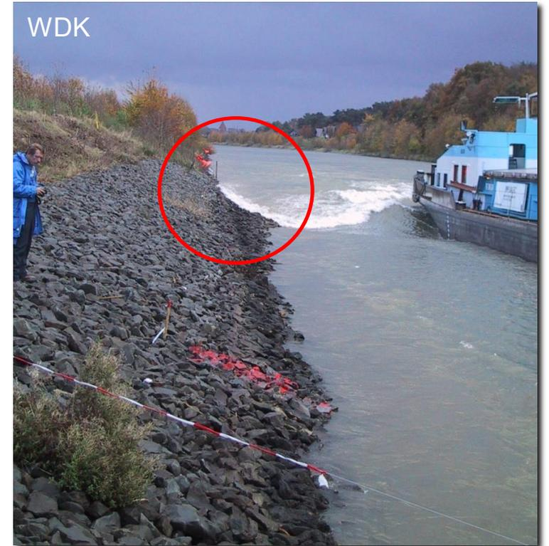
Für TBU relevant: Wellenauflauf und Wiederauffüllungsströmung – Oberflächenerosion
