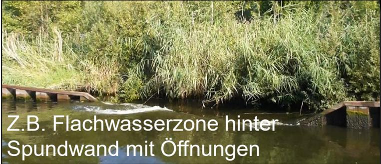
Z.B. Flachwasserzone hinter Spundwand mit Öffnungen
