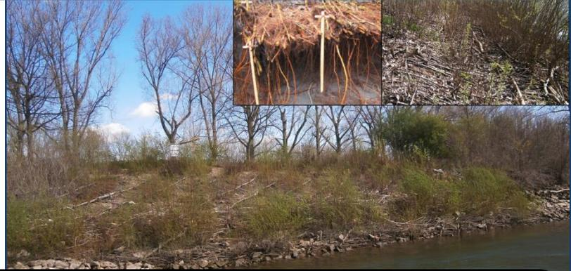
**DC:** Staugeregelter Fluss, Böschung kann abgeflacht werden, moderater Höhenunterschied zum Hinterland, mittelstarke schiffsinduzierte Belastungen; Ziel: Ökol. Aufwertung, möglichst auch der Flachwasserzonen, moderate Stabilitätsforderung wegen geringem Risiko
