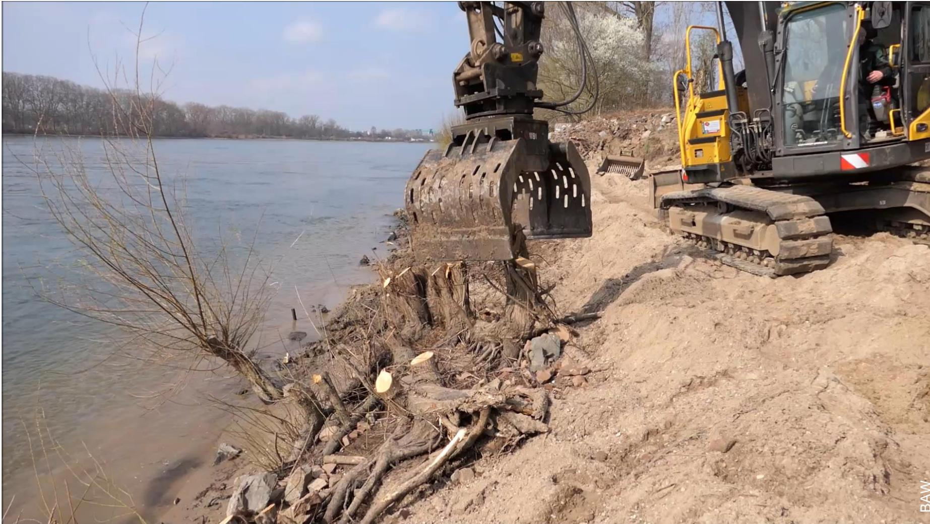
Flächige Durchwurzelung der oberen Bodenschicht mit teils sehr dicken Wurzeln.
