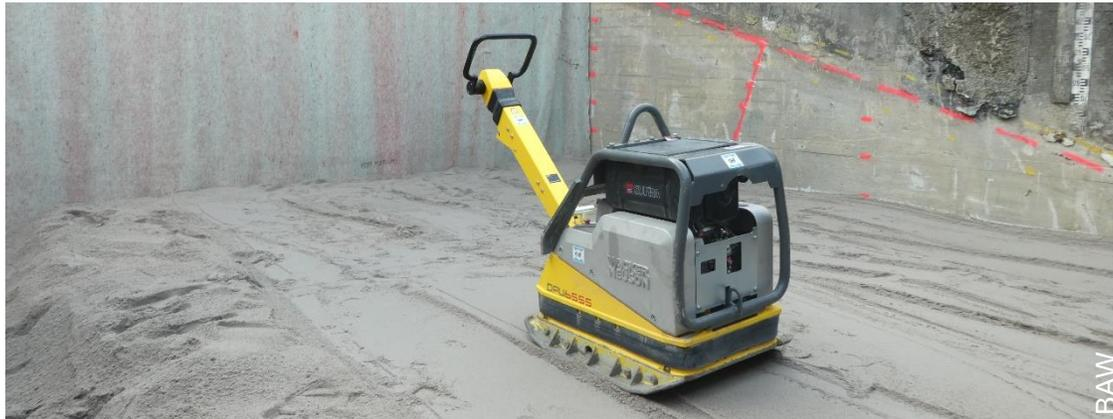
Einbau der Sandböschung im Wellenbecken (2017)
