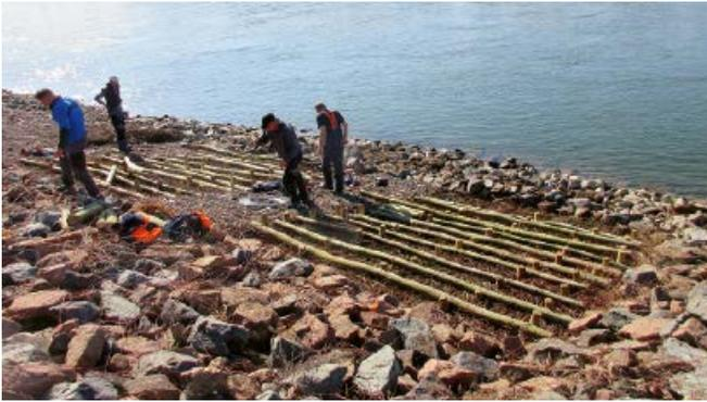
Abb. 8: Einbau der Weidenspreitlage am Rhein am 2.3.2021 (links auf Geotextil, rechts ohne Geotextil)
