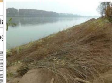
(3) In die Gräben eingelegte Weidenäste (mehrlagig in Böschungsfällrichtung verlegt); Nov. 2011
