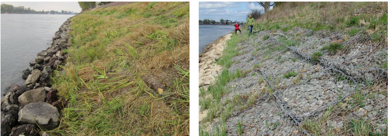
**Bild 3: Röhrichtgabionen im unteren Böschungsbereich, links: Nach Einbau (10/2011), rechts: 5 Jahre danach (04/2016)**
