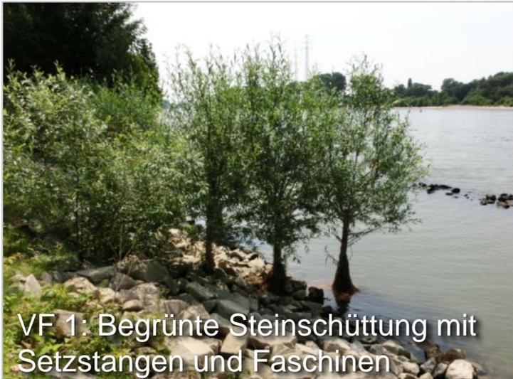
VF 1: Begrünte Steinschüttung mit Setzstangen und Faschinen
