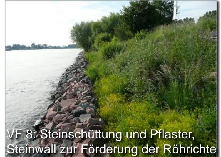
VF 8: Steinschüttung und Pflaster, Steinwall zur Förderung der Röhrichte
