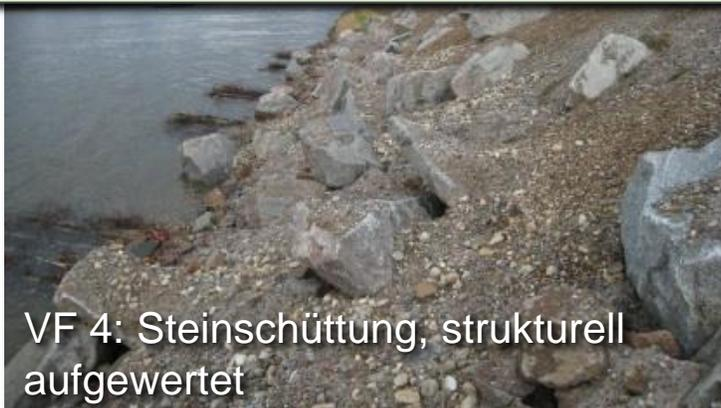
VF 4: Steinschüttung, strukturell aufgewertet
