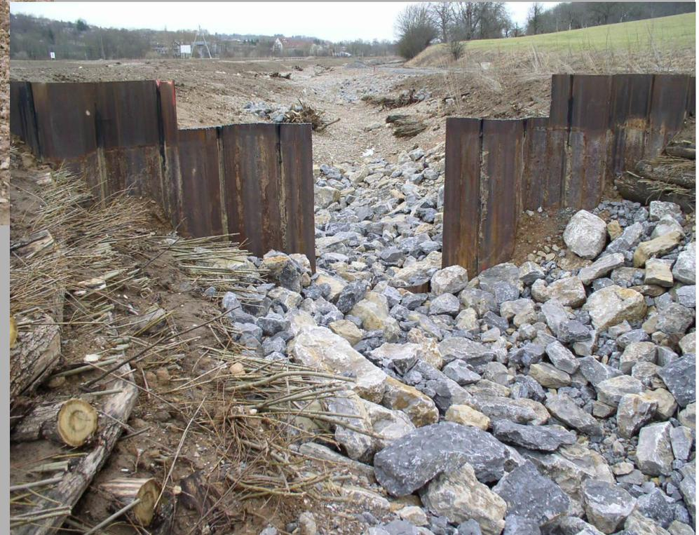
Spundung als Querbauwerk im Umgehungsgerinne mit geometrisch genau bemessener Durchflussöffnung zur Limitierung des Maximalabflusses auf ca.  $7\text{m}^3/\text{s}$
