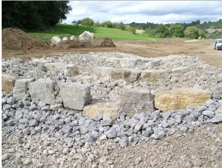
**Steinriegel mit definierten Durchlassöffnungen zur Abflussregelung**
