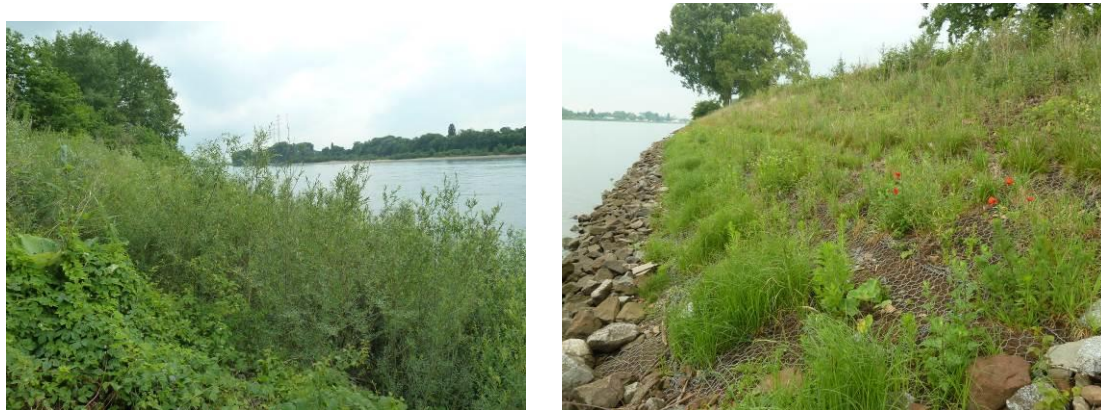
Abbildung 2: Entwicklung der Weidenspreitlage (VF2, links); Röhricht und Hochstauden (VF5, rechts)
