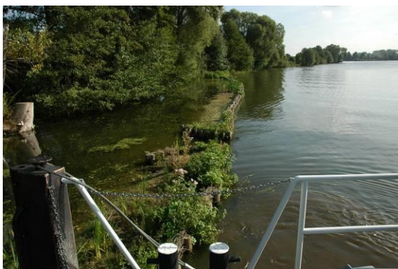
Abbildung 3: Elemente zur Strukturaneicherung und zum Schutz der Ufer und der Ufervegetation; Schutz von Flachwasserbereichen gegenüber Wellenschlag; Holzpfahlreihe (links), Totholzbühne (rechts)
