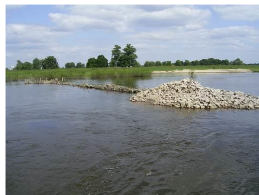
Abbildung 3: Elemente zur Strukturaneicherung und zum Schutz der Ufer und der Ufervegetation; Schutz von Flachwasserbereichen gegenüber Wellenschlag; Holzpfahlreihe (links), Totholzbühne (rechts)
