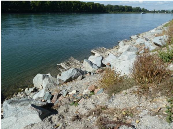
Bild 13: Hoher Feinsubstratanteil auf Steinschüttung im oberen Böschungsbereich (20.9.12)
