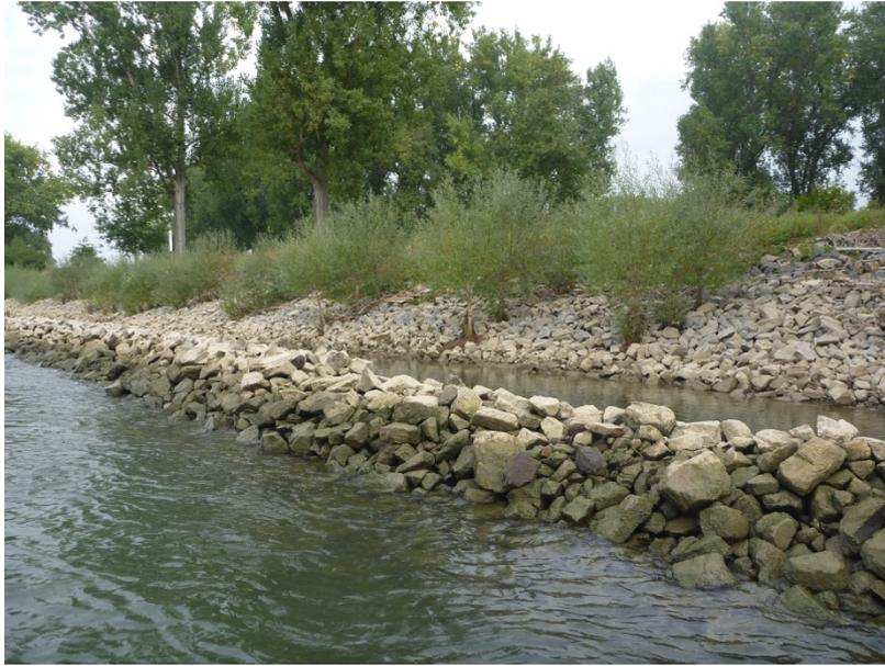
Bild 1: Steinwall, wellenschlaggeschützte Wasserzone und begrünte Steinschüttung
