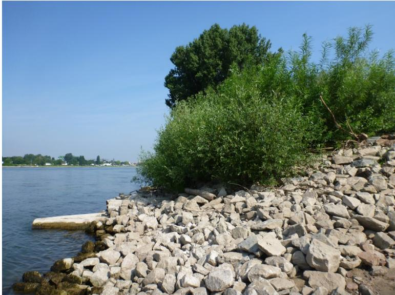
Bild 32: Weidensetzstangen in Steinschüttung oberhalb der Baumstammfächerbuhne (15.7.13)
