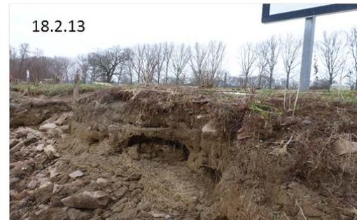
Bild 28: VF 9 nach Februarhochwasser (links) und durch Erosion weiter ausgeprägte Böschungsabbruchkante unmittelbar am Flusskilometrierungsschild, rechts
