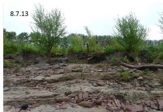
Bild 29: Höchststand der Wasserstände am 4.6.13; Einstau der gesamten neuen Ufersicherungsmaßnahmen (links); unterstromig bis zur vorderen Reihe der Steckhölzer erodierter Bereich, rechts.
