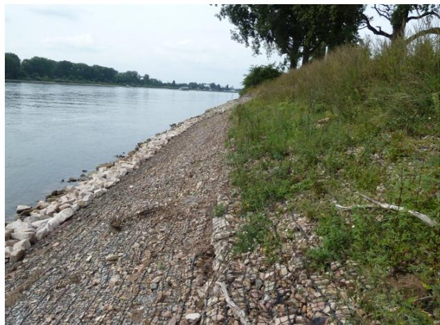
Bild 18: VF 5b nach Entfernung der Pflanzmattenauflage am 26.8.13
