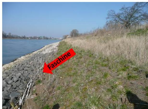
Bild 23: VF 7 nach der Sanierung mit Wasserbausteinen bis auf Höhe der Faschinen (Blick nach Unterstrom; 10.3.14)
