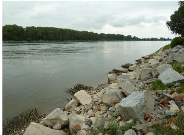
Bild 14: Austrag von Feinmaterial im oberen Böschungsbereich (26.8.13)
