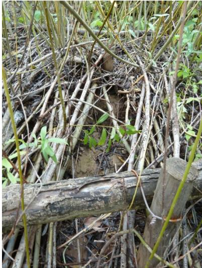
Bild 7: Infolge des Hochwassers angehobenes Riegelholz; Sedimentausspülung unter den Spreitlagen
