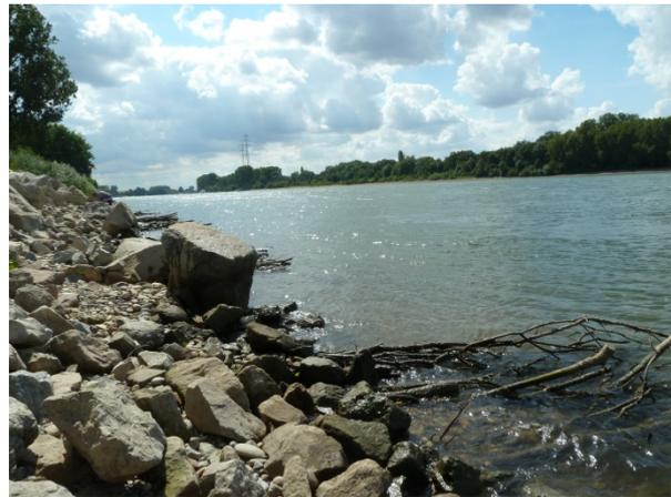
Bild 12: Austrag von Feinmaterial nach weiteren Hochwassern bis zum August 2013
