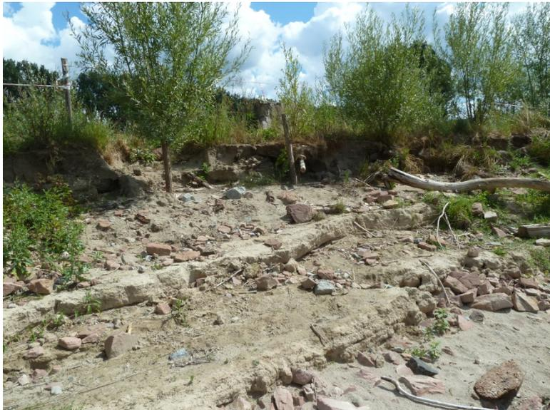
Bild 31: Auskolkungsbereich (oben) mit ausgeprägten Erosionsstufen; am Übergang zur Böschungsplanie freigespülte Weidensetzstangen (13.8.13)
