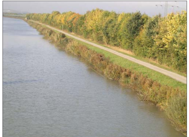
Bild 2: Schnelle Begrünung der Ufersicherung am MLK mit Alginate
