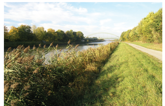
Mittellandkanal, linkes Ufer, km 189,50 bis km 190,00 (Röhrichte im Schutze einer vorgelagerten Spundwand)
