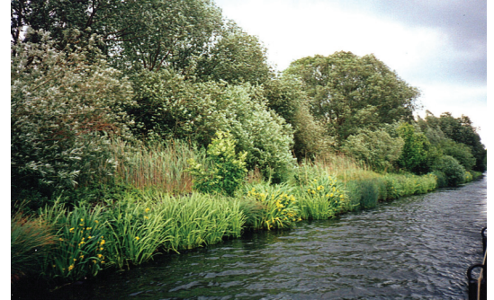
Untere Havel-Wasserstraße, rechtes Ufer, km 35,70 (Kammerdeckwerke)
