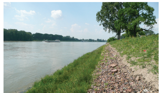
Rhein, rechtes Ufer, km 441,00 bis 441,05 (Röhrichtgabionen und Steinmatratzen)
