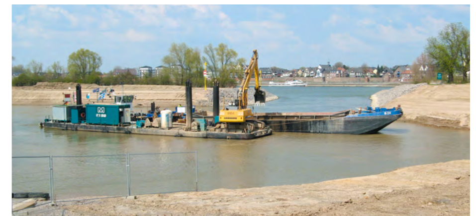
Bild 4: Nassbaggerung in der Flutmulde; im Hintergrund befindet sich die fertiggestellte Fährschneise und auf der gegenüberliegenden Rheinseite liegt die Stadt Rees.
