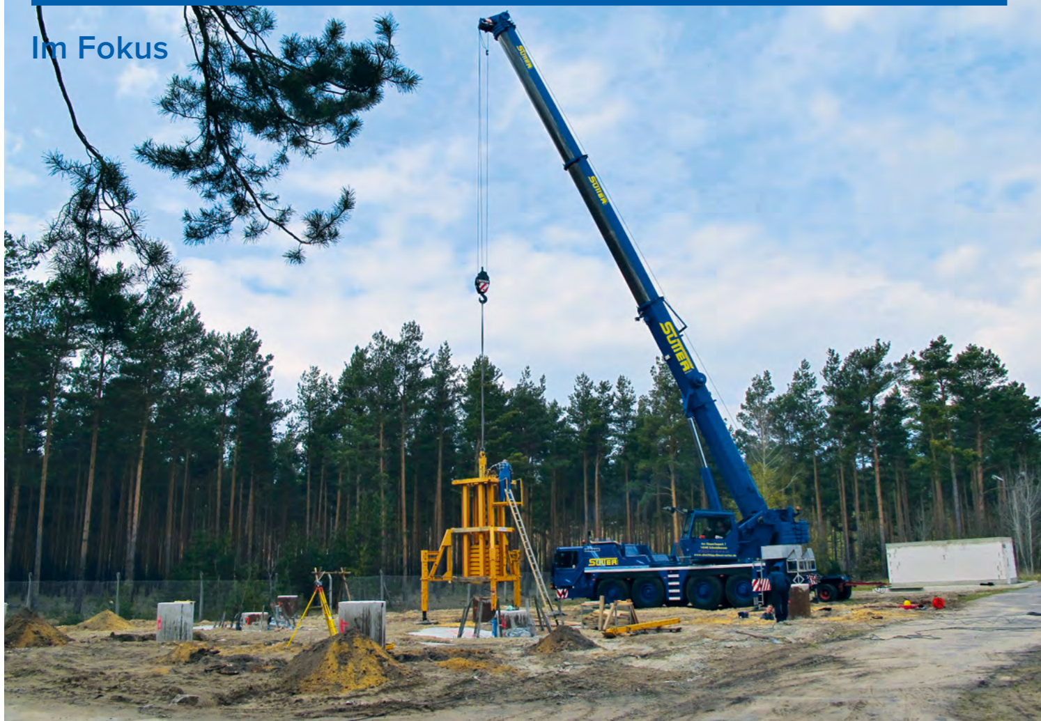
Bild 1: Aufbau eines 11t schweren Fallgewichts.
