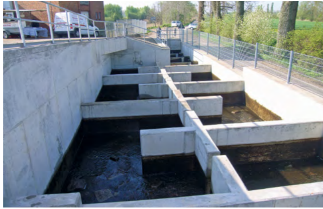
Neue Fischaufstiegsanlage an der Schleuse Lewitz, Blickrichtung vom Oberwasser zum Unterwasser.
