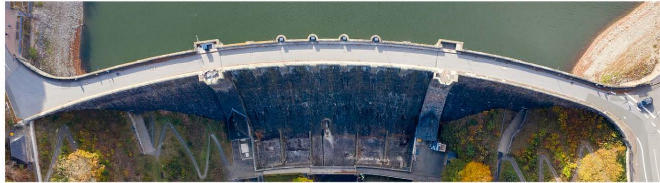
Bauwerke sind so zu bemessen und zu unterhalten, dass ihre Sicherheit über die gesamte Nutzungsdauer gewährleistet ist. Bei Staumauern wird im Allgemeinen eine Nutzungsdauer von 100 Jahren angesetzt. Diese Zeitspanne wird nun bei der Diemeltalsperre erreicht.
