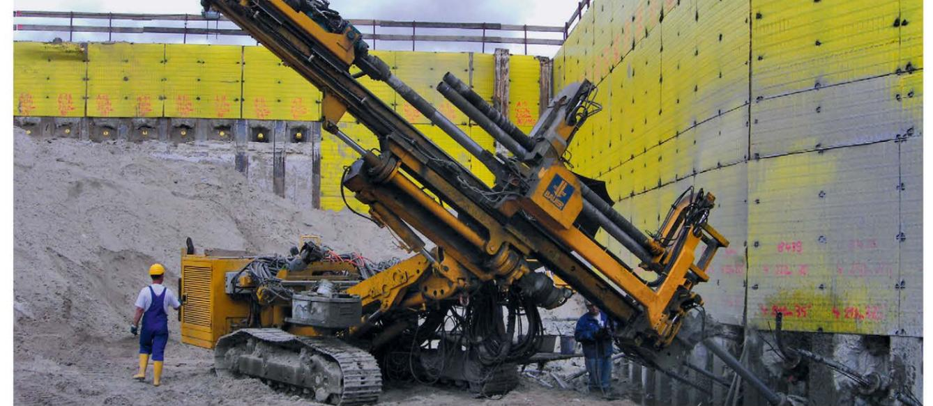
Bild 1: Herstellung von Verpressankern für die Baugrube der Schleuse Wusterwitz
