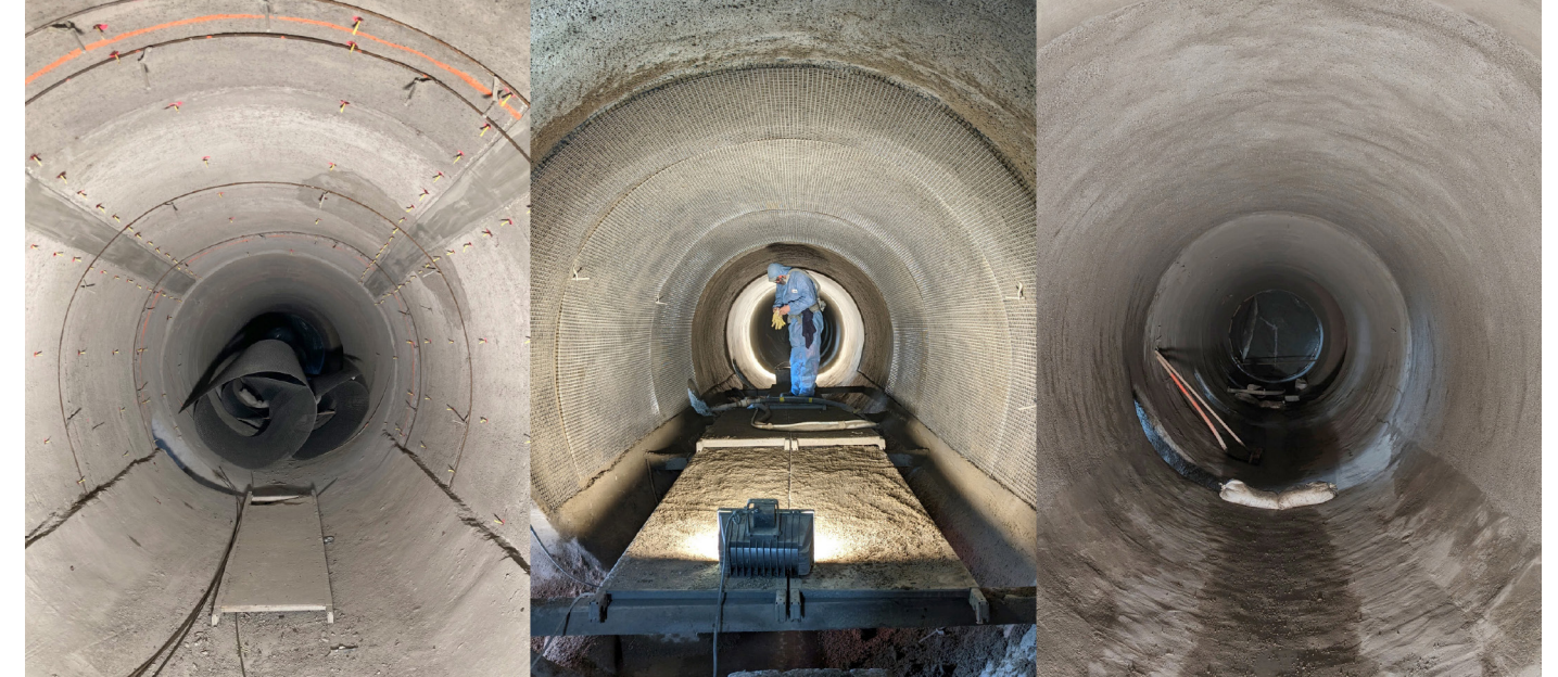
Bild 1: Instandsetzung des Umlaufkanals der Schleuse Anderten mittels textilbewehrter Spritzbetonschichten
